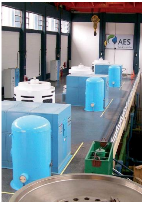
Vista de la central con los tres grupos generadores de la misma, vista del rotor de una de las turbinas Francis
