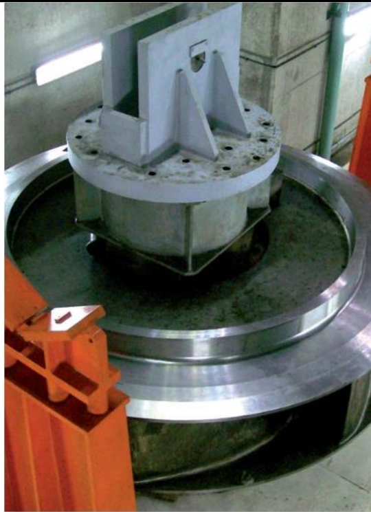
Vista de detalle de uno de los rodetes de las turbinas de la central de Cerro Pelado
