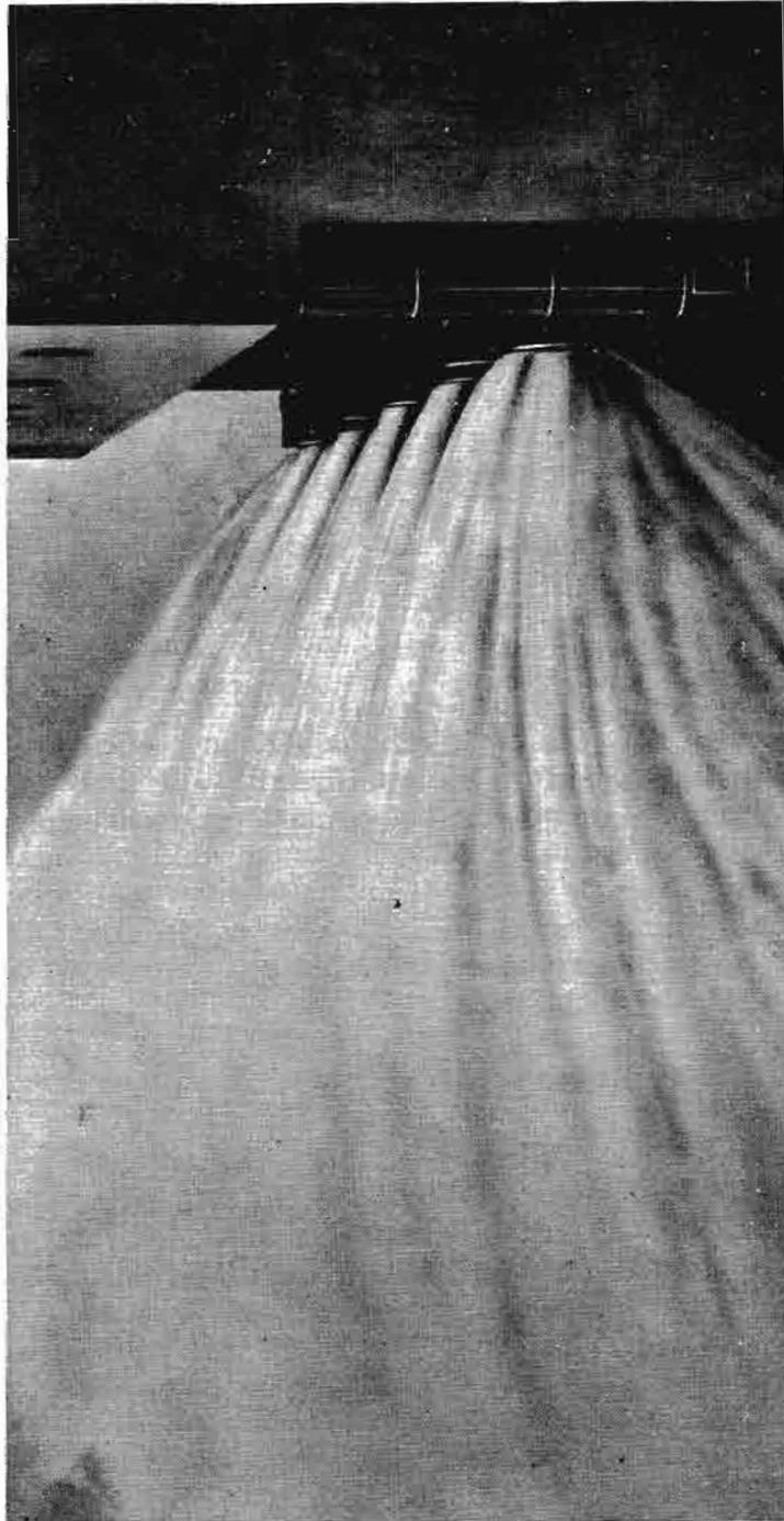
**Fig. 8.4** Válvulas de descarga libre. (Cortesía Allis Chalmers.)
