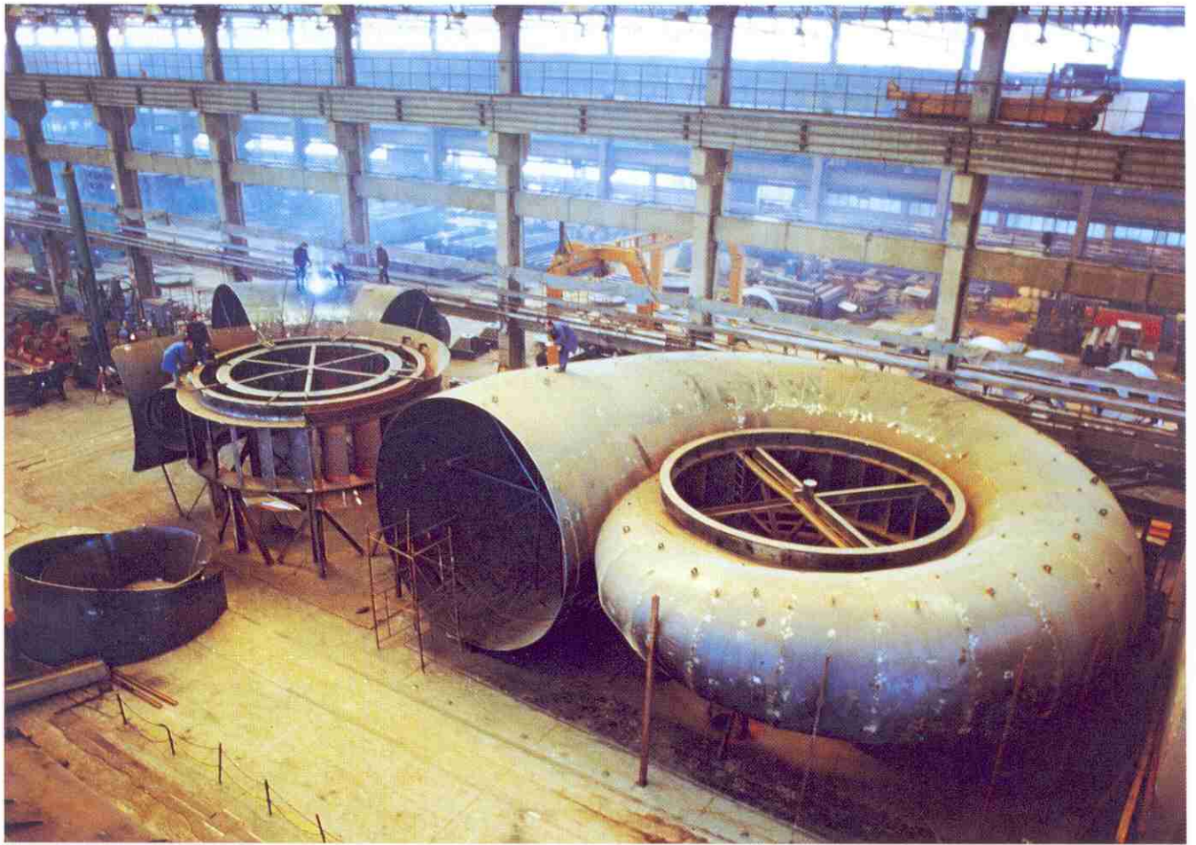
3. Prémontage des diffuseurs en ateliers (photo Hydro Vevey).
