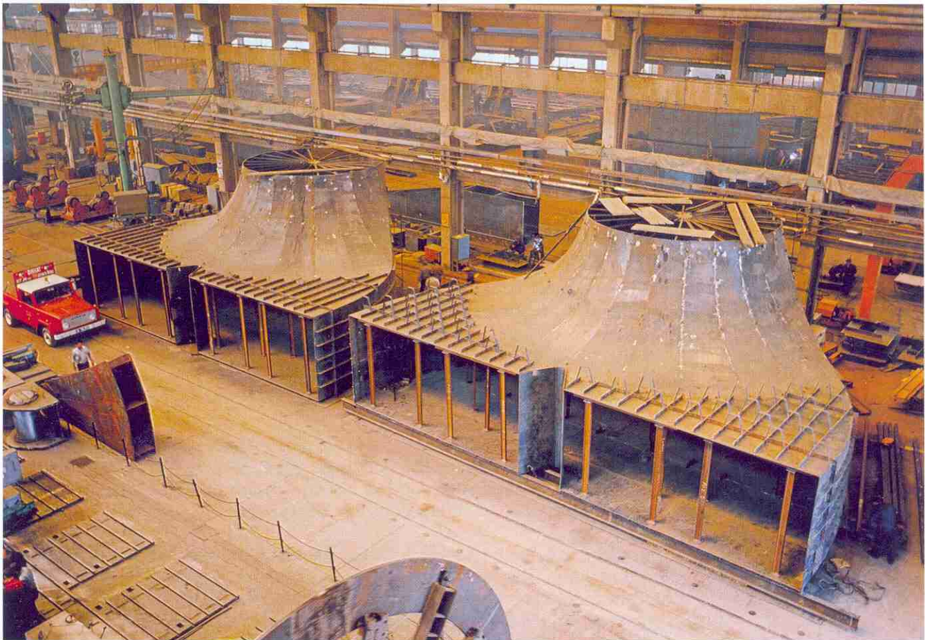
2. Bâche spirale et avant-distributeur en cours de prémontage en ateliers (photo Hydro Vevey).
