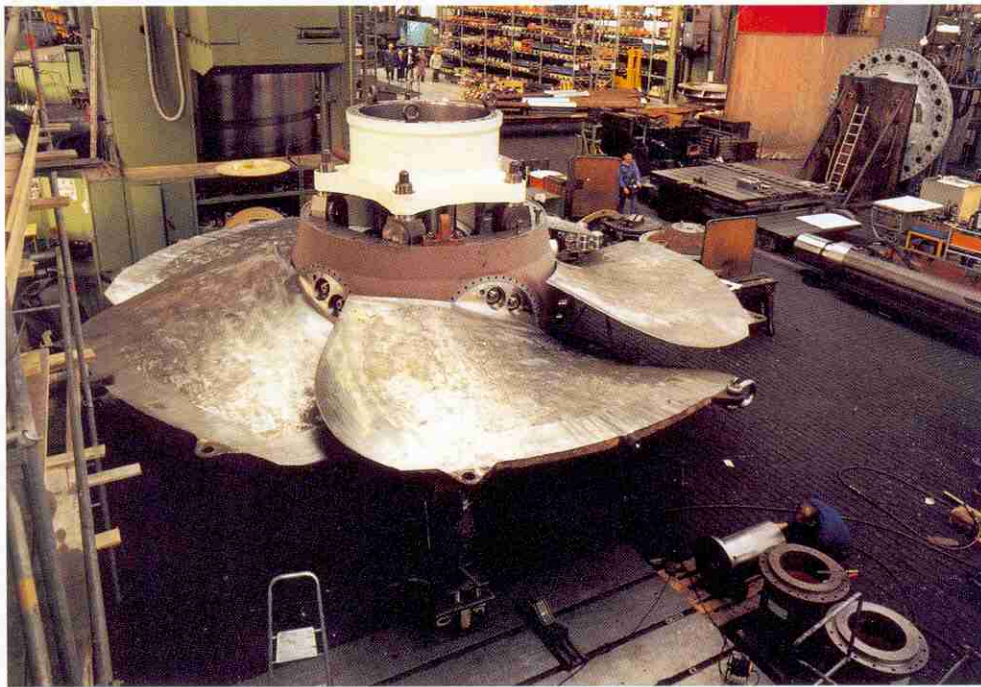
2. Roue en prémontage à l'atelier. On distingue les boulons de fixation des aubes sur les tourillons ainsi que le croisillon de commande des aubes (photo Voith).
