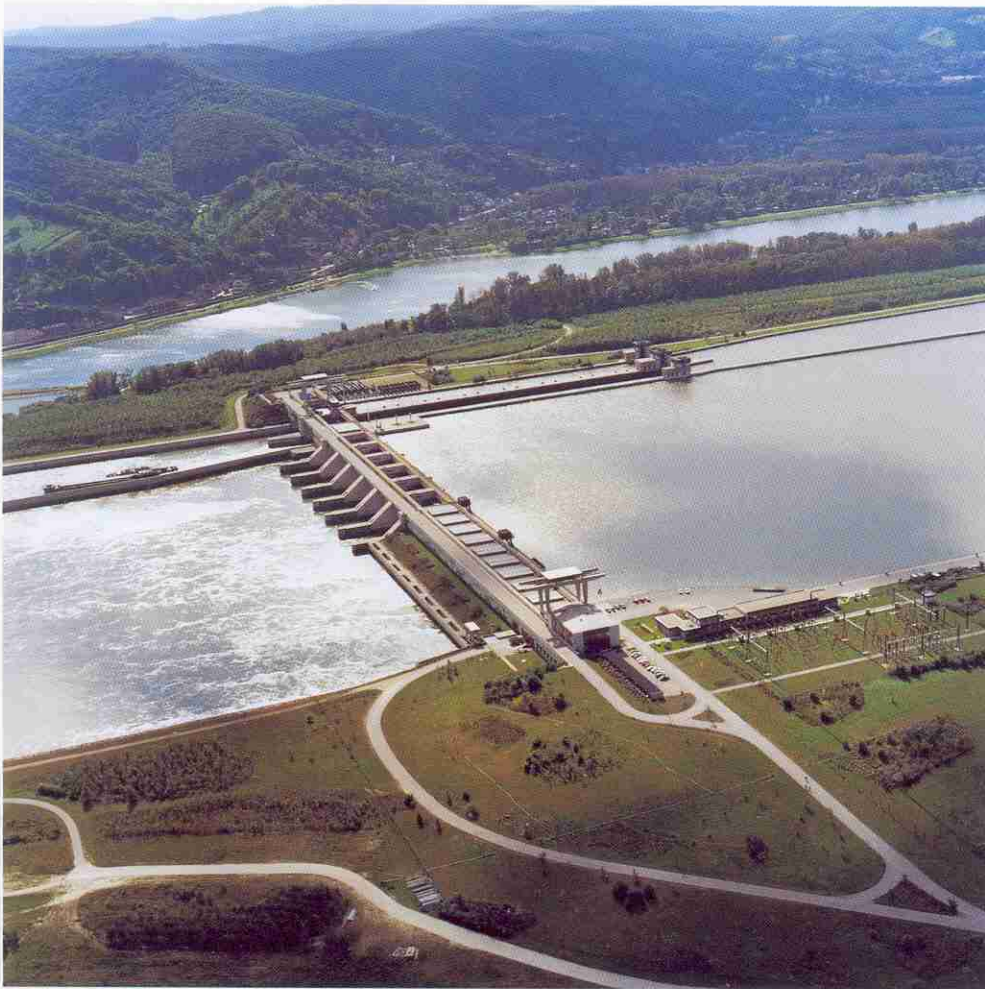
1. Vue d'ensemble du barrage avec la centrale, l'évacuateur de crues et l'écluse (photo DoKW).
