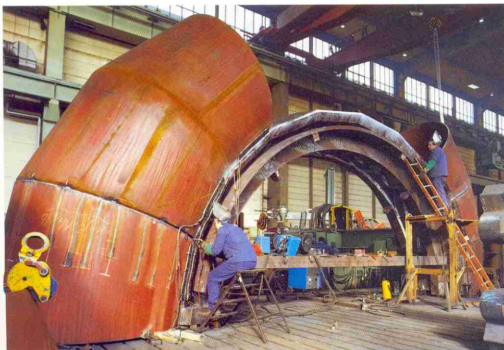
7. Bâche spirale en cours d'assemblage avec l'anneau d'entretoises (photo Voith).
