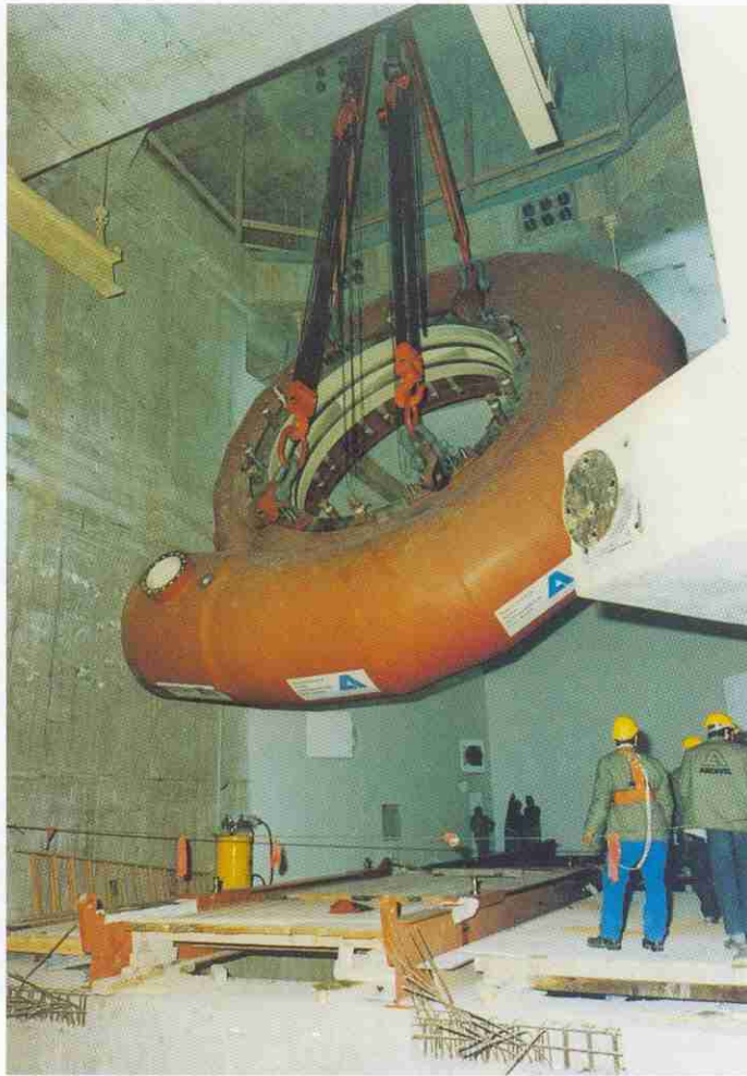
7. Bâche spirale et avant-distributeur en cours de montage en centrale (photo Andritz).
