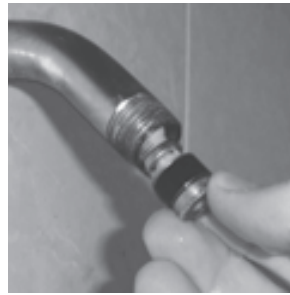
Los protectores de quemaduras cierran el flujo del agua si la temperatura de la misma llega a ser demasiado alta.
