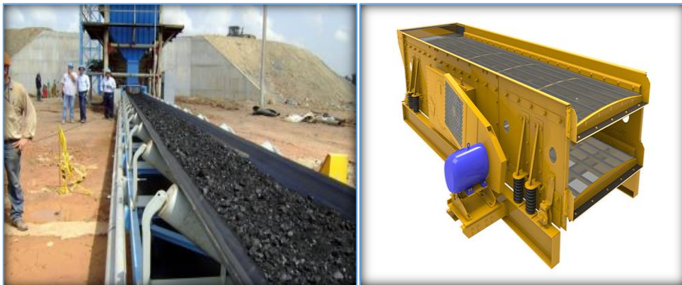
Figura 4. Bandas transportadoras con sistema de zarandas.
