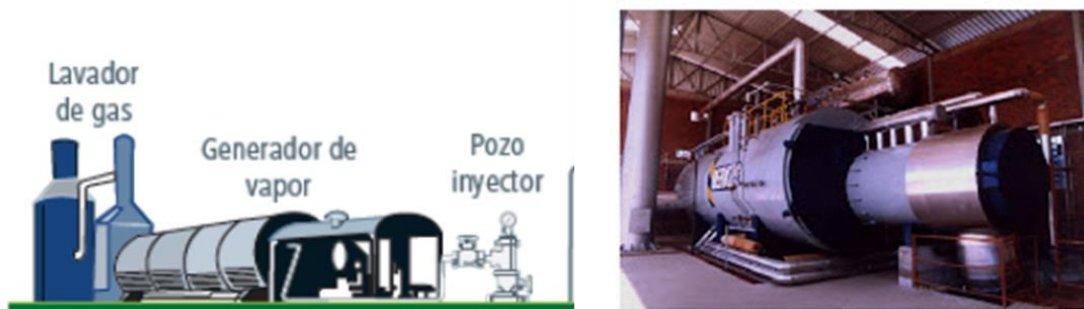
Figura 2. Generador de Vapor.
