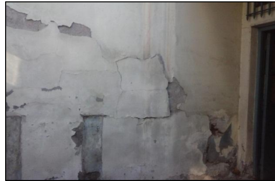
iv. Desprendimiento del material
