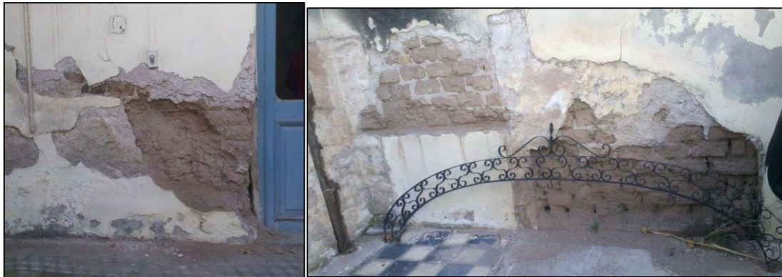
iv. Desprendimiento del material
