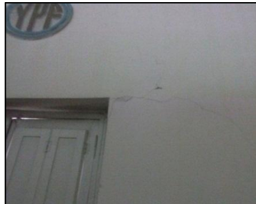
iii. Fisuras en esquina de marcos
