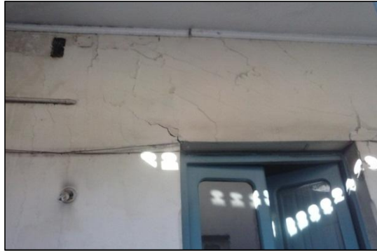
iii. Detección de humedad
