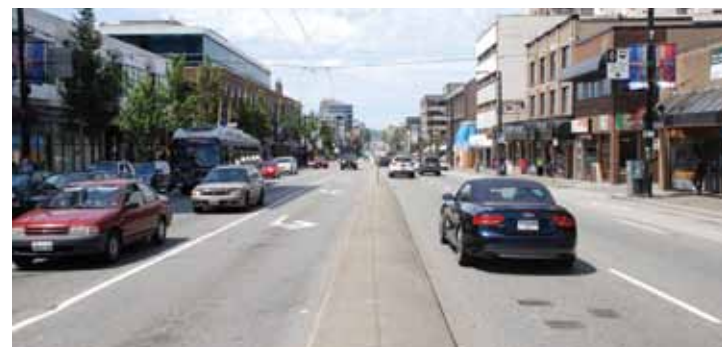
EJEMPLO DE AVENIDA DE 24 MTS CON DOS MANOS BROADWAY AVENUE EN SEATTLE
