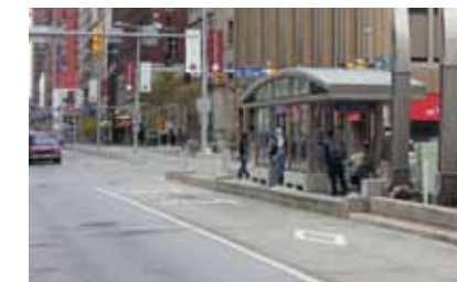
ESTACIÓN BRT, HEALTH LINE EN CLEVELAND, EE. UU.
