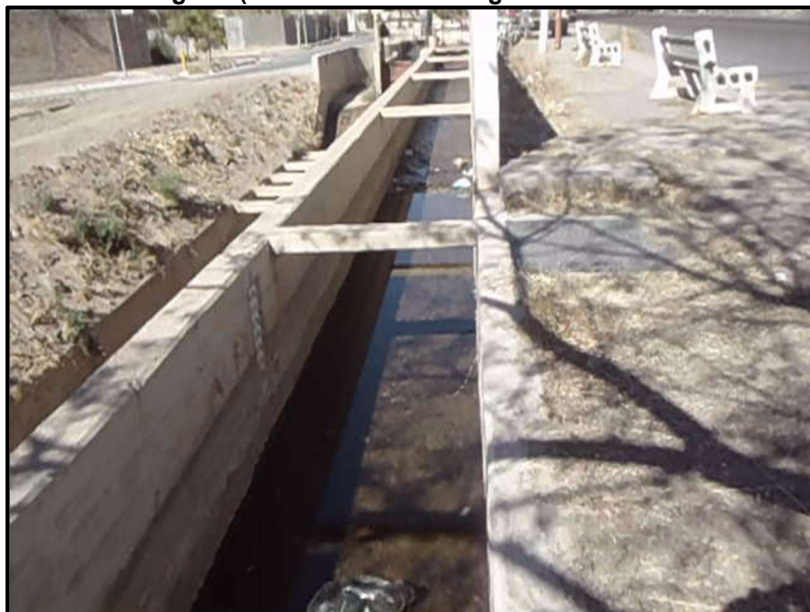
Figura 5.52. Vertedero y regla limnimétrica para medición de caudales
