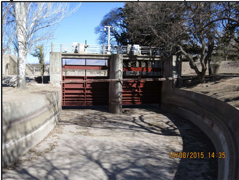
Figura 5.48. Sección de control del Dique Valle de Uco sin agua
