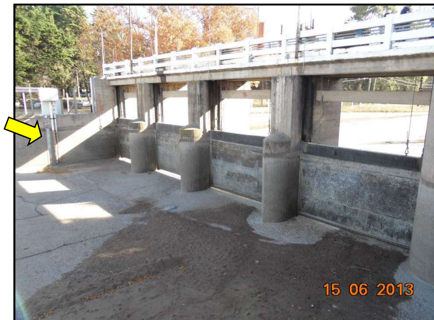
Figura 5.40. Vista desde aguas arriba y desde margen derecha de las compuertas de riego del Dique Cipolletti, con indicación de la escala limnimétrica
