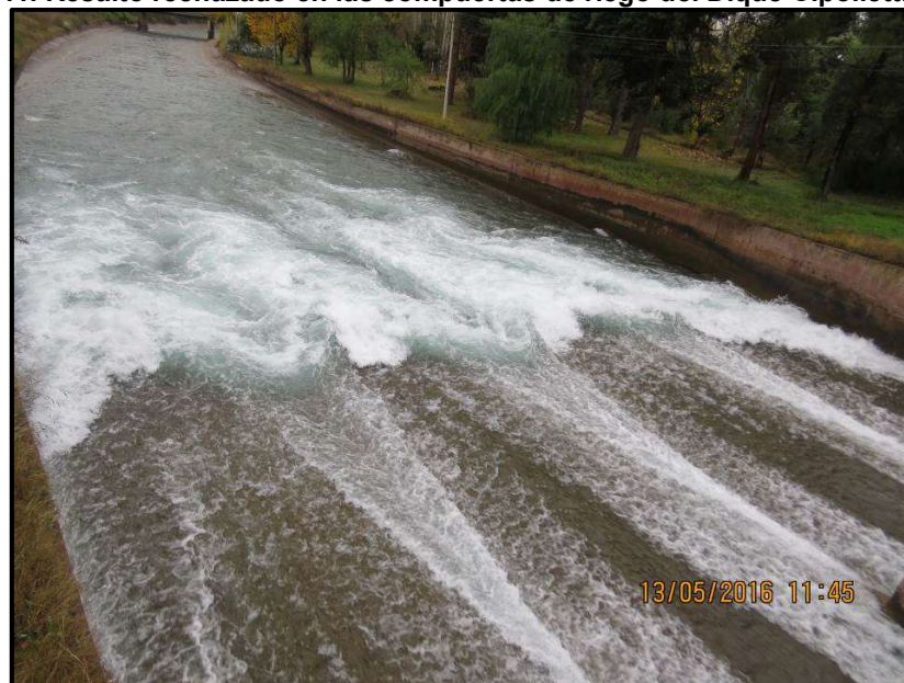
Figura 5.42. Vista desde arriba del resalto rechazado en las compuertas de riego del Dique Cipolletti (2016)
