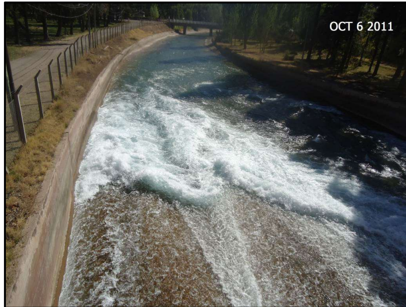
Figura 5.39. Resalto rechazado en el canal de derivación de riego del Dique Cipolletti
