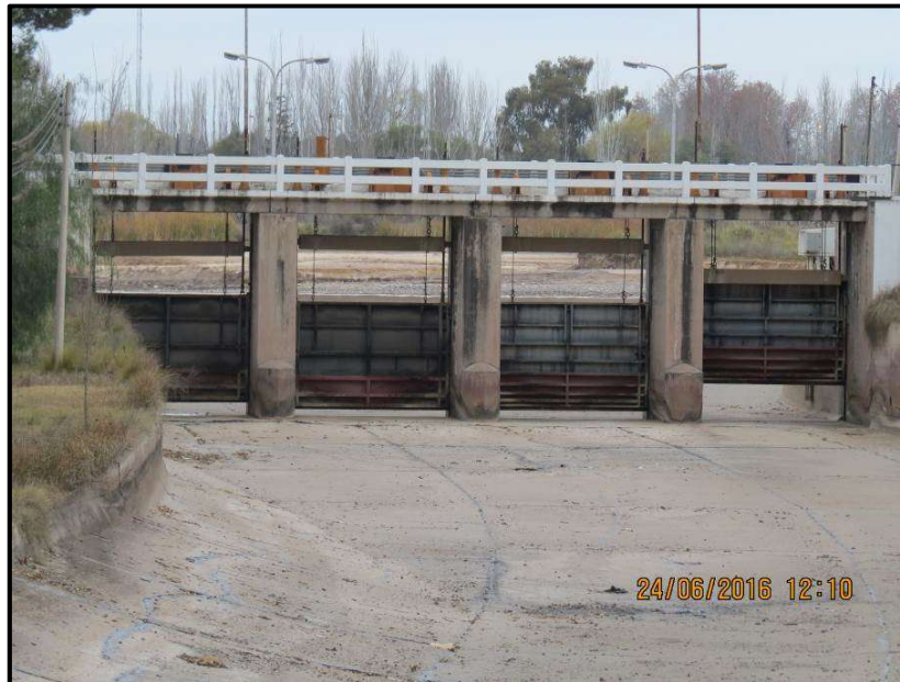
Figura 5.36. Vista desde aguas abajo de las compuertas de riego del Dique Cipolletti (vacío)
