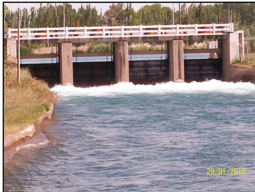
Figura 5.35. Vista desde aguas abajo de las compuertas de riego del Dique Cipolletti
