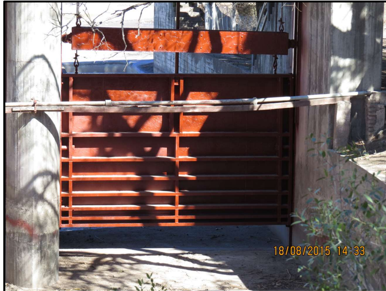
Figura 5.49. Vista desde aguas abajo de la compuerta de la sección de control del Dique Valle de Uco
