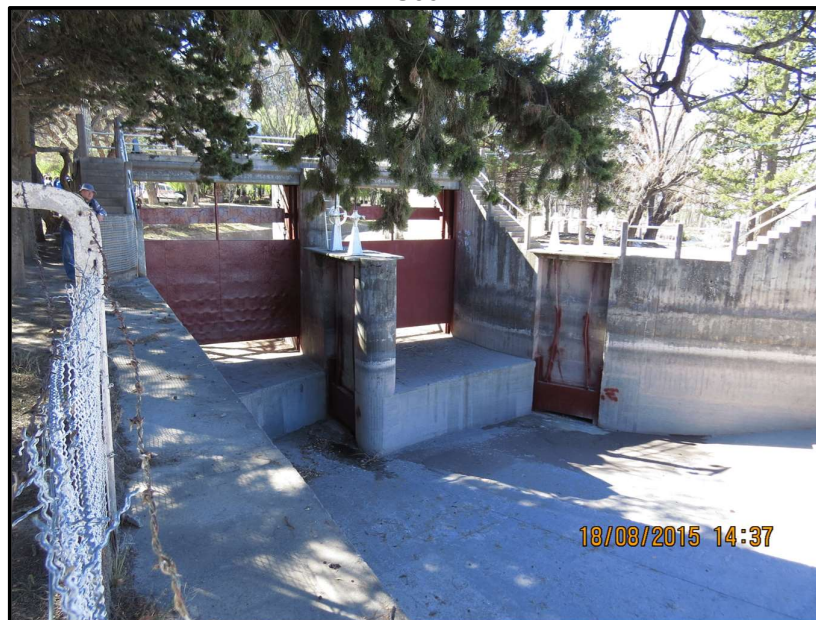
Figura 5.50. Compuerta de limpieza del material depositado en el Dique Valle de Uco
