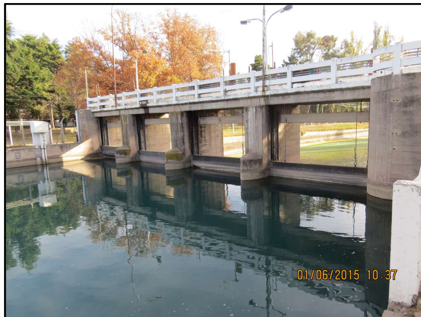
Figura 5.33. Vista aguas arriba compuertas de riego del Dique Cipolletti
