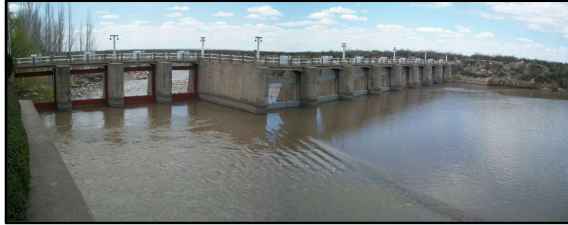
Figura 5.45. Vista general del Dique Valle de Uco
