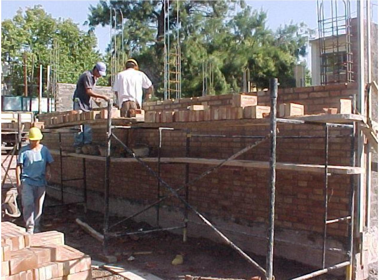
**Imagen 1.** Andamio Metálico, tubular de un cuerpo, plataforma tablón madera. Construcción muro.
