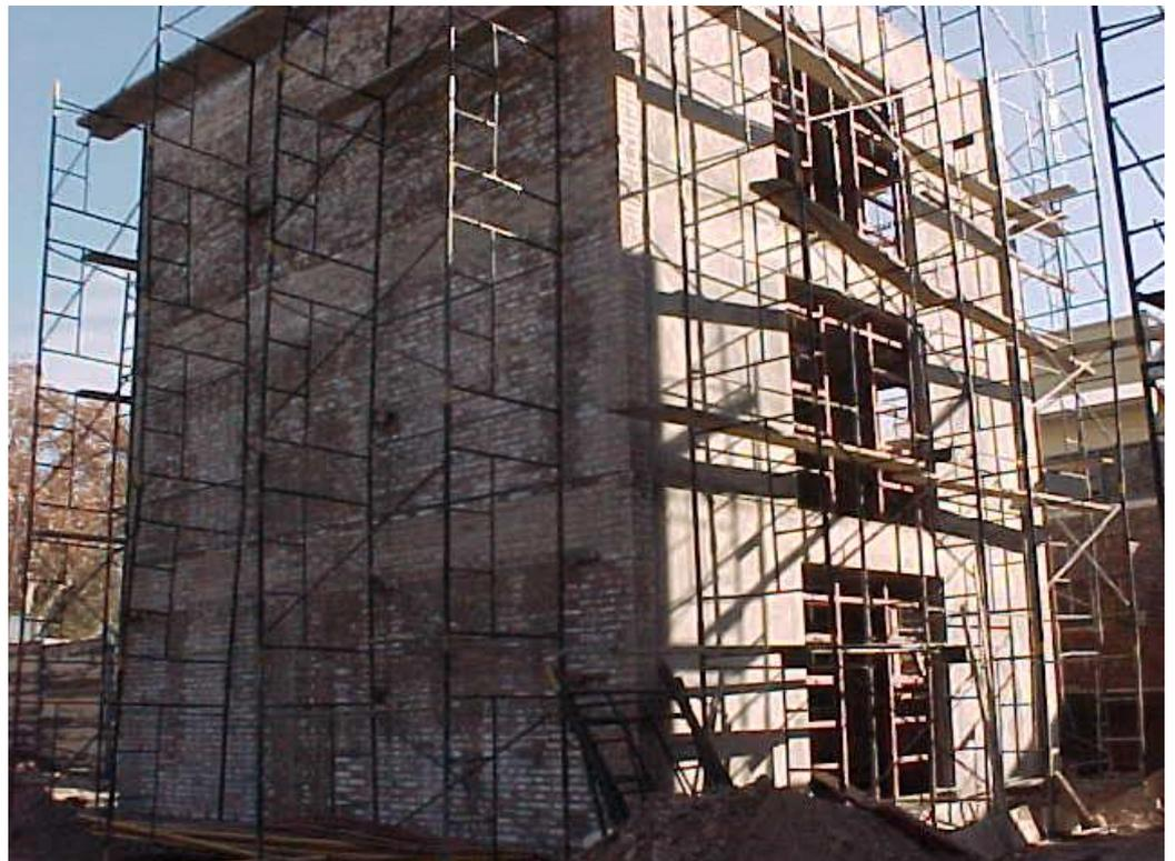
**Imagen 3.** Andamio Metálico de cinco cuerpos. Revoque de muro
