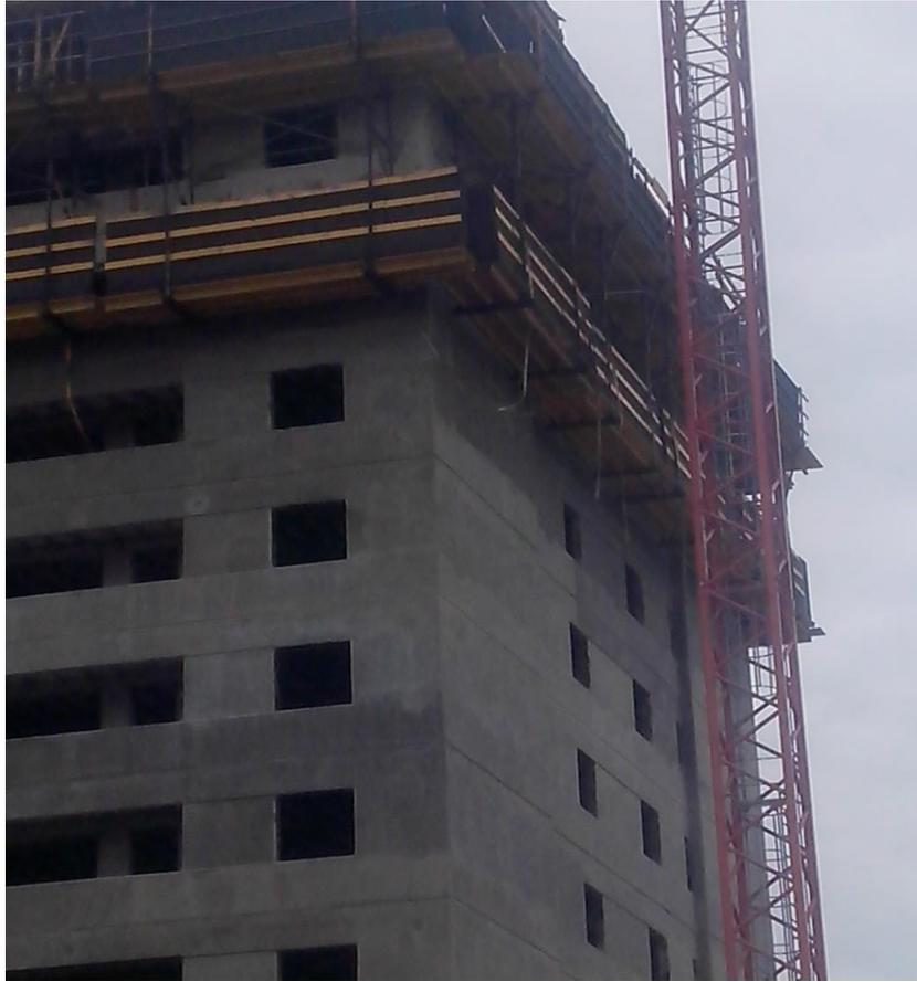
**Imagen 5 .** Andamio para construcción en pisos superiores.
