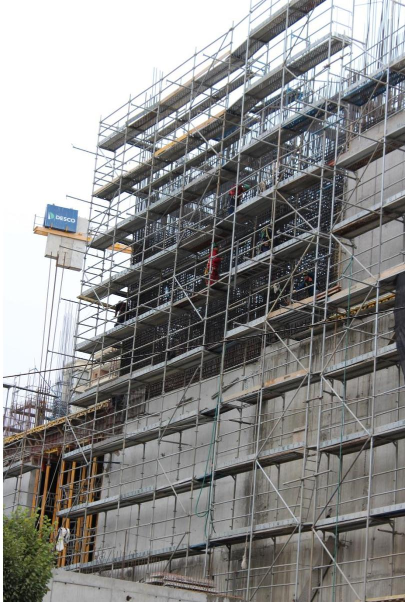
**Imagen 7.** Cuerpos de andamio que cubren la fachada completa para construcción obra gruesa y terminaciones.
