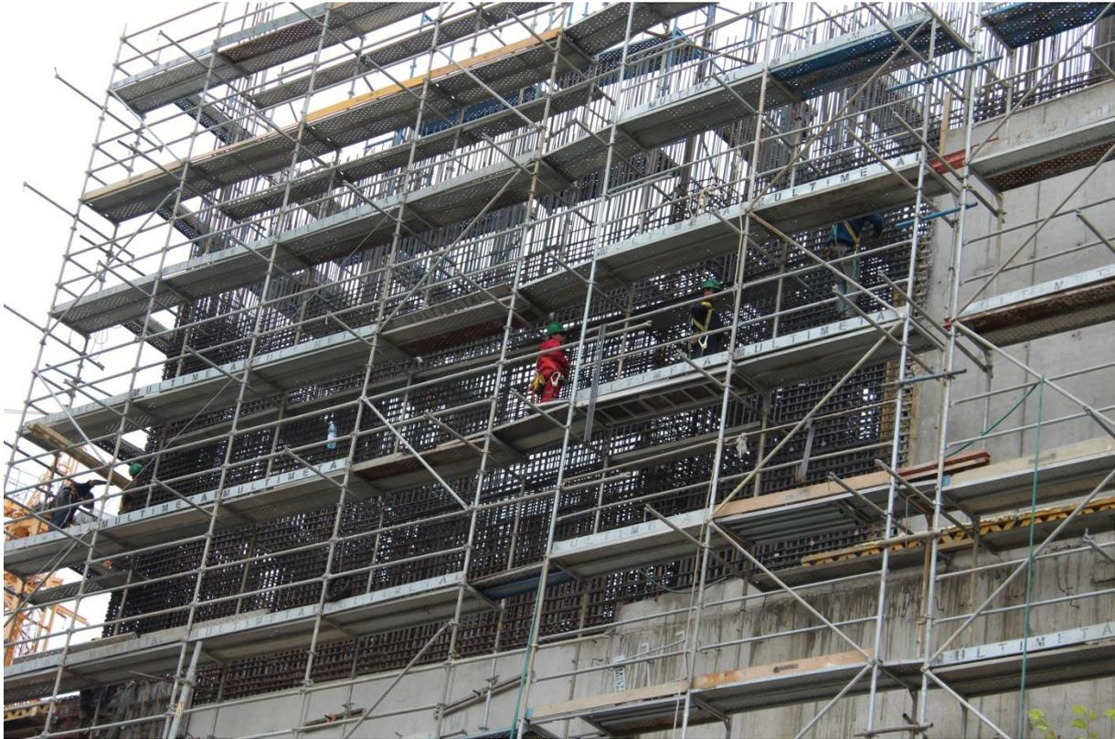
**Imagen 8 .** Cuerpos de andamio que cubren la fachada completa para construcción obra gruesa y terminaciones. Con plataformas metálicas (sector circulación y trabajo personas)
