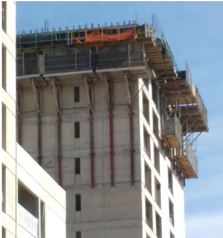
**Imagen 6 .** Andamio para construcción en pisos superiores.
