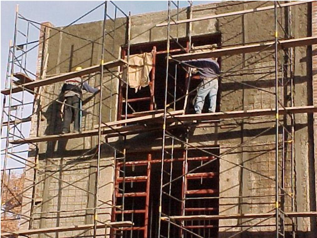
**Imagen 2.** Andamio Metálico de cuatro cuerpos. Revoque de muro
