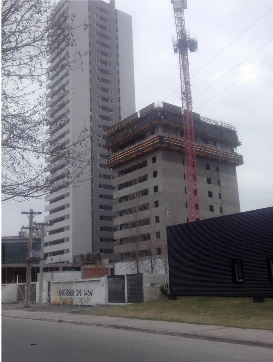
**Imagen 4 .** Andamio para construcción de torres, pisos superiores.
