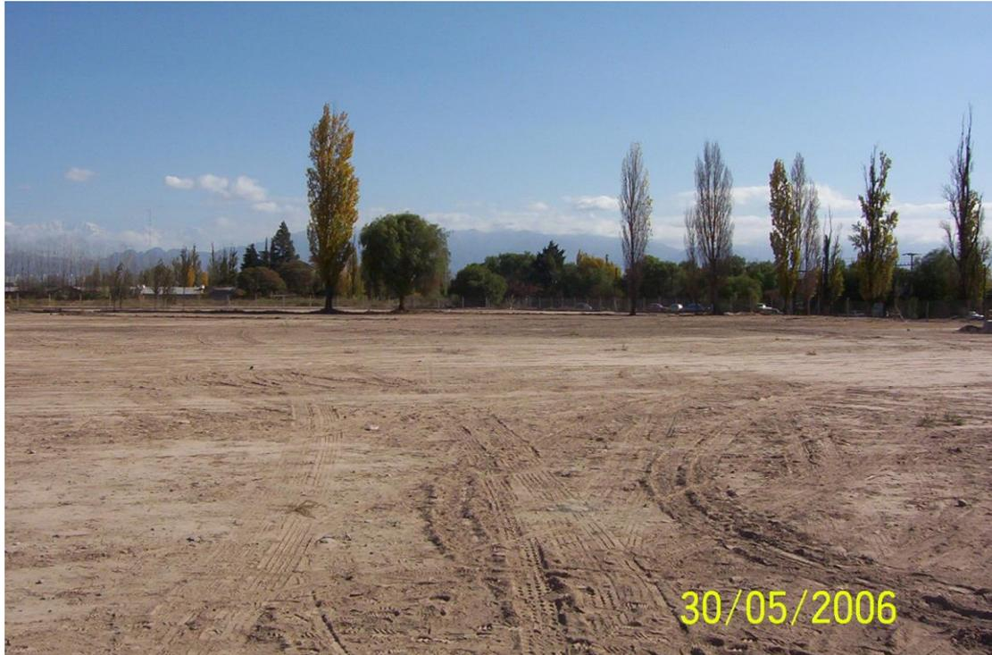
**Foto 6.** Preparación del terreno (limpieza y nivelación), listo para comenzar el replanteo.
