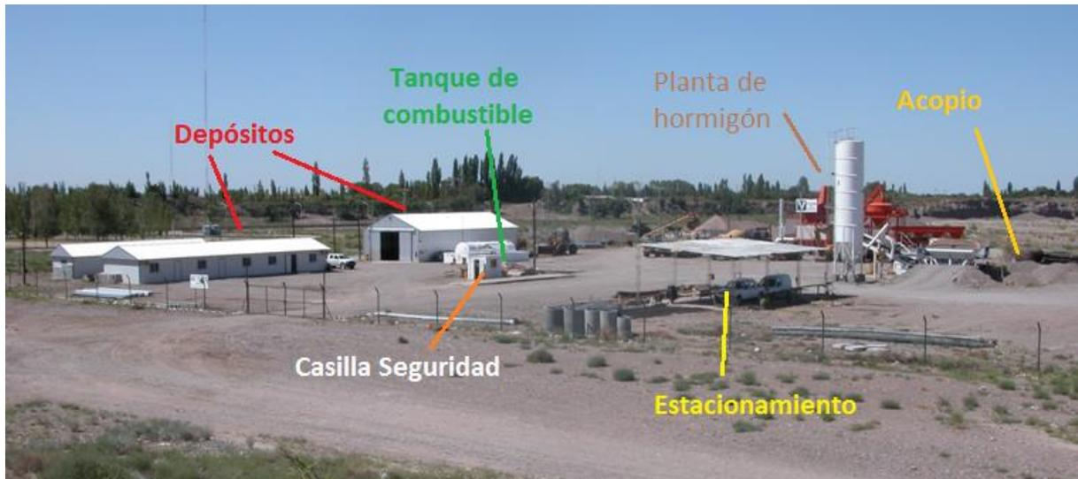
Foto 3. Vista del Obrador para un proyecto civil.
