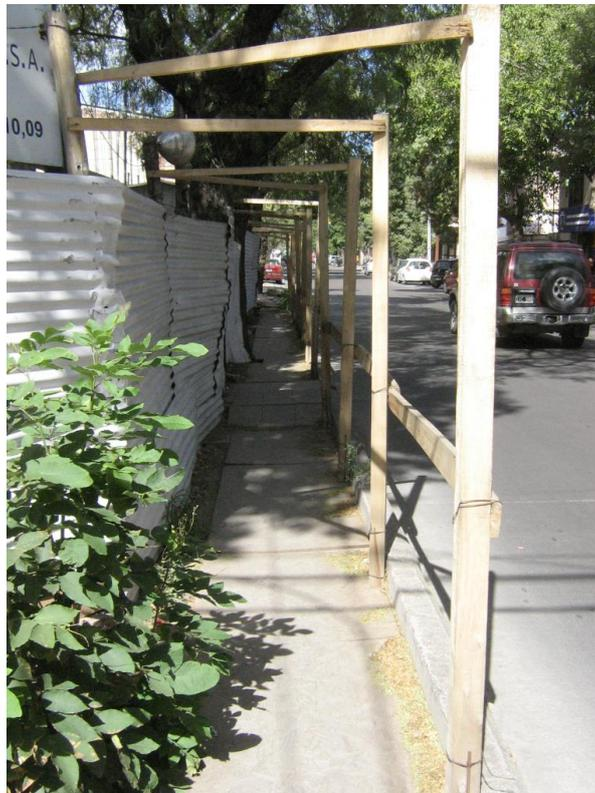
**Foto 8.** Vista de la circulación peatonal protegida, sobre vereda existente.
