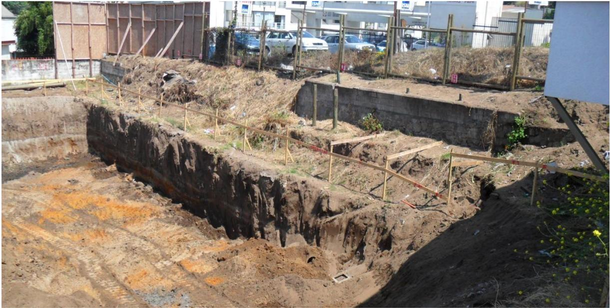
**Foto 10.** Replanteo de un subsuelo mediante corralito.
