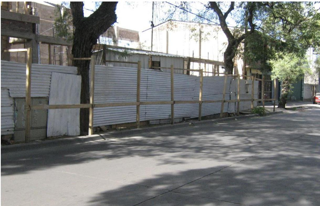
**Foto 7.** Cierre provisorio de chapa metálica.
