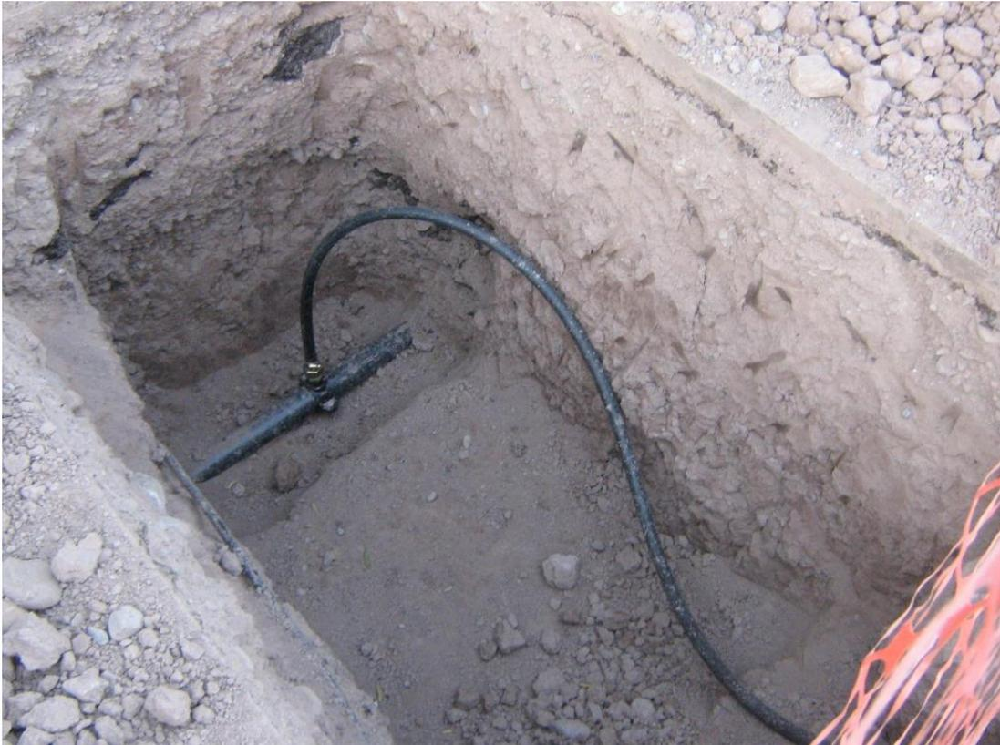
**Foto 16.** Conexión a la red de distribución de agua potable.
