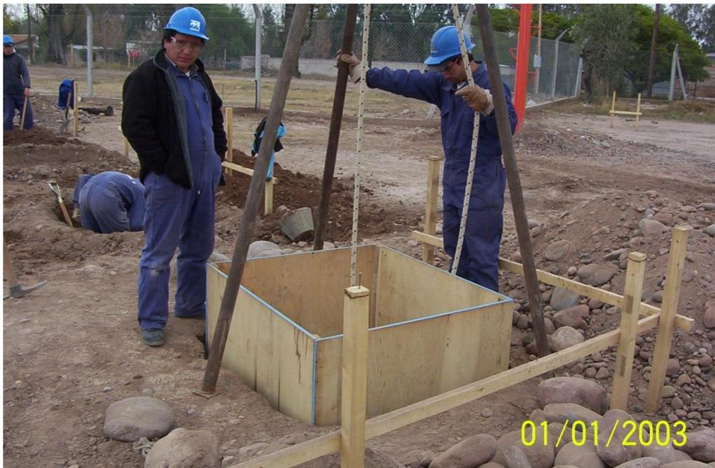
**Foto 7.** Replanteo de una base mediante caballete doble.
