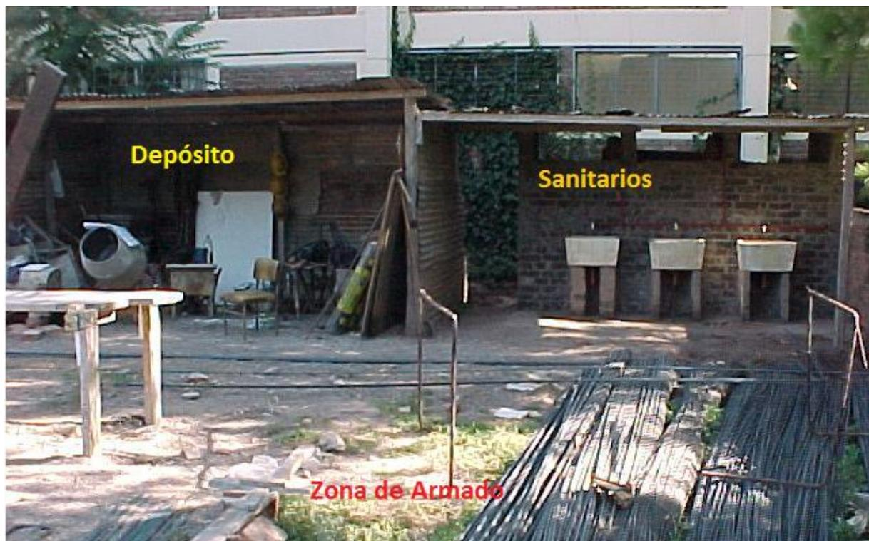
Foto 4. Visa general de la distribución de áreas en un Obrador para un proyecto edilicio.
