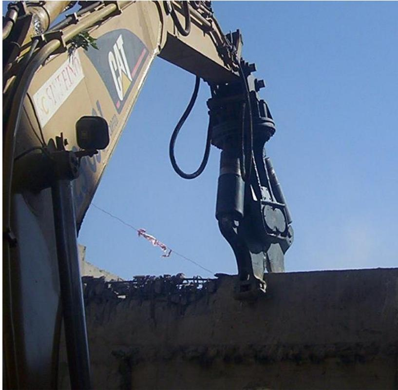
**Foto 1.** Equipo de demolición hidráulico de mandíbulas.
