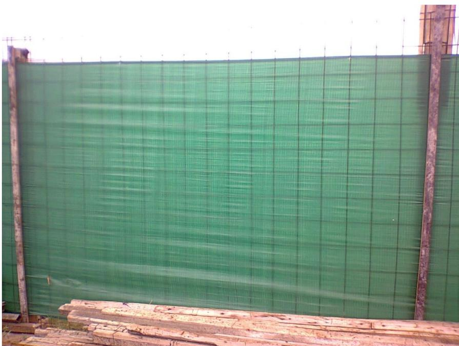
**Foto 9.** Cierre de obra provisorio de malla metálica y tela plástica.
