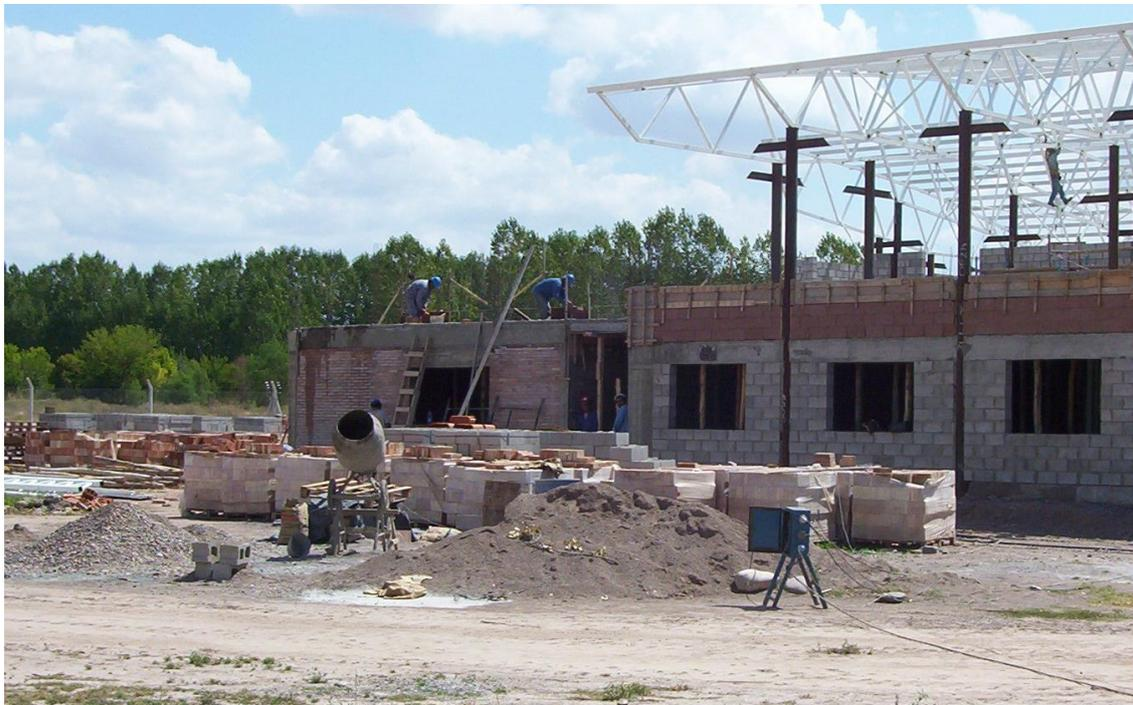
**Foto 27.** Zona destinada a la elaboración de hormigón (hormigonera, provisión de agua y electricidad) y acopio de materiales como áridos y ladrillos que no requieren estar bajo techo.
