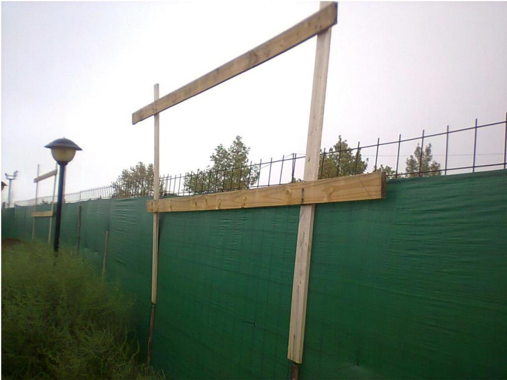
**Foto 8.** Replanteo mediante caballete simple apoyado sobre cierre de obra.
