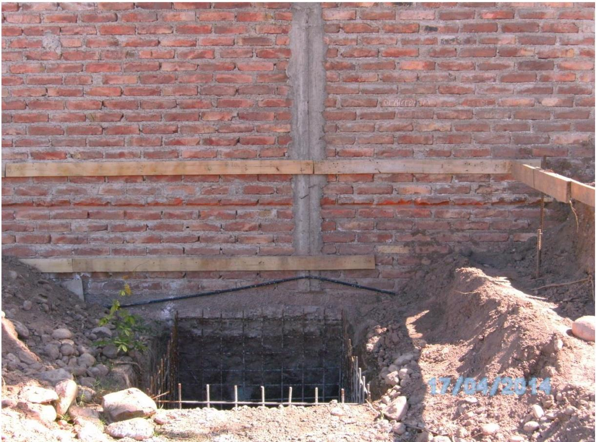
**Foto 11.** Replanteo de bases mediante corralito ubicado sobre pared medianera.
