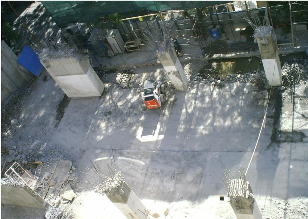
**Foto 4.** Columnas listas para demoler (ya retirada la losa).
