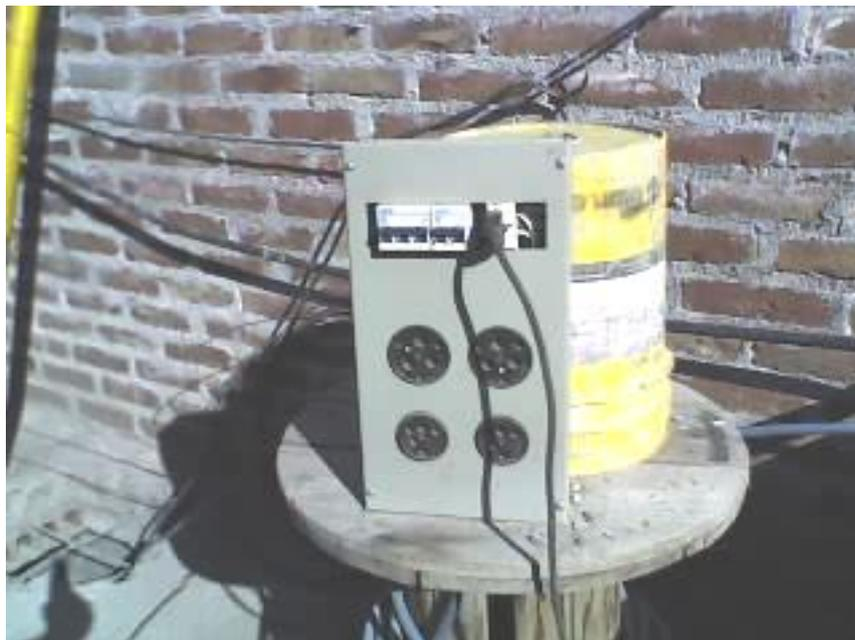
**Foto 2.** Colocación del alargador para conexión eléctrica, el cual debe estar sujeto a poste de madera o soporte fijo.
