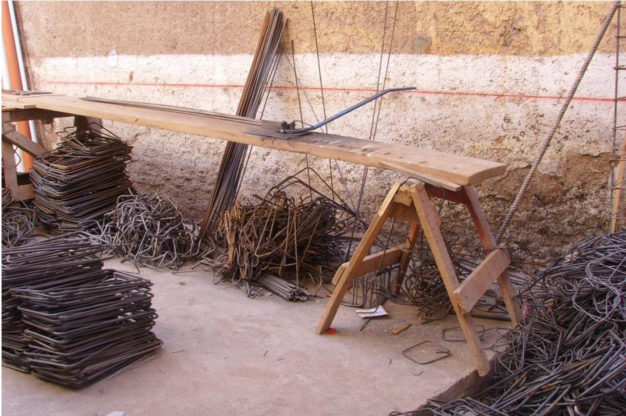
**Foto 26.** Zona de corte, doblado y armado para estructuras de hormigón armado (columnas, vigas, etc.)
