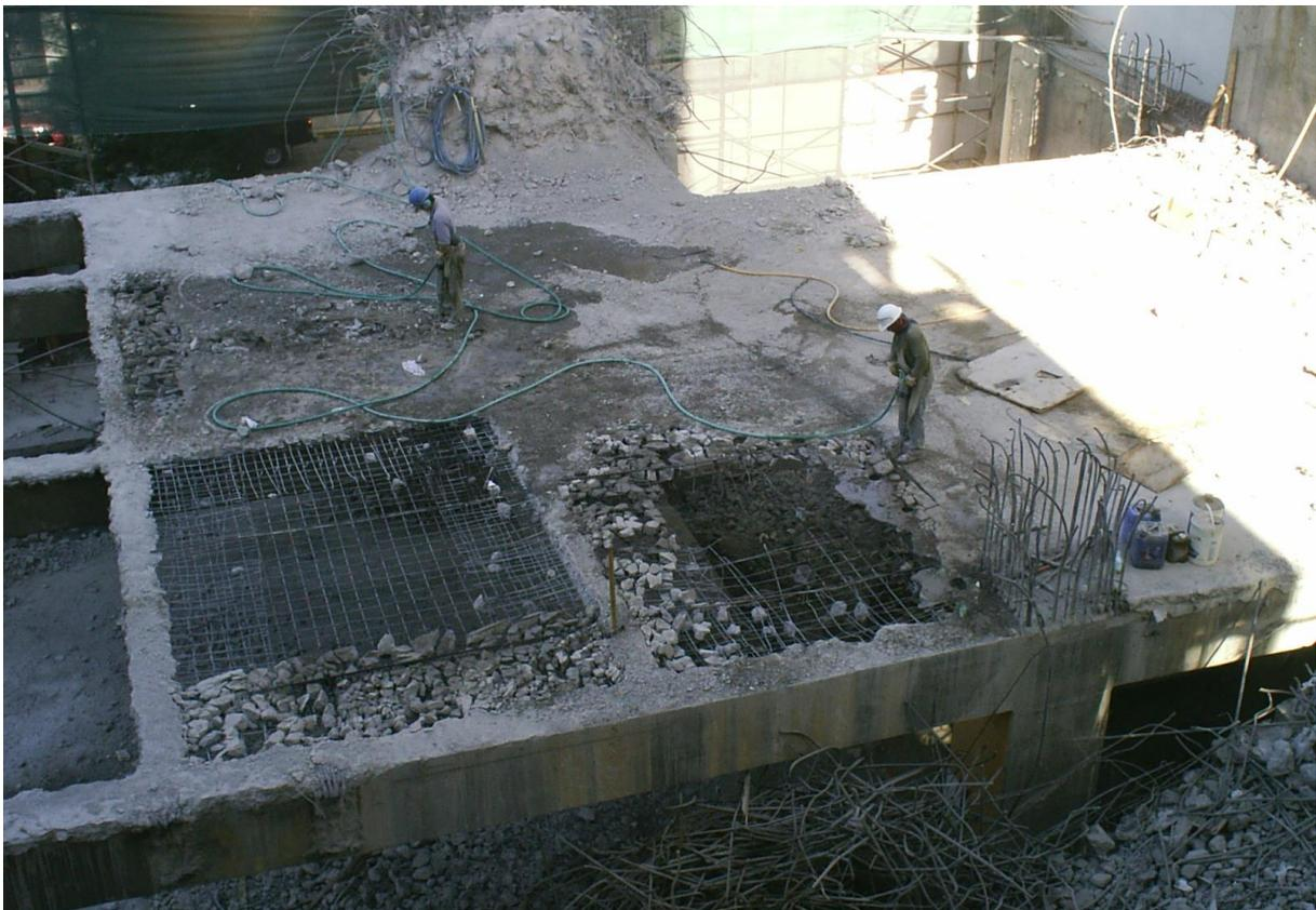
**Foto 3.** Demolición de una losa de H°A°.
