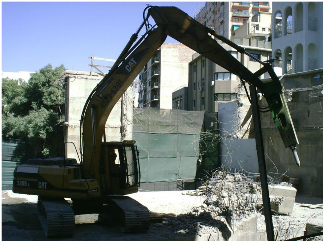
**Foto I.** Máquina de demolición estacionaria con martillo demoledor hidráulico.
