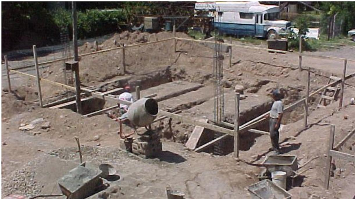
**Foto 9.** Replanteo de fundaciones continuas con método de corralito.
