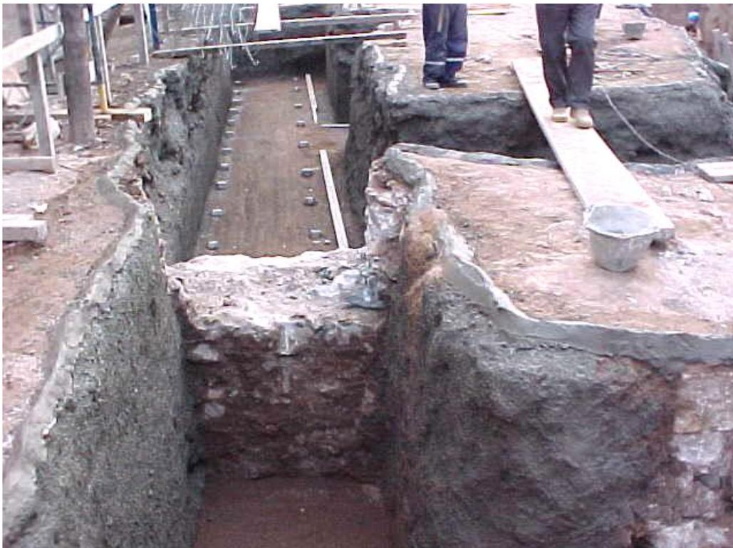
**Foto 5.** Excavación para fundaciones continuas
