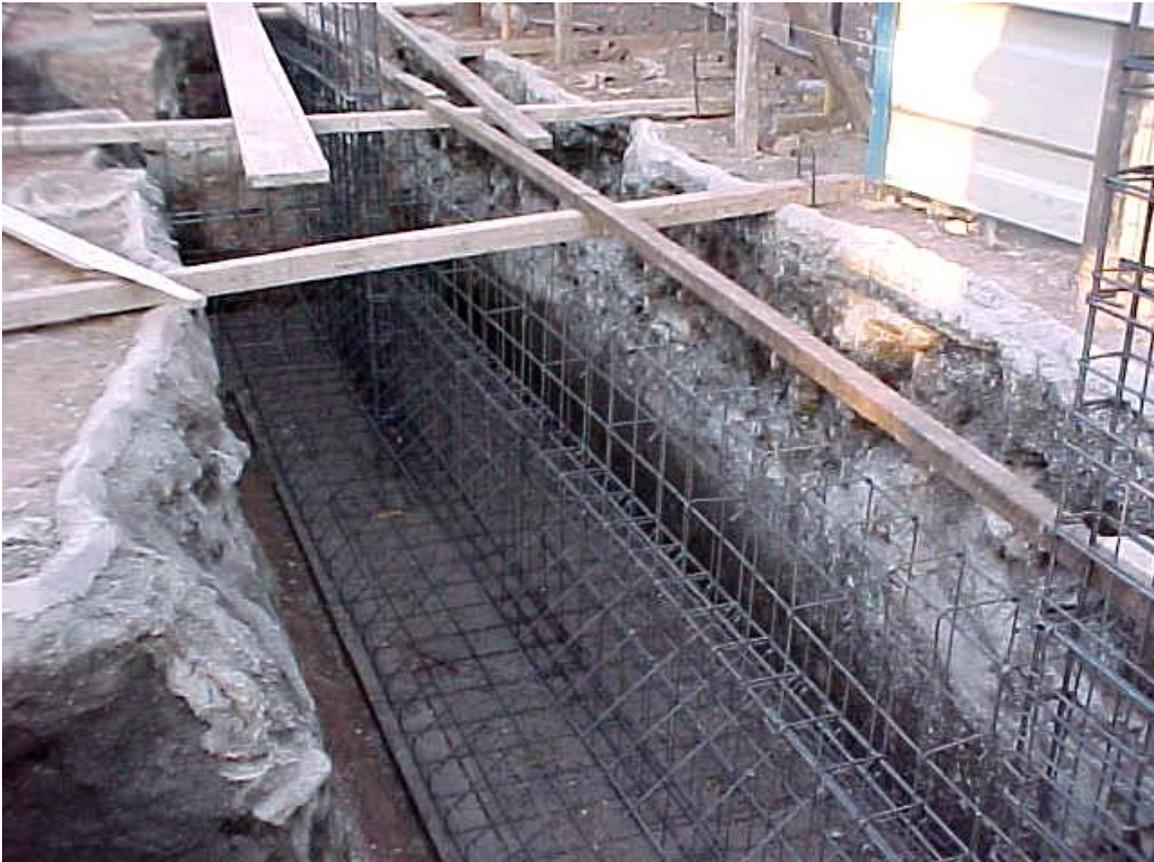
**Foto 22.** Armadura para zapata corrida de sección triangular.
