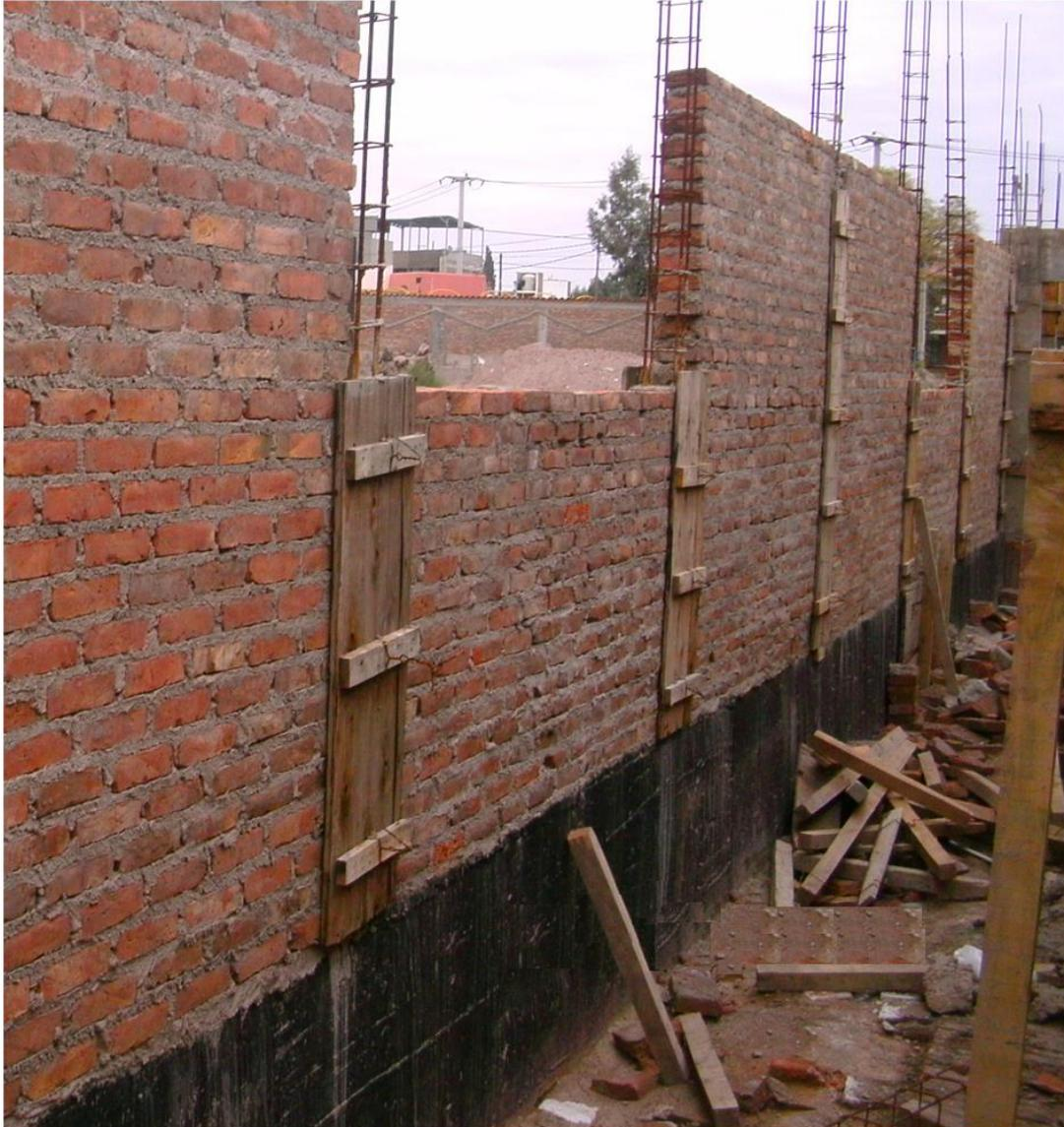
**Foto 38.** Aislación de la fundación con pintura asfáltica.
