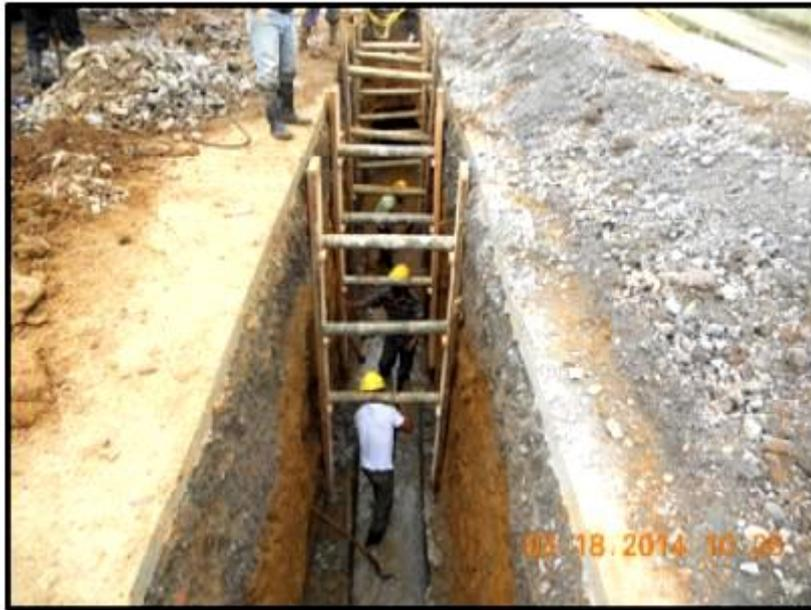
**Foto 8.** Excavación entibada.
