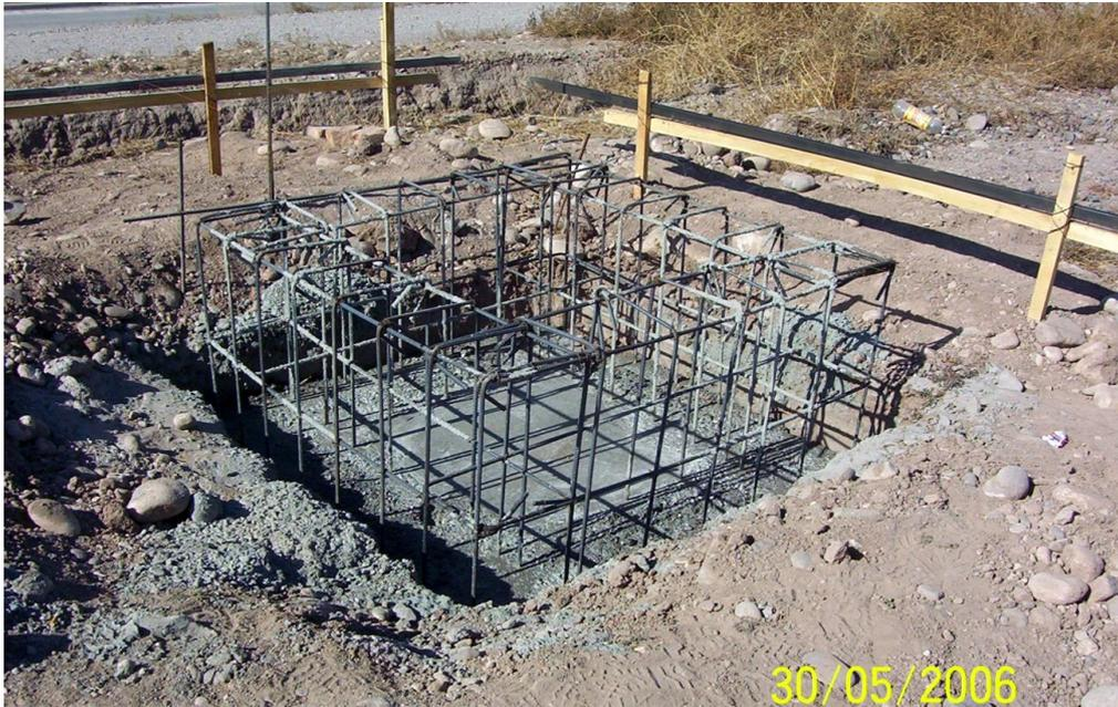
Foto 18. Base aislada de hormigón armado.
