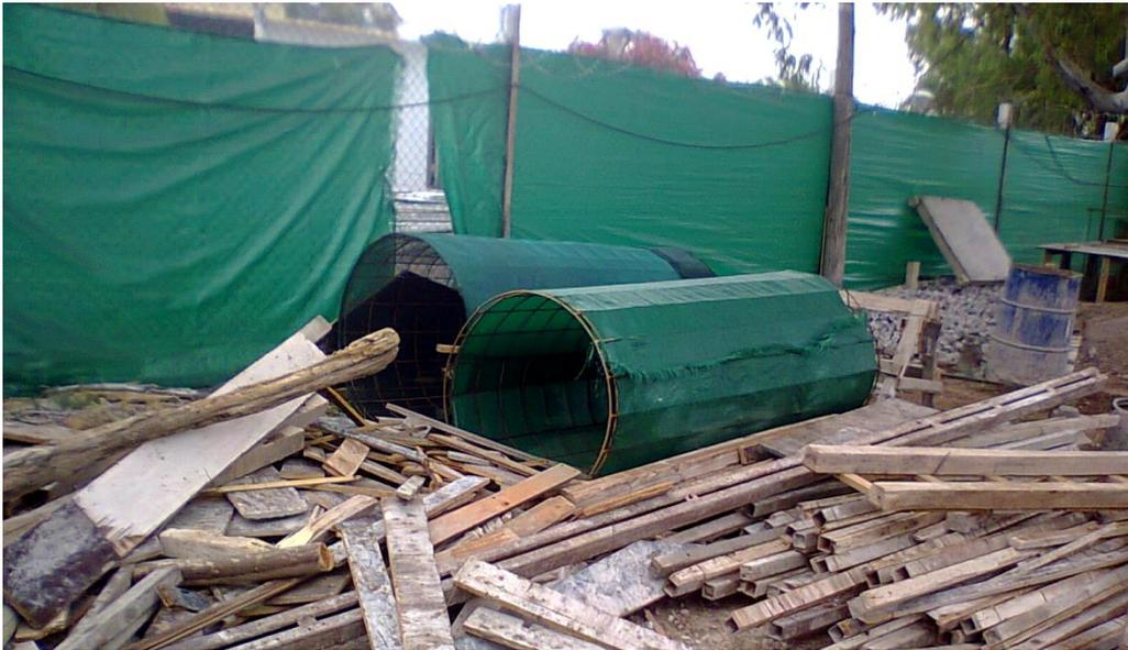
**Foto 12.** Protección para operarios en excavación para pozo.
