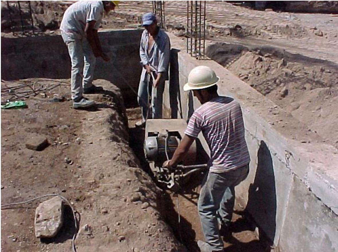
**Foto 14.** Compactación, con equipo manual, de una excavación para fundación
