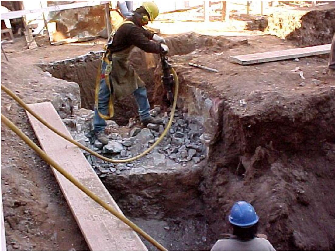
**Foto 2.** Equipo manual de excavación.
