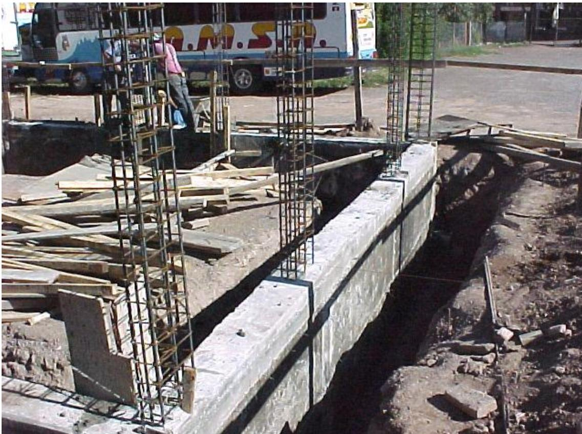
Foto 27. Fundación ya hormigonada, lista para rellenar y compactar los espacios vacíos.
