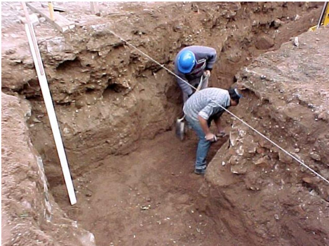
**Foto 3.** Excavación manual con pala.
