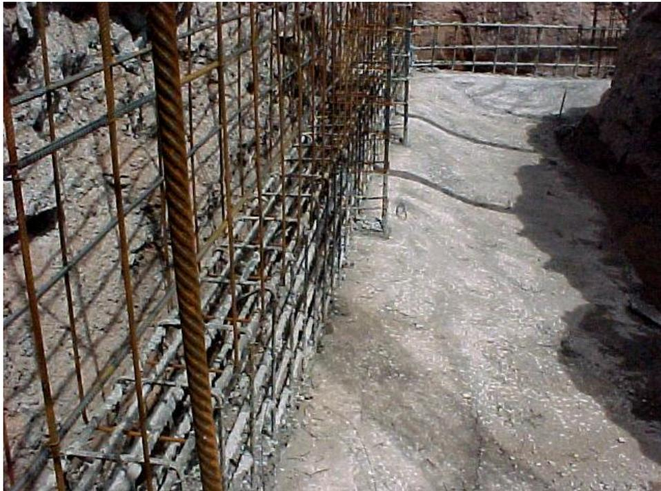
**Foto 21.** Hormigón de limpieza colocado antes del hormigonado de la fundación.
