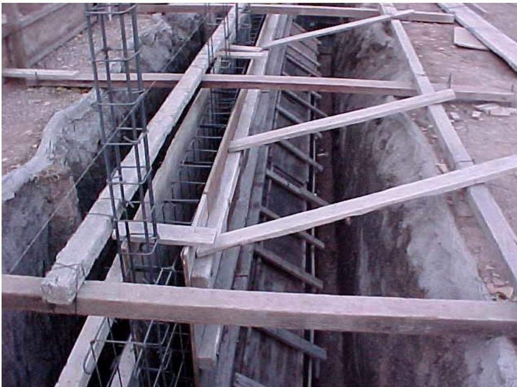
**Foto 23.** Encofrado de zapata corrida de sección triangular.
