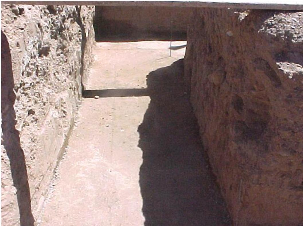
**Foto 15.** Excavación para fundación continua ya compactada.
