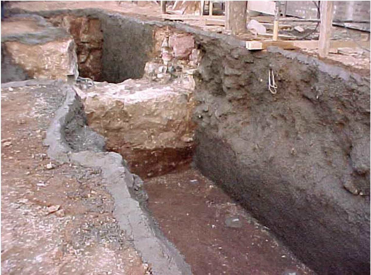
**Foto 10.** Excavación protegida con hormigón proyectado.
