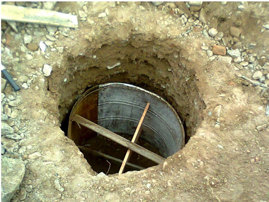
**Foto 7.** Entibación para proteger la excavación.
