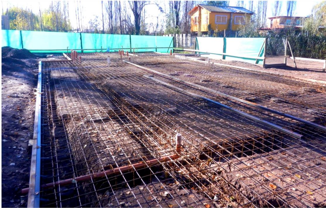
**Foto 28.** Armadura para platea de fundación nervurada.
