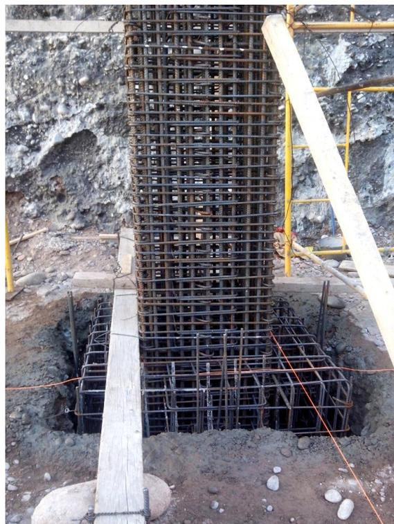
Foto 19. Base aislada de H°A°, ya con el arranque de las columnas.
