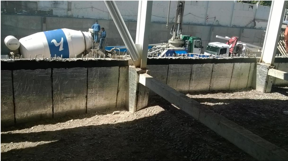
**Foto 39.** Aislación hidrófuga de fundación con membrana asfáltica.
