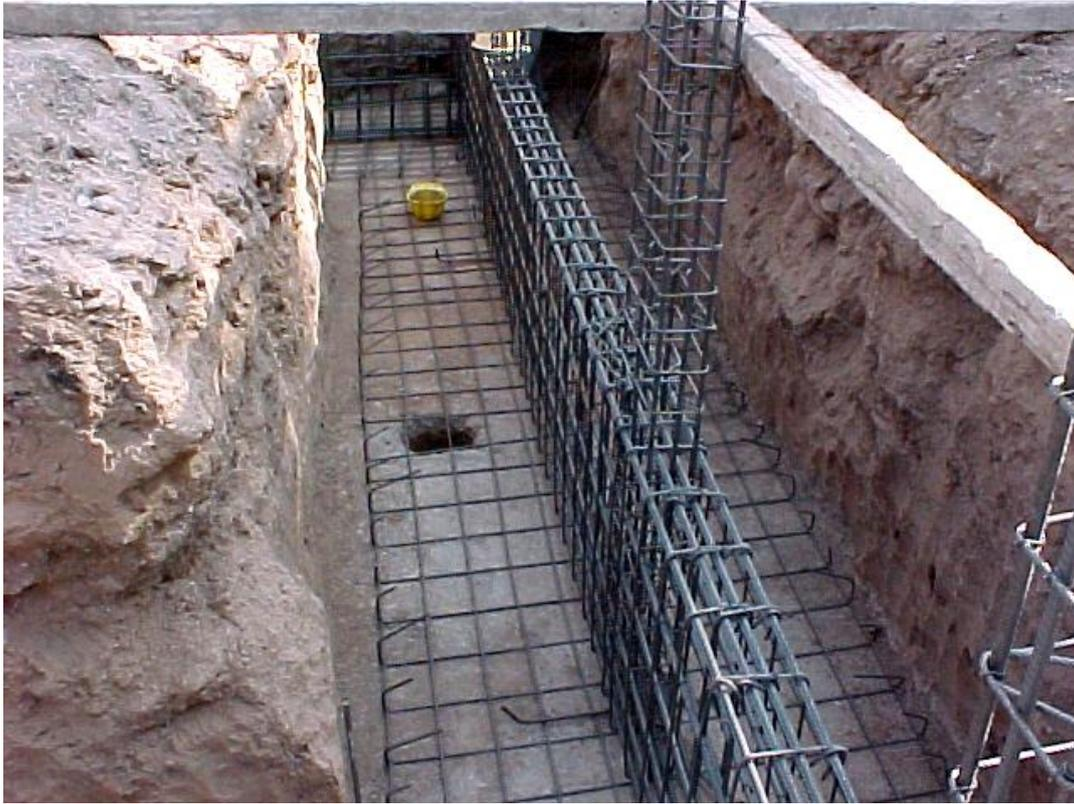
**Foto 24.** Armadura para zapata corrida de sección "T invertida".
