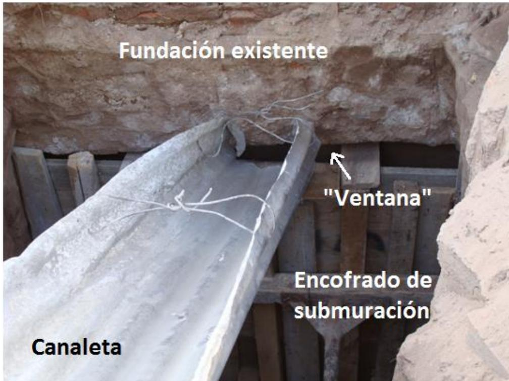
**Foto 37.** Encofrado de submuración por pozo.
