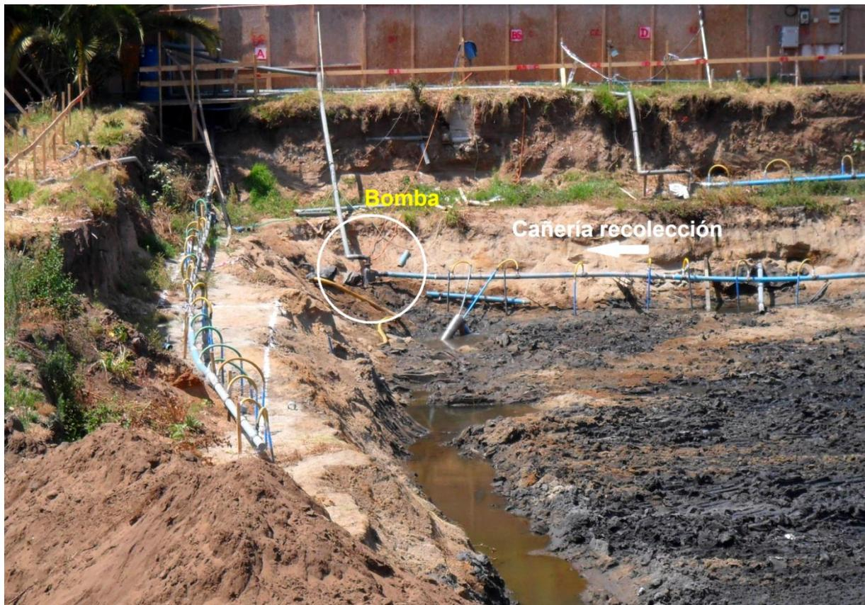
**Foto 17.** Excavación abierta con presencia de agua.
