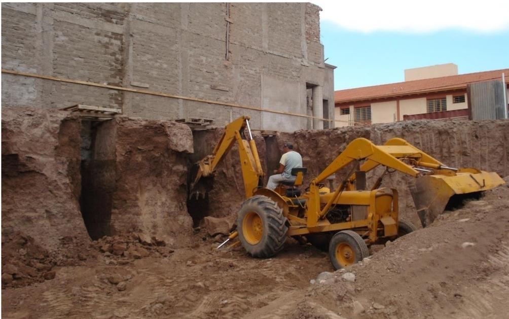
**Foto 33.** Excavación para submuración por trinchera.
