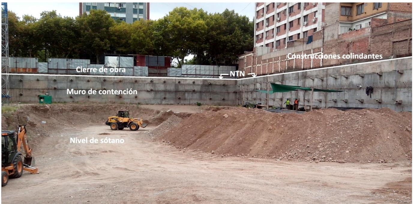
**Foto 9.** Excavación protegida con muro de contención de H°A°.
