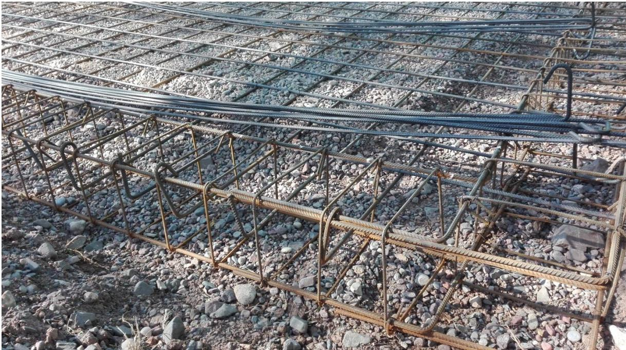
**Foto 40.** Aislación hidrófuga de platea mediante una capa de ripio.
