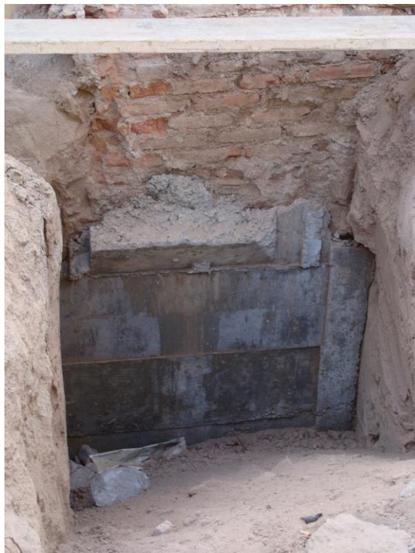
**Foto 35.** Submuración por trinchera finalizada.
