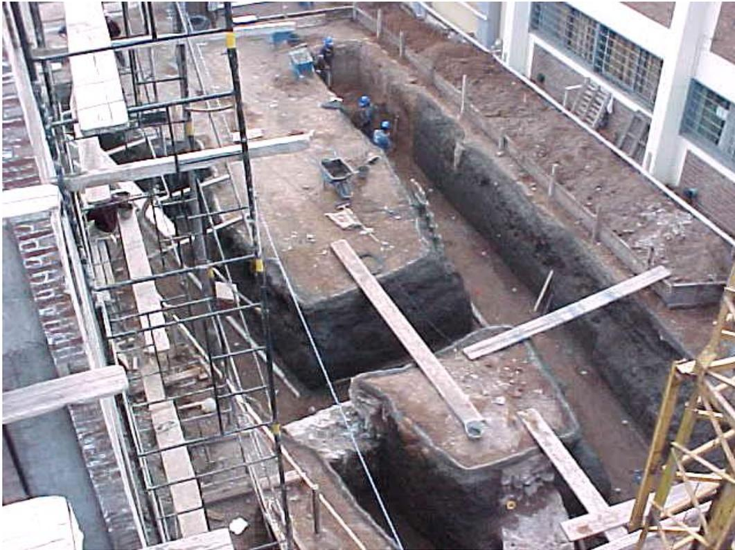
**Foto 4.** Excavaciones para fundaciones continuas.
