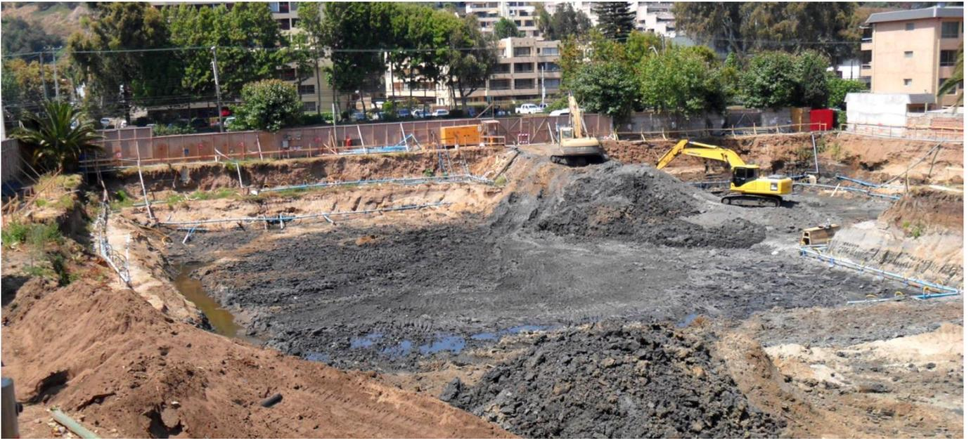
**Foto 16.** Excavación abierta con presencia de agua.
