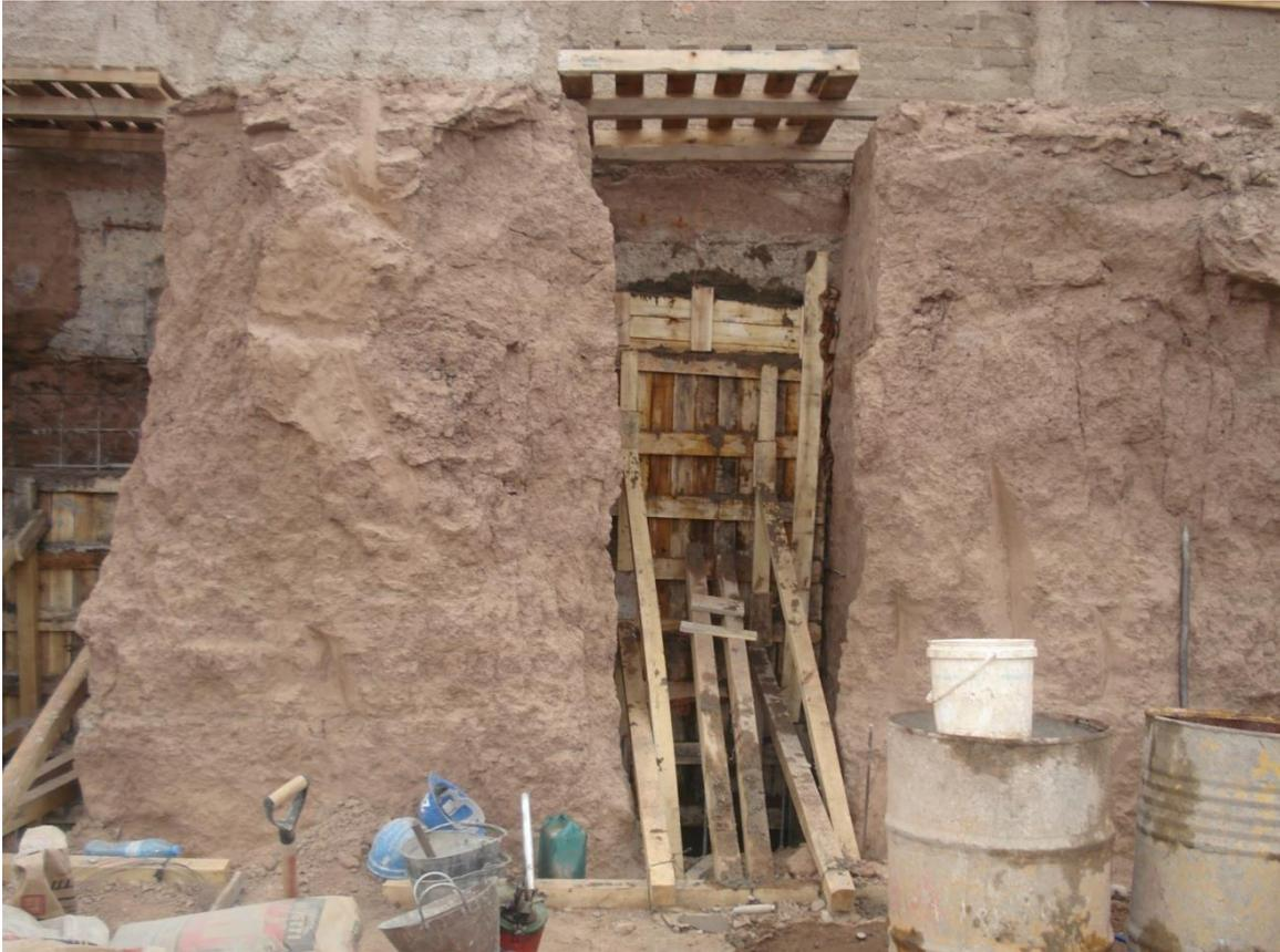
**Foto 34.** Encofrado de submuración por trinchera.
