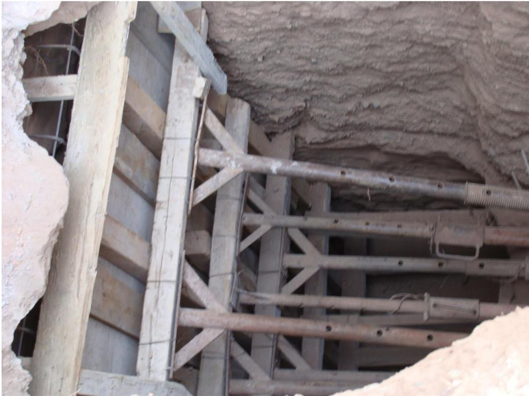
**Foto 36.** Encofrado de submuración por pozo (foto desde arriba del pozo).
