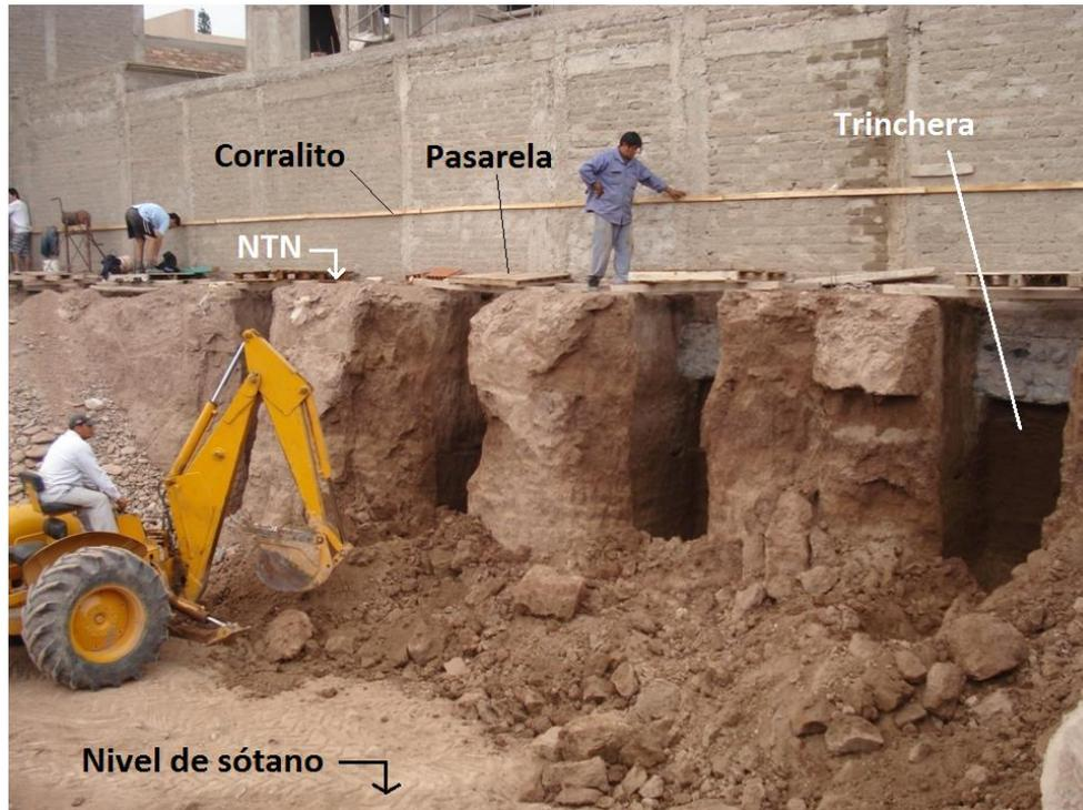
**Foto 32.** Submuración por trinchera.
