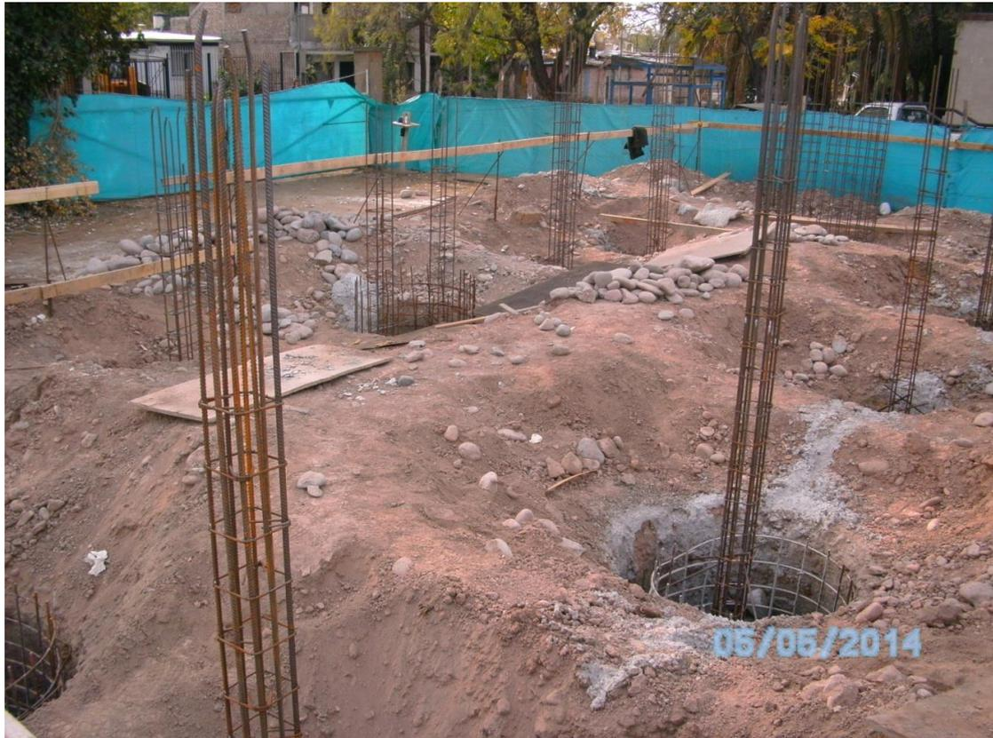
**Foto 30.** Fundación mediante pozos.
