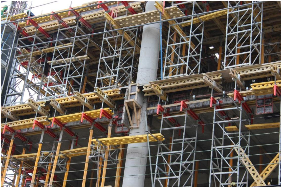
**Imagen 47.** Encofrado Losas, Vigas y Aleros
