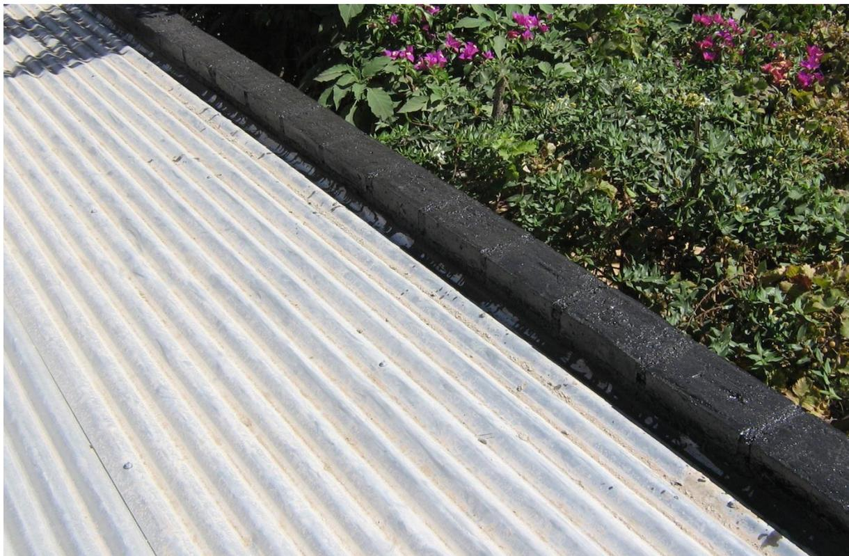
**Imagen 226..** Aislación hidráulica de la junta chapa cubierta - borde H° con pintura asfáltica.
