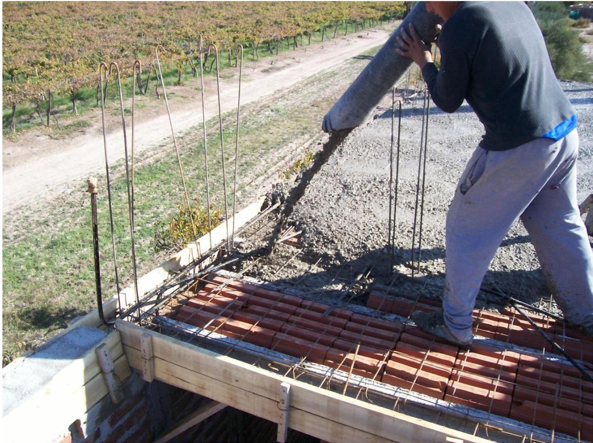
**Imagen 8.** Hormigonado de losa y vigas perimetrales.
