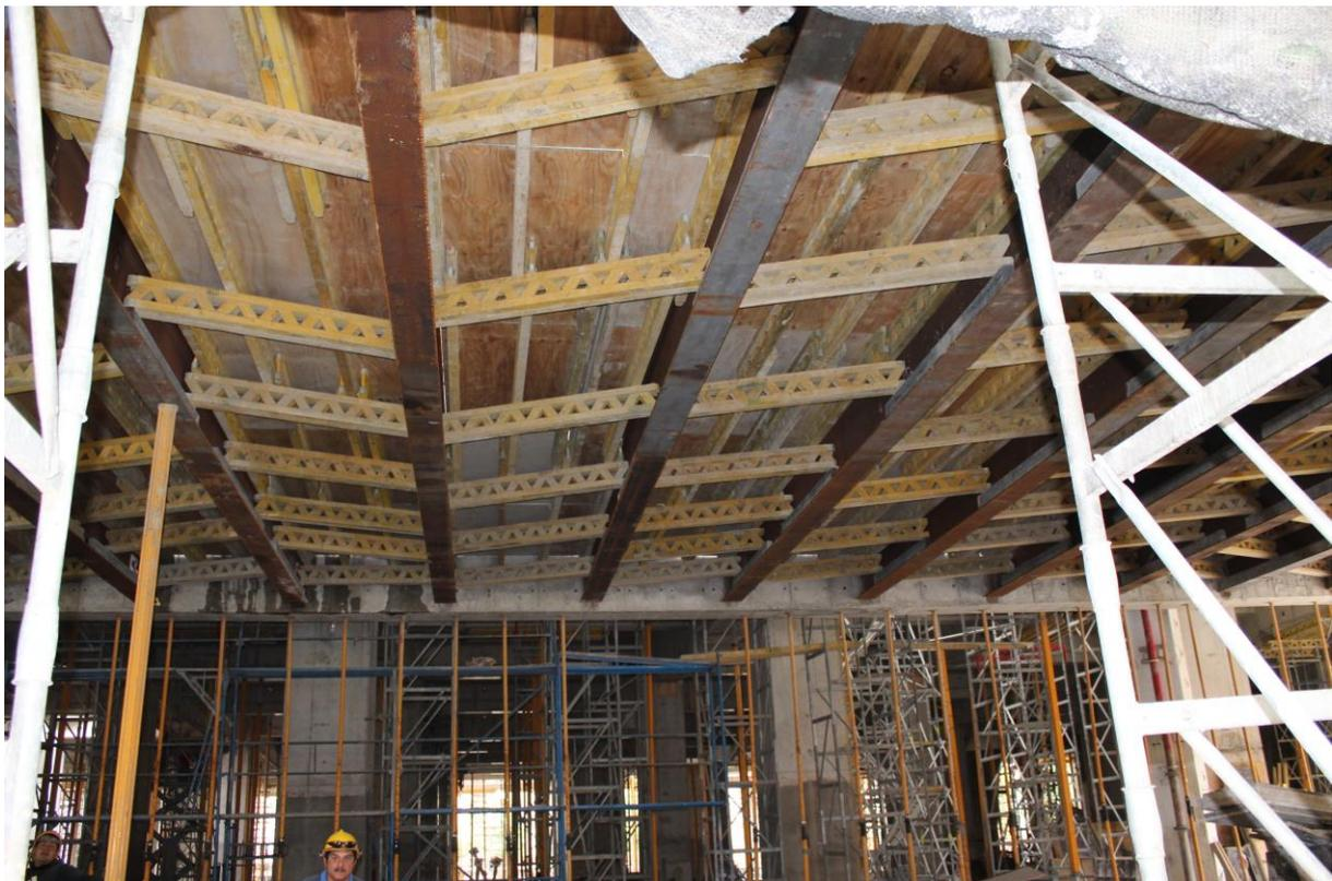
Imagen 49. Encofrado de losa.
