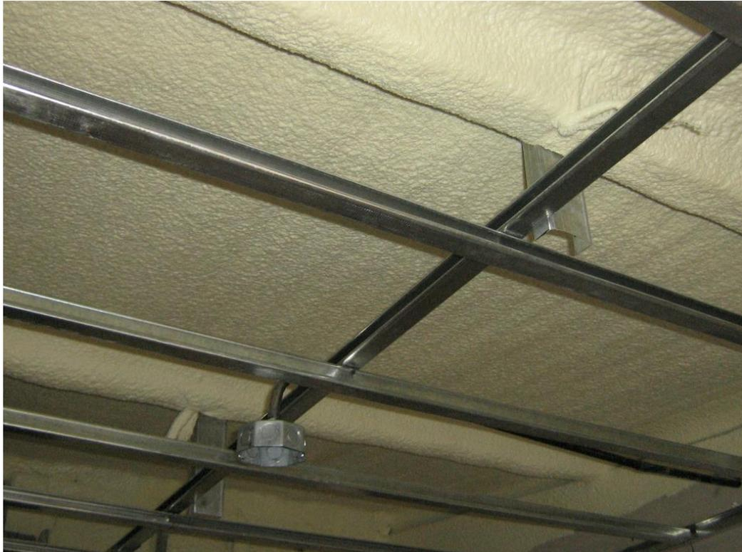
**Imagen 204.** Aislación térmica en cubierta metálica.
