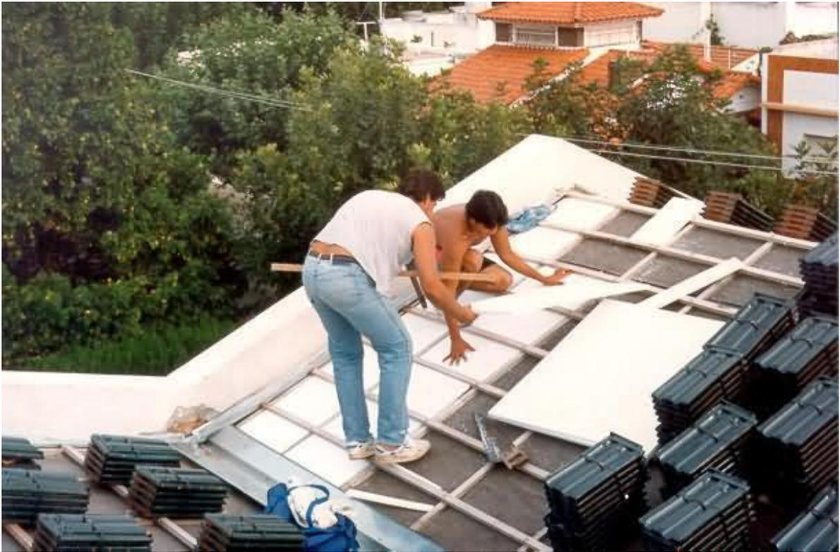
**Imagen 2319.** Cubierta de tejas francesas colocación aislaciones.
