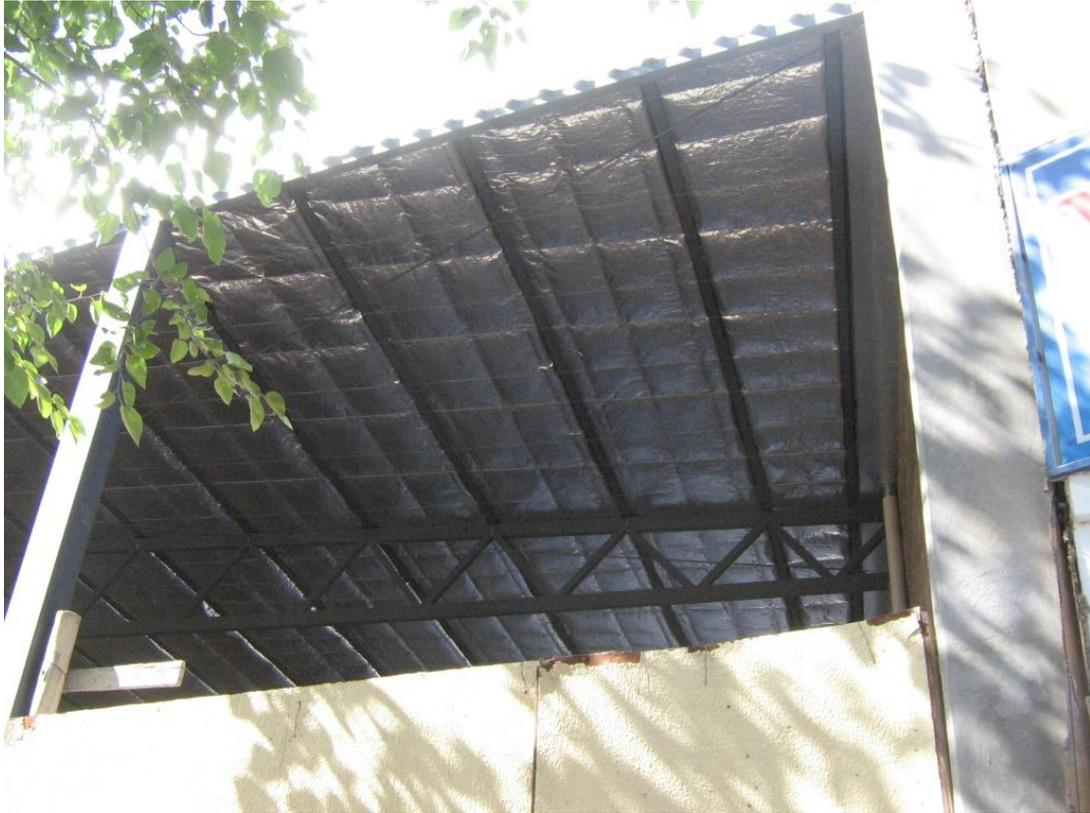
**Imagen 13.1** Cubierta de chapa metálica, con correas de celosía y aislación térmica
