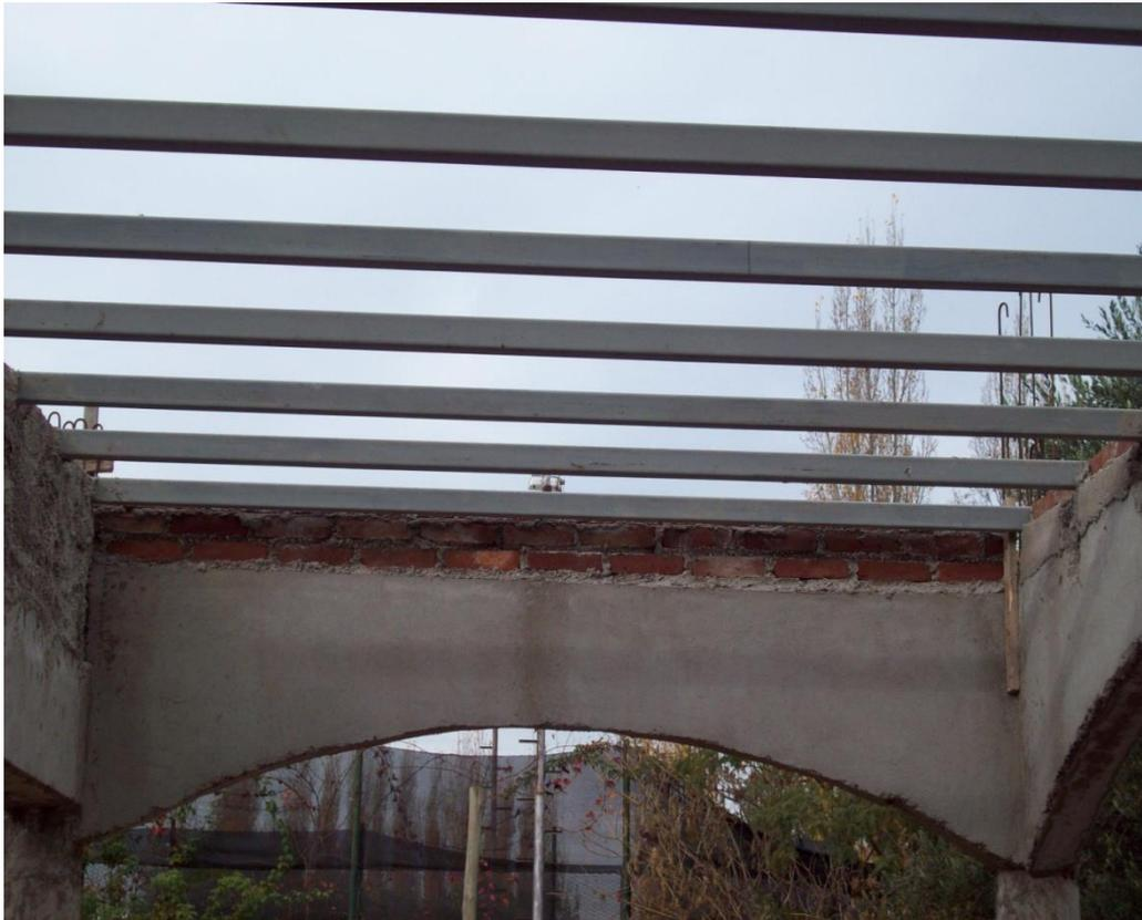
**Imagen 9.** Colocación de perfiles metálicos como correas principales.
