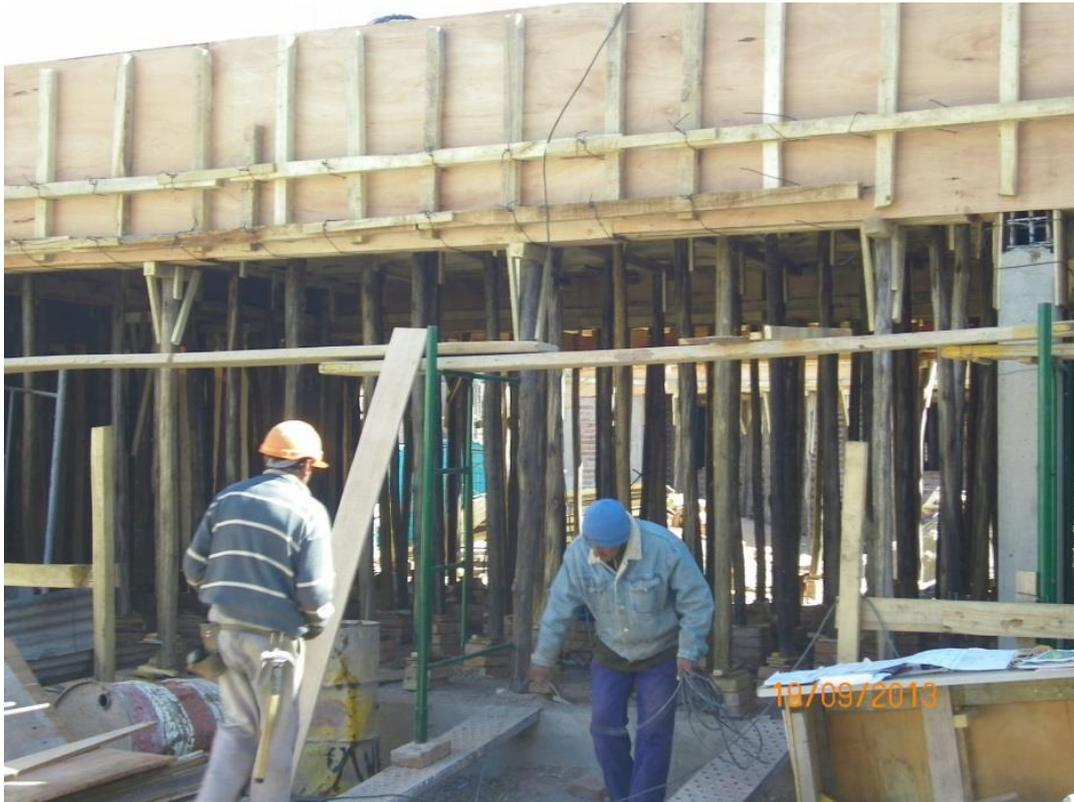
**Imagen 40.** Encofrado lateral de Viga.
