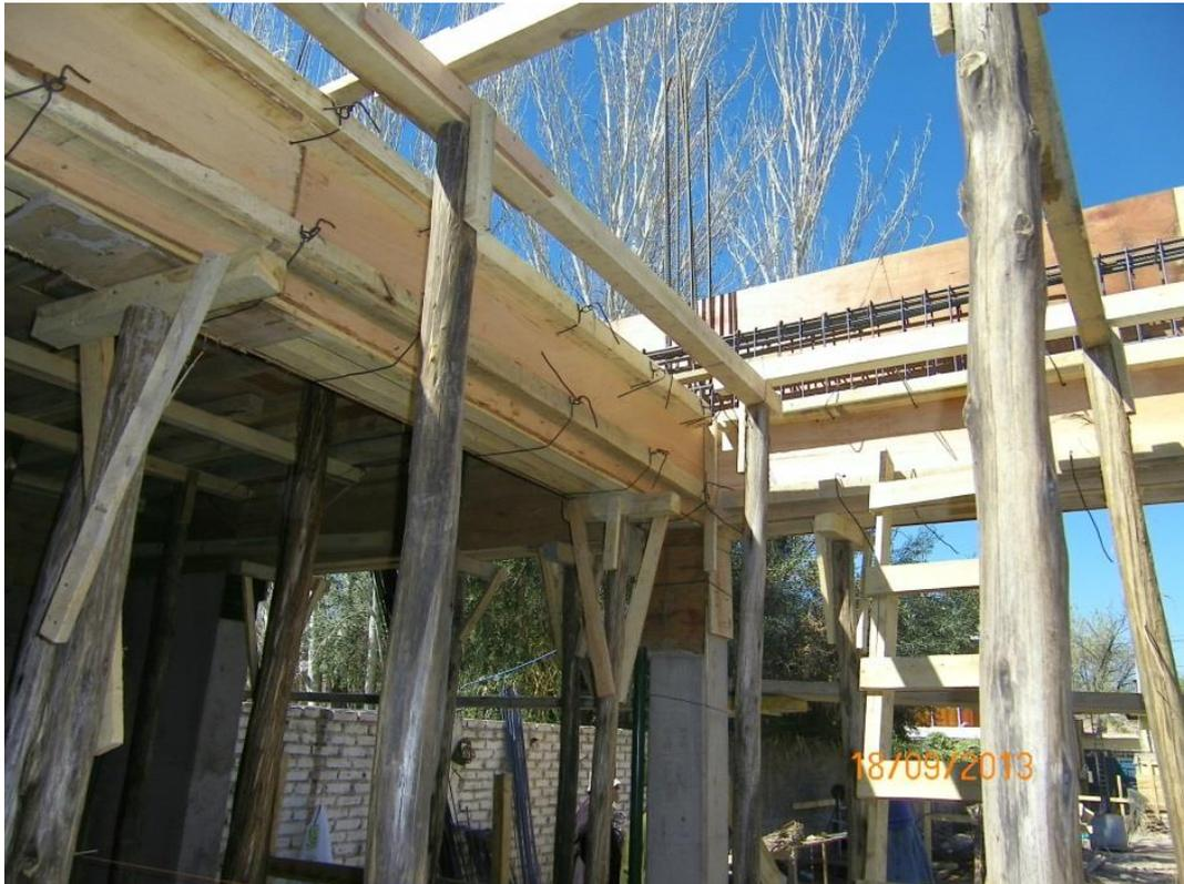
**Imagen 42.** Colocación de puntales para losa maciza.
