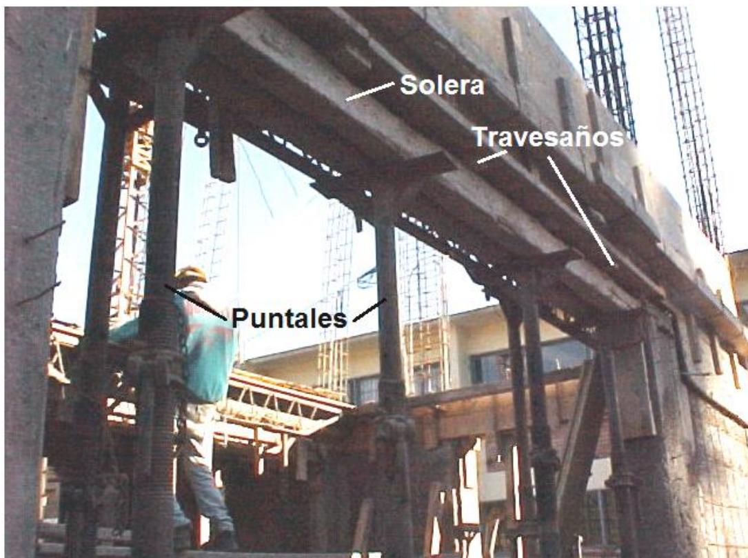
**Imagen 41.** Encofrado fondo y lateral de Viga.
