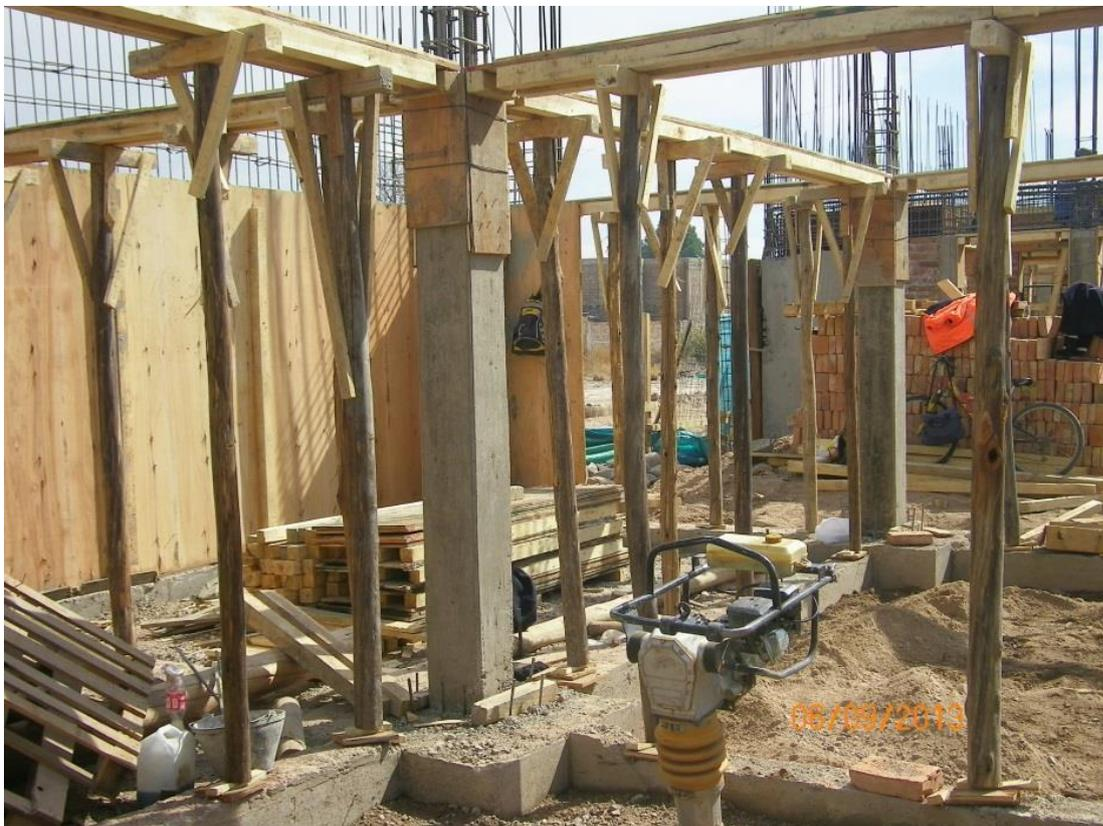
**Imagen 37.** Encofrado fondo de Vigas.
