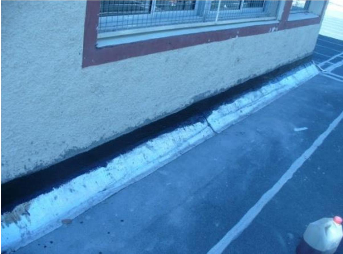
**Imagen 259..** Resolución unión muro mampostería – azotea H°A° mediante babela.
