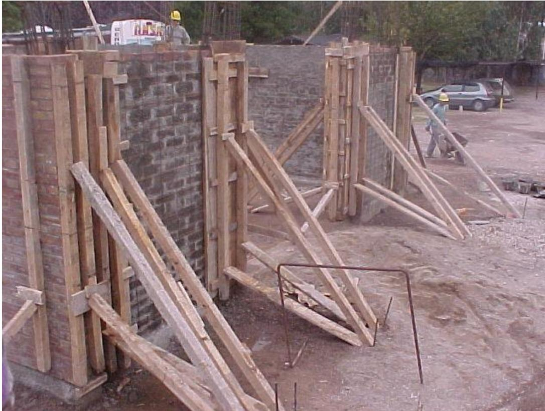
Imagen 31. Encofrado de columnas
