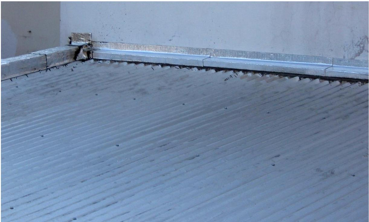
**Imagen 248..** Aislación hidráulica de la junta chapa cubierta – muro mampostería con membrana asfáltica.
