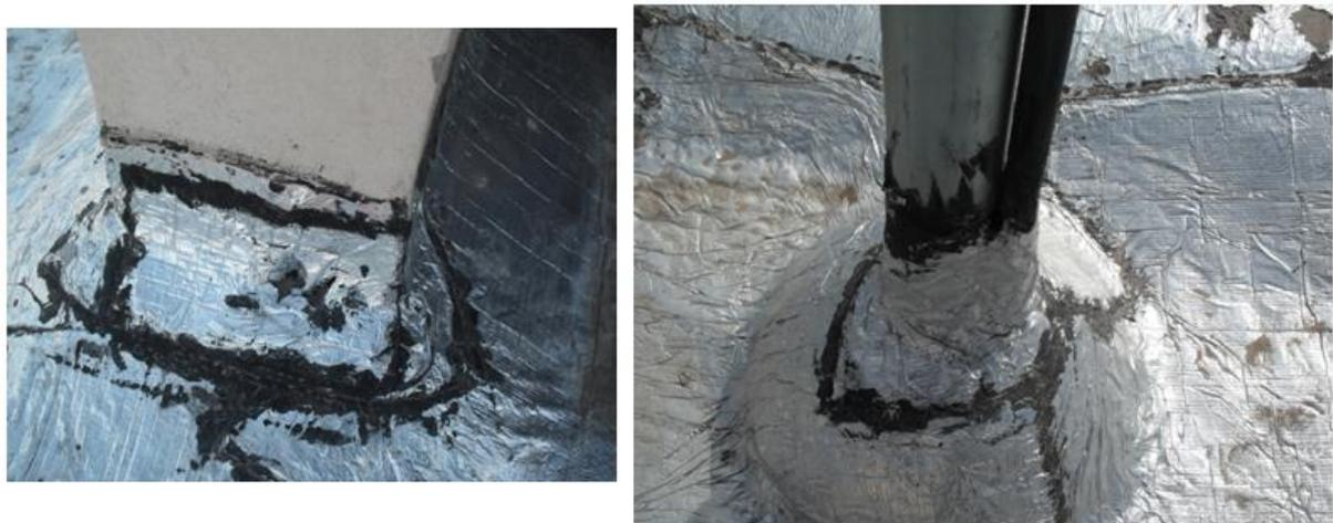
**Imagen 30..** Resolución de aislación hidráulica en ventilaciones.
