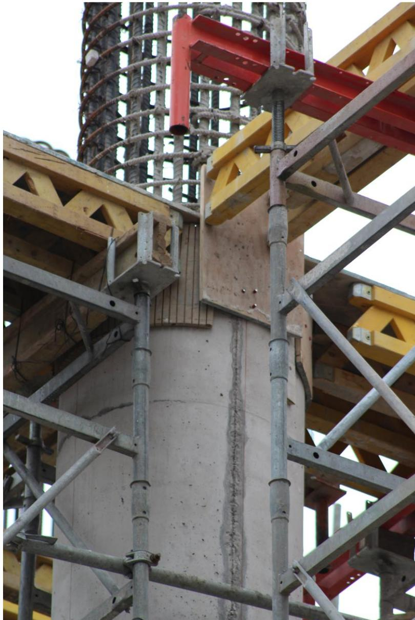
Imagen 53. Detalle de apoyo de vigas sobre columna circular
