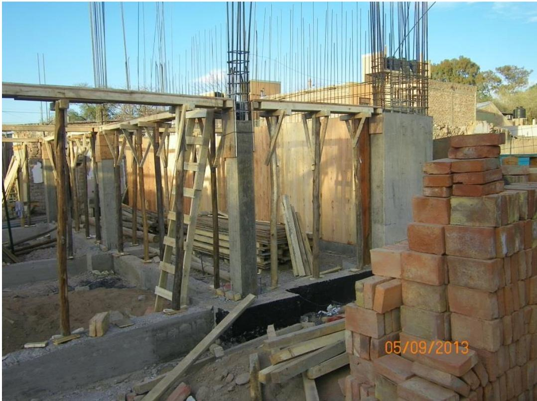
**Imagen 36.** Encofrado fondo de Vigas
