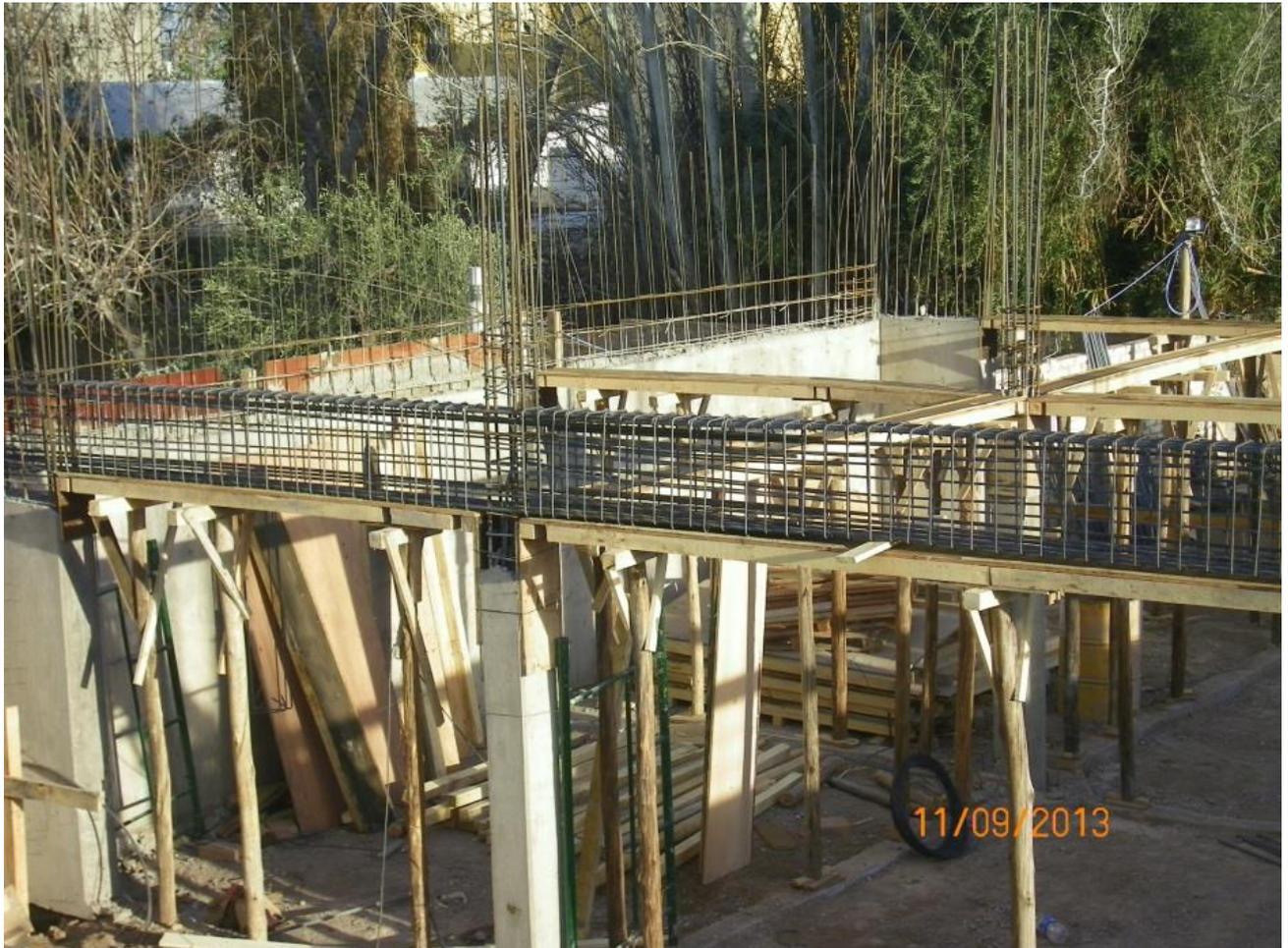
**Imagen 38.** Encofrado fondo de Vigas y colocado de armadura.
