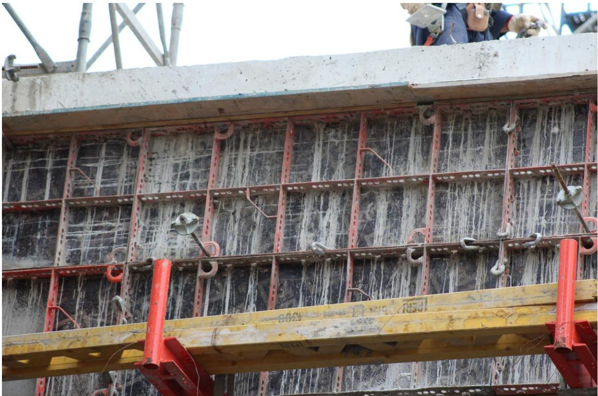
Imagen 51. Encofrado metálico Lateral de viga
