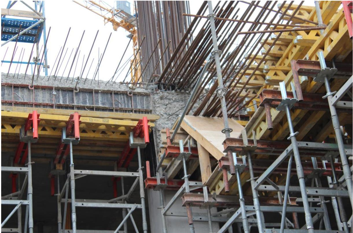
Imagen 50. Encofrado de losa y aleros
