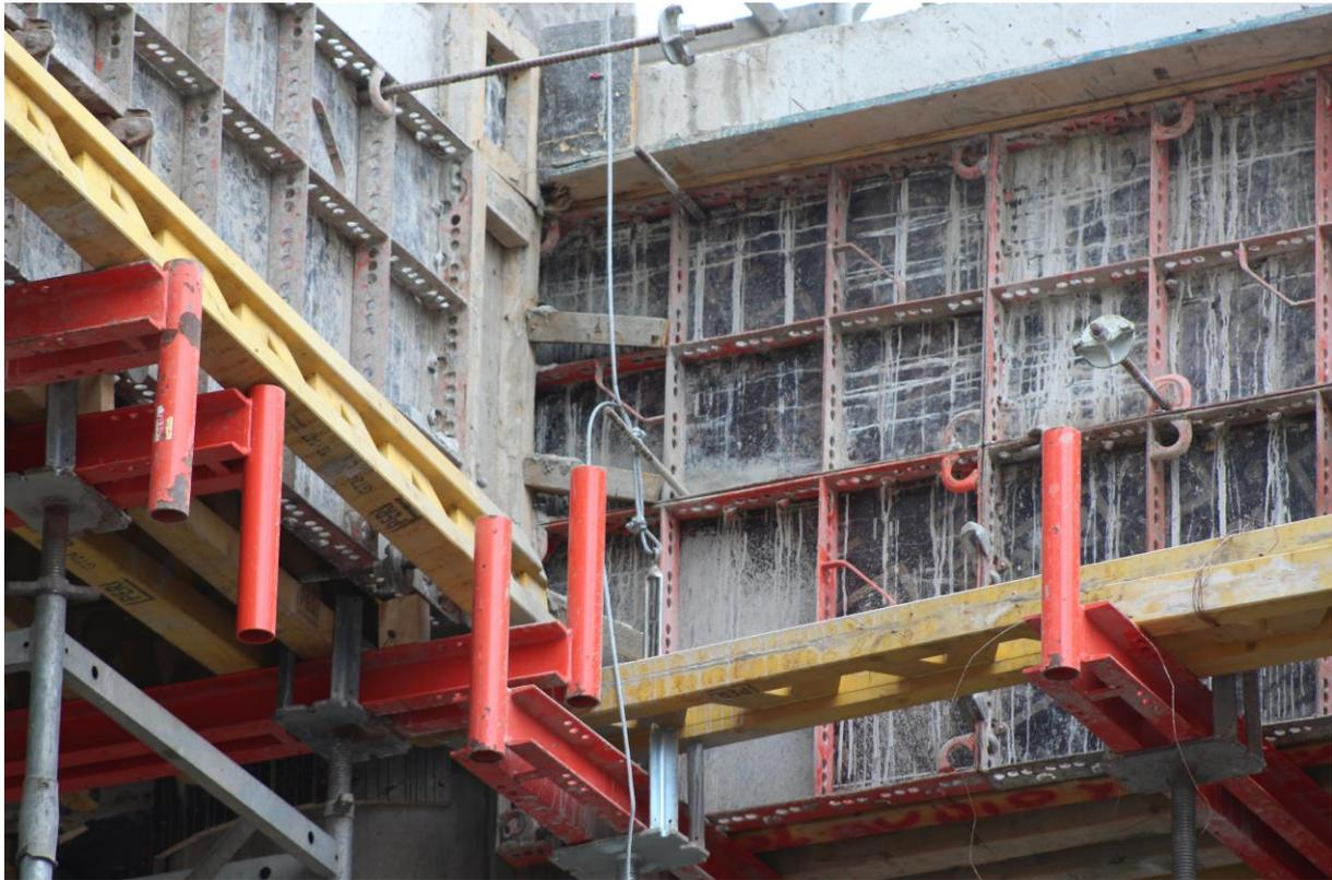
Imagen 52. Encofrado metálico Lateral de viga
