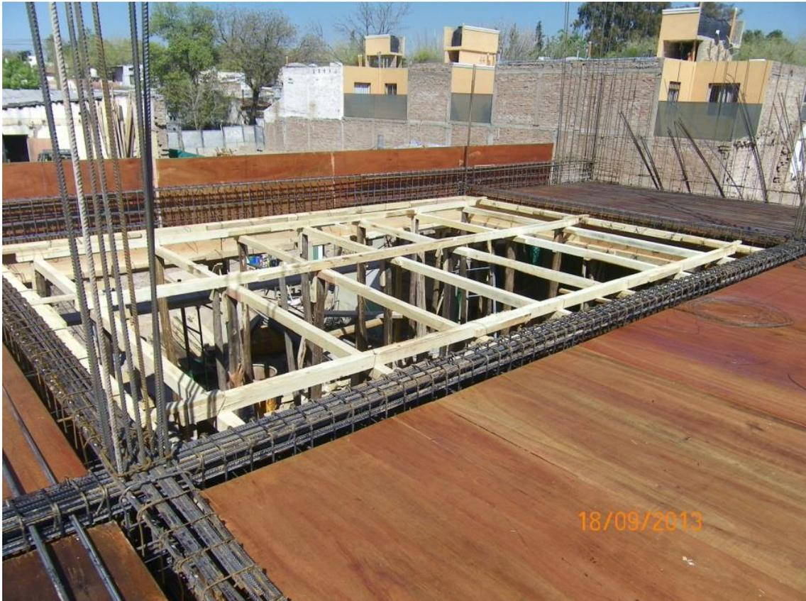
**Imagen 44.** Encofrado de losa maciza de H°A°
