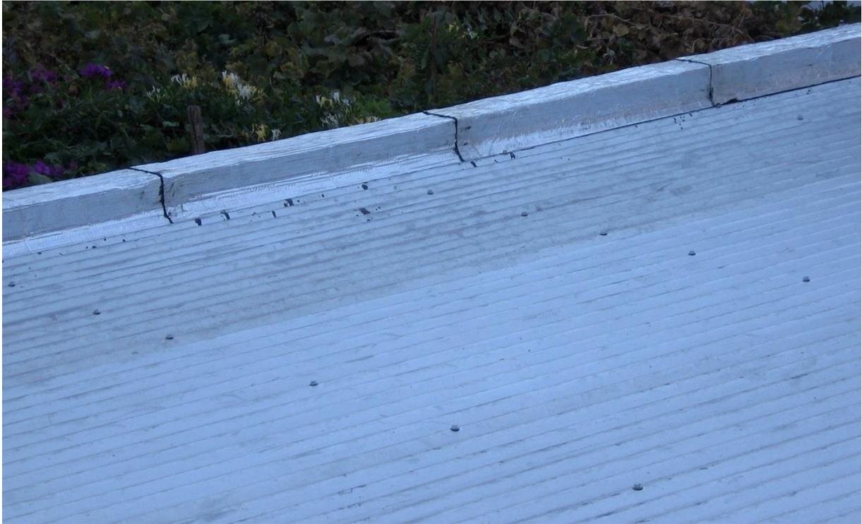
**Imagen 237..** Aislación hidráulica de la junta chapa cubierta - borde H° con membrana asfáltica.
