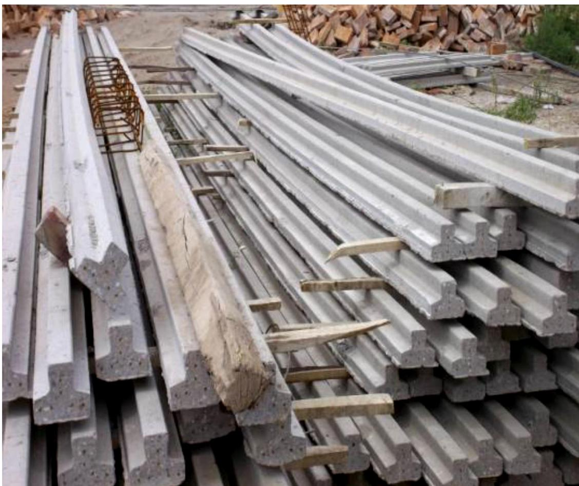
**Imagen I.** Acopio en obra de viguetas para losa alivianada.
