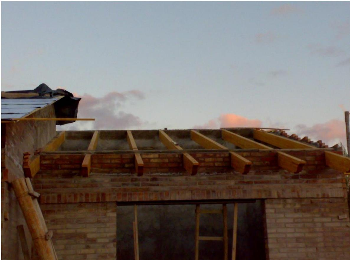
**Imagen 16.** Terminación de un muro una vez colocados los cabios (encarozado).
