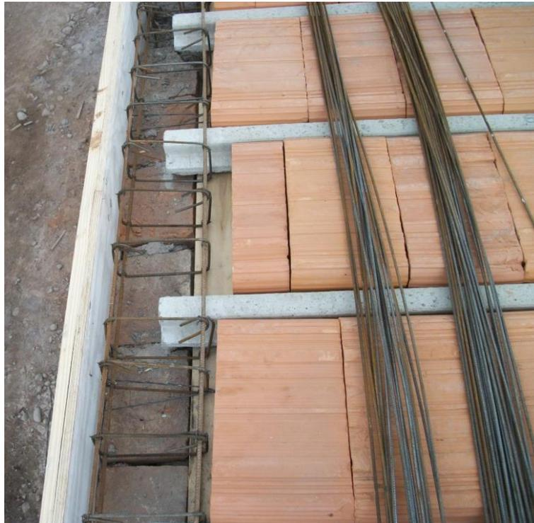
**Imagen 4.** Colocación de viguetas y bloques cerámicos.
