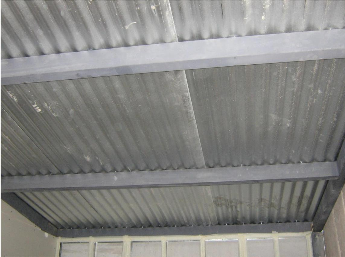
**Imagen I1.** Fijación de la chapa metálica.
