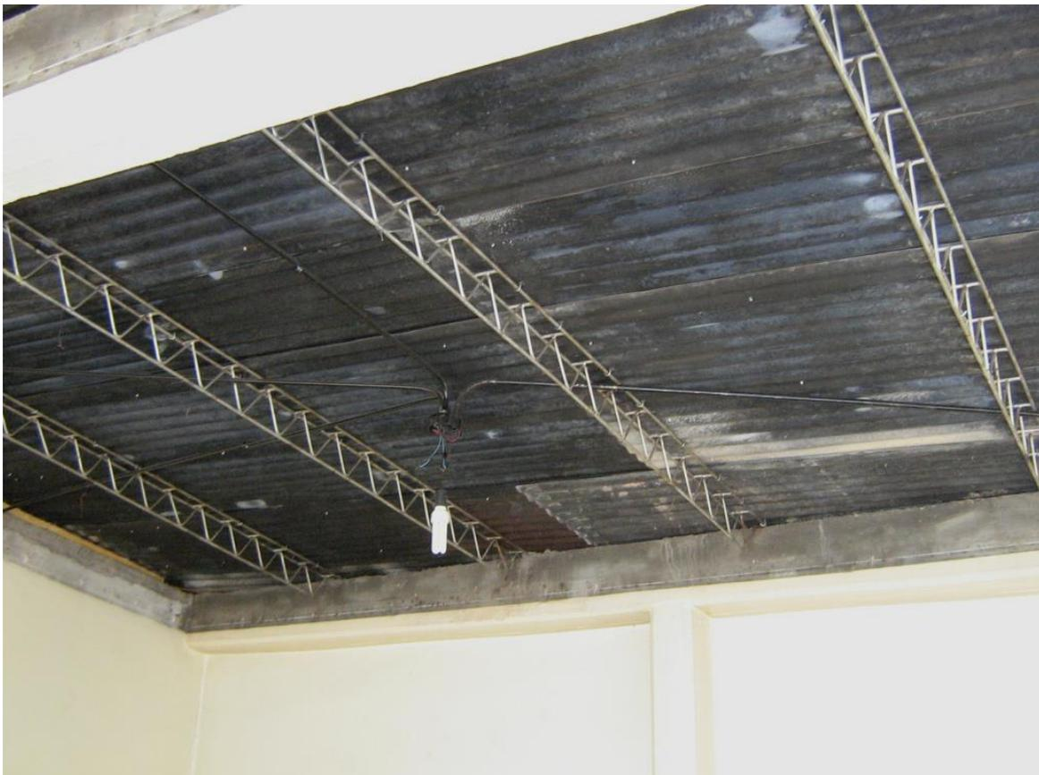
**Imagen I2.** Cubierta de chapa metálica, con correas de celosía.
