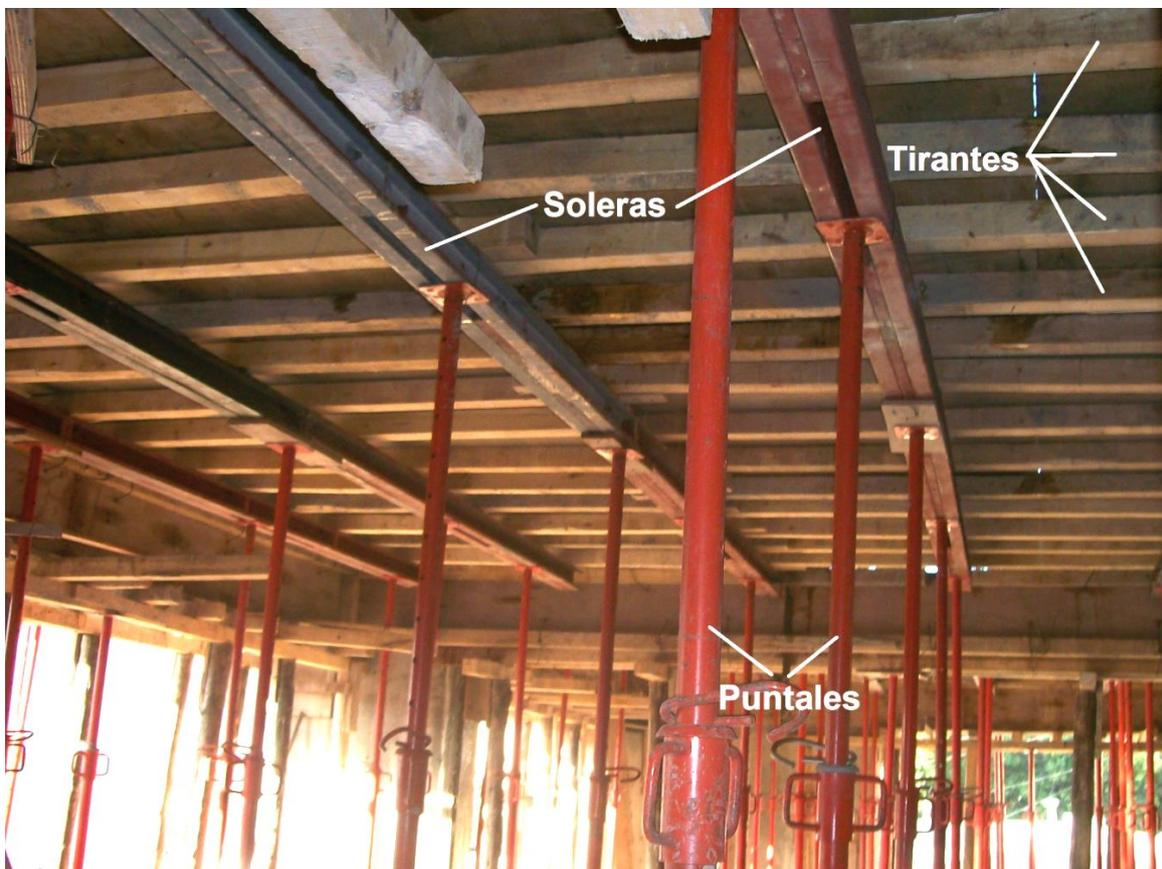
**Imagen 45.** Encofrado de losa maciza de H°A° con puntales y vigas metálicas.
