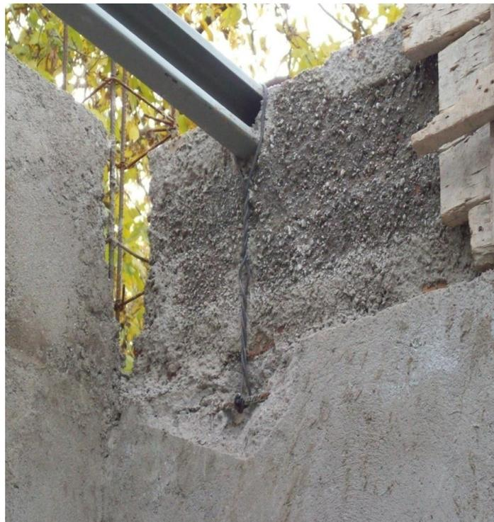
**Imagen 10.** Unión de las correas metálicas con el muro.
