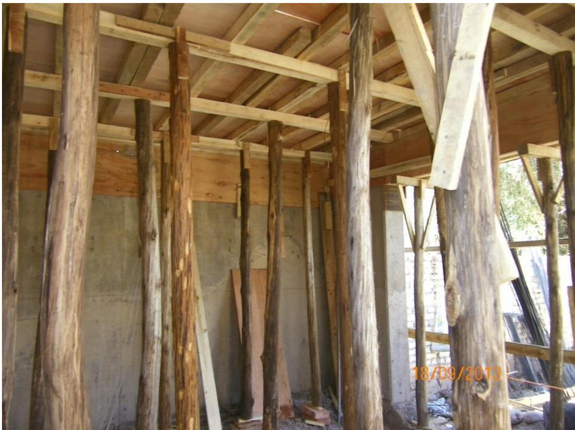
**Imagen 43.** Colocación encofrado fondo de losa
