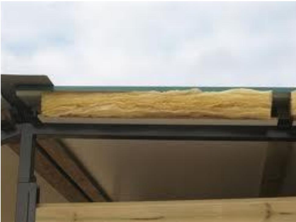
**Imagen 22.** Aislación térmica de cubierta metálica.
