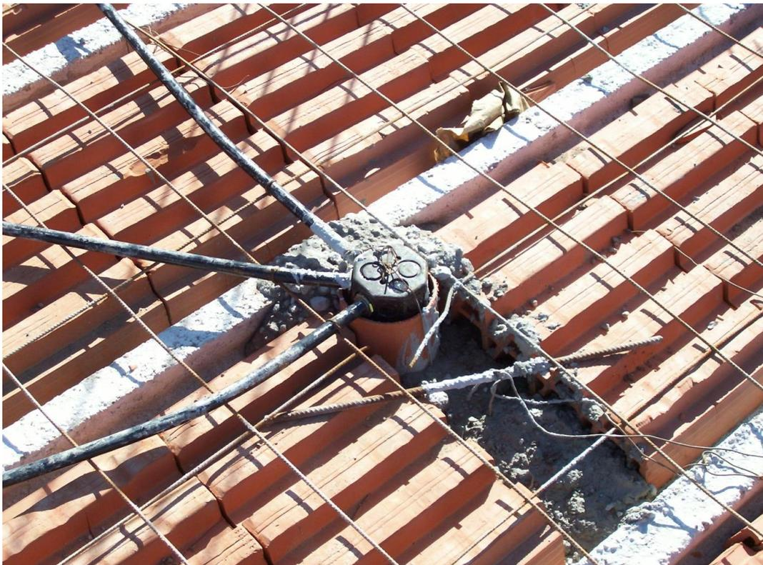
**Imagen 7.** Pase para instalación eléctrica.
