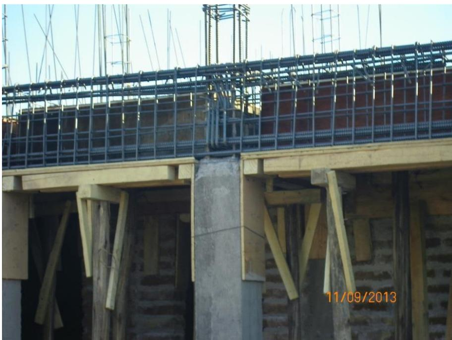
**Imagen 39.** Encofrado fondo de Vigas y colocado de armadura.
