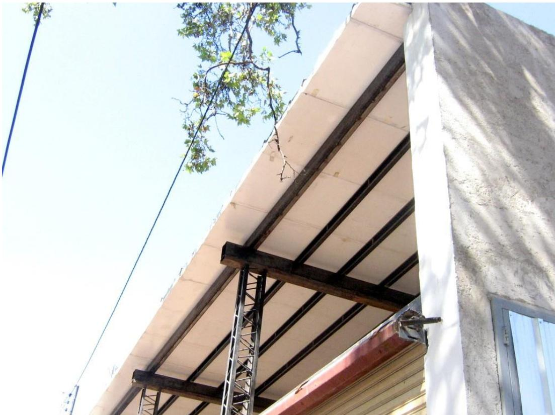
**Imagen 14.2** Cubierta metálica, con paneles de chapa de poliuretano.
