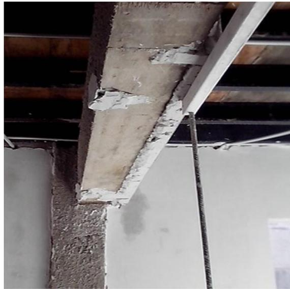
**Imagen 28.** Detalle de revestimiento de yeso en vigas de techo.
