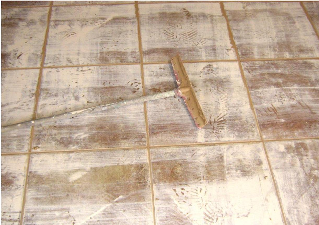
**Imagen 16.** Colocación de la pastina de terminación mediante un secador.
