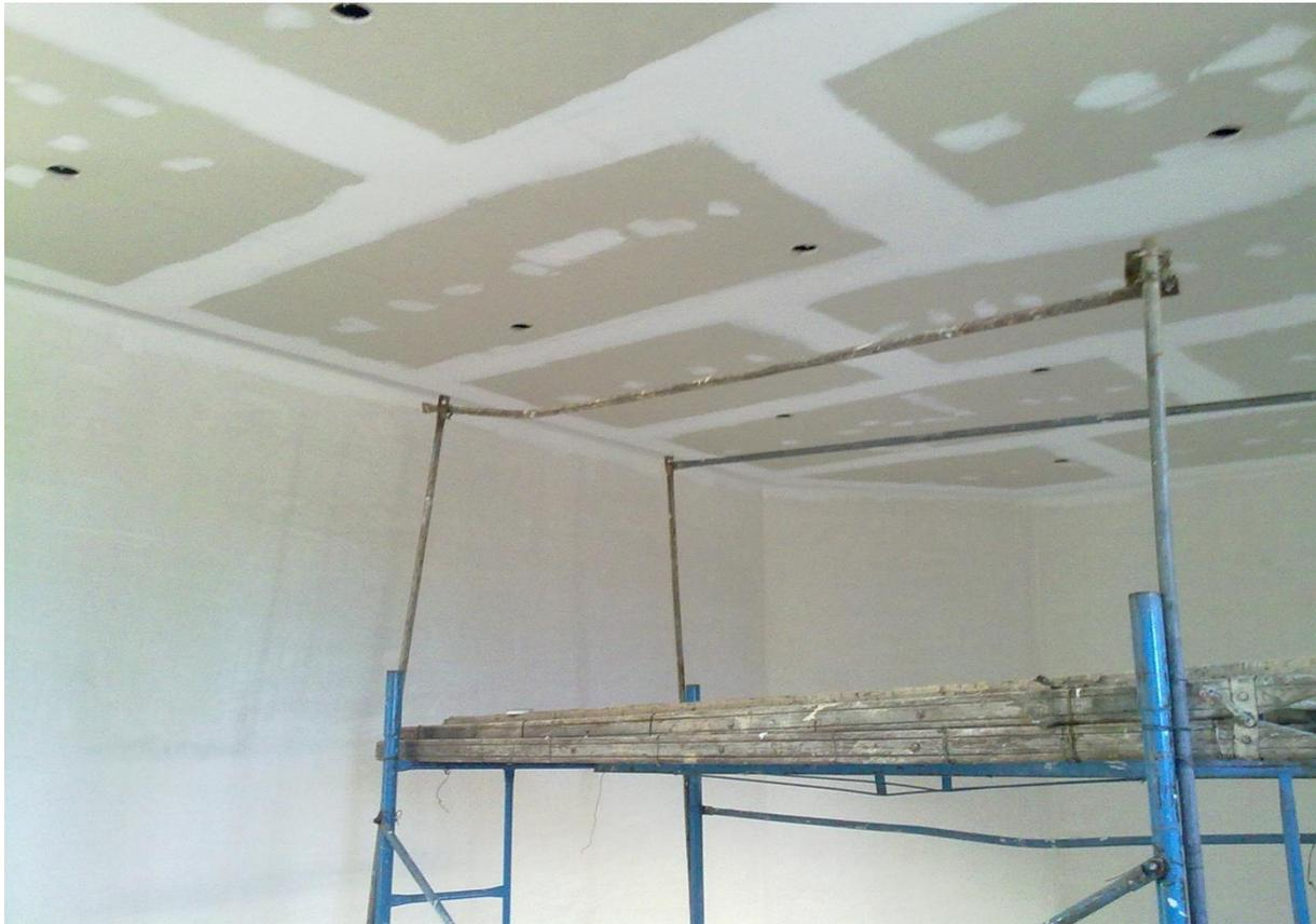
**Imagen 20.** Emplacado de cielorraso suspendido, con placas de roca de yeso.
