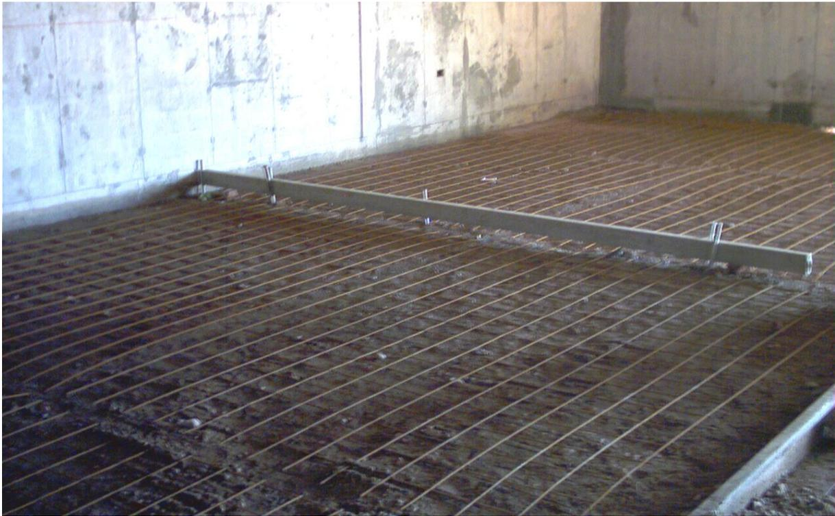
**Imagen 10.** Ejecución de contrapiso de hormigón armado.
