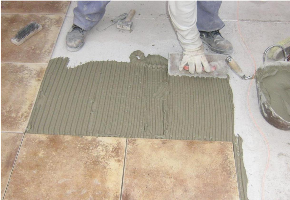
**Imagen 14.** Se extiende el adhesivo con una llana dentada.
