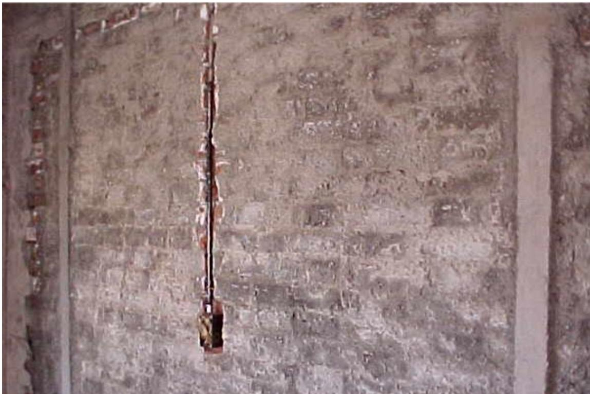
**Imagen 5.** Ejecución de la instalación eléctrica.
