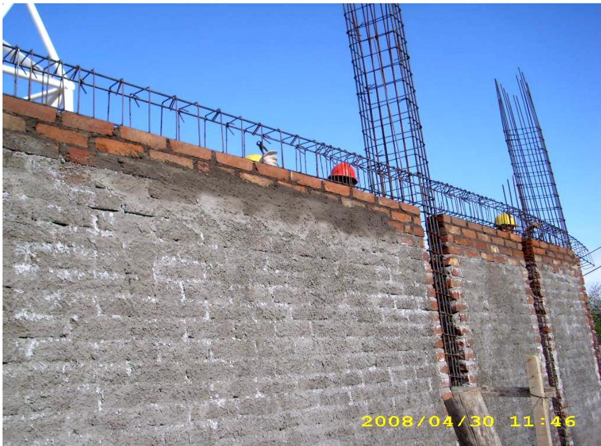
**Imagen I.** Chicoteado o azotado en un muro de mampostería.
