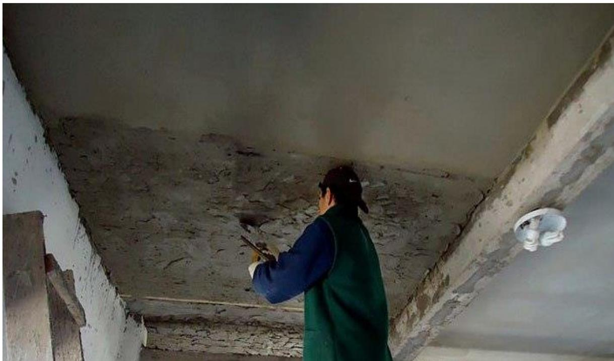
**Imagen 25.** Cielorraso aplicado con concreto terminación rústica.
