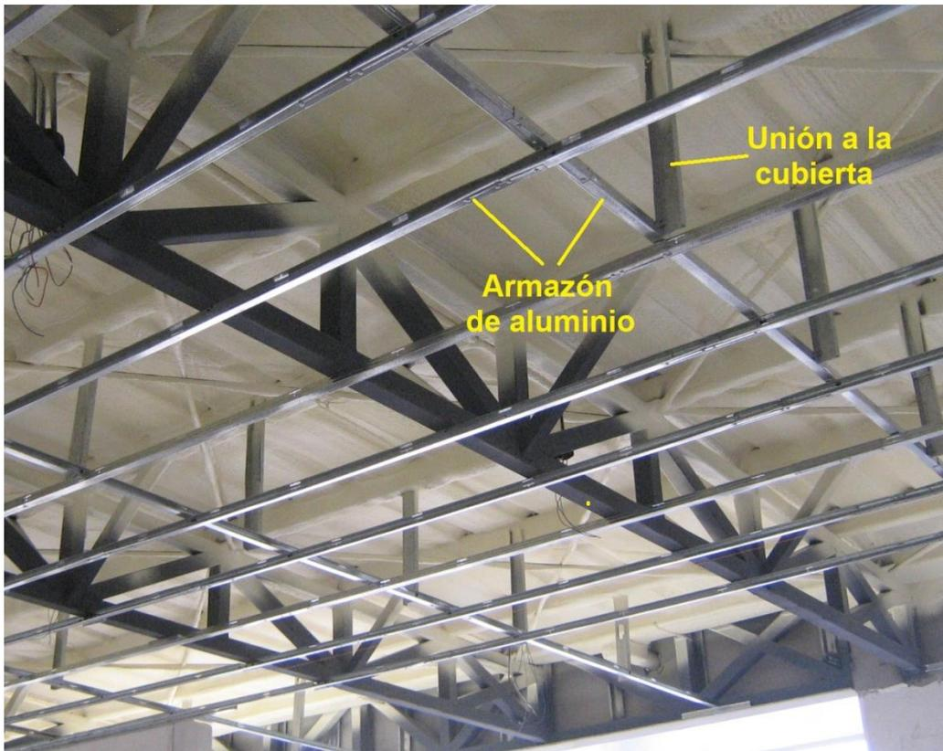
Imagen 18. Cielorraso suspendido de acero galvanizado.
