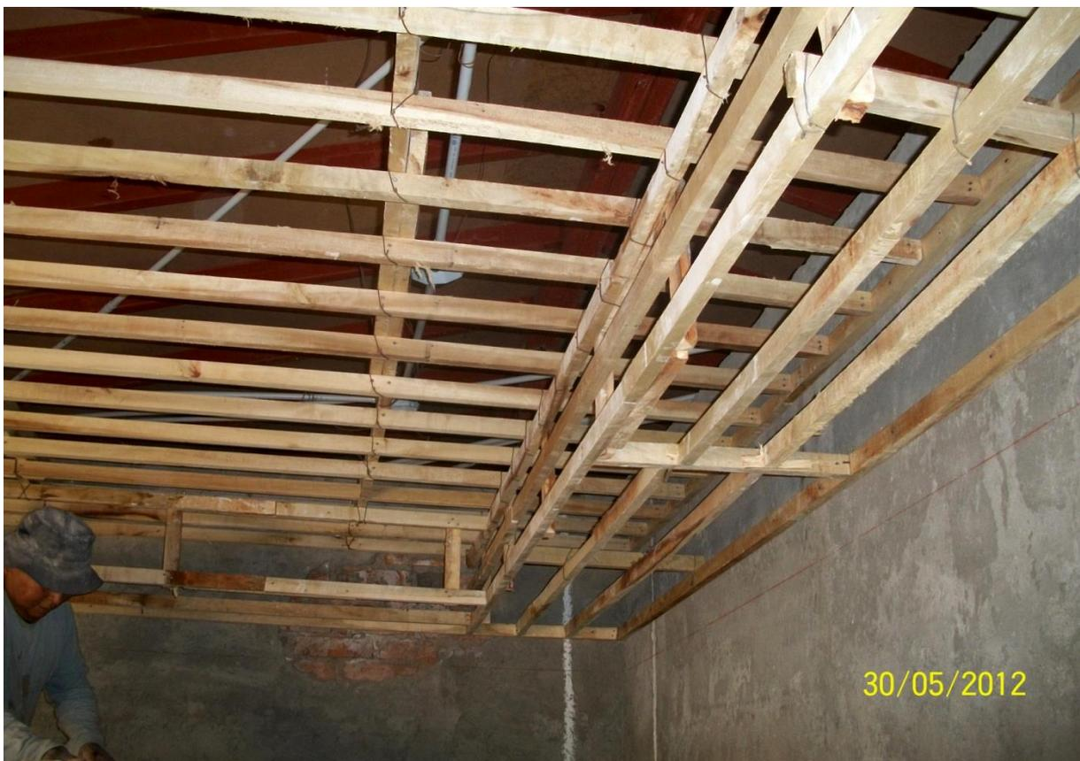
**Imagen 21.** Cielorraso suspendido de estructura de madera.
