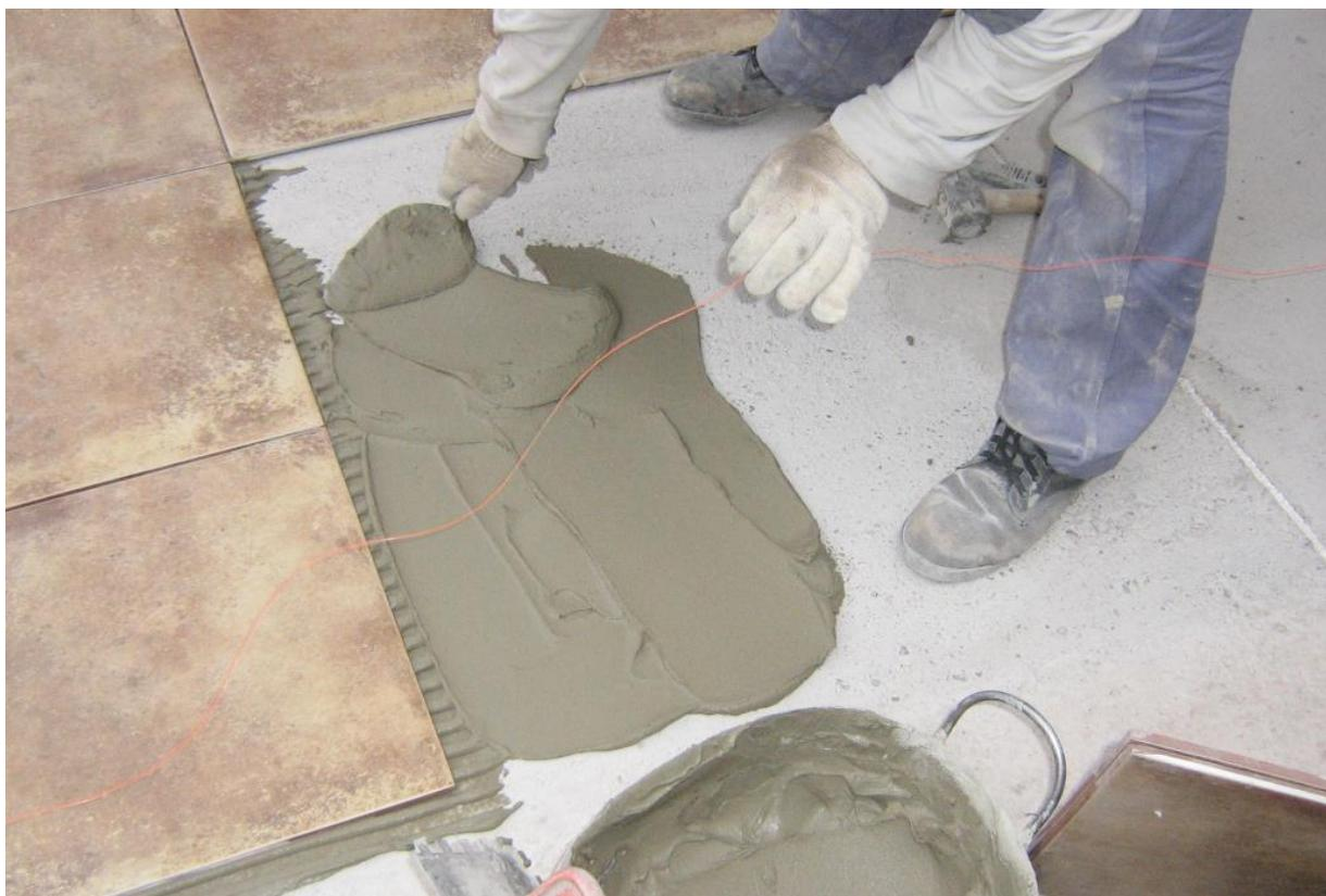
**Imagen 13.** Colocación del adhesivo con cuchara.
