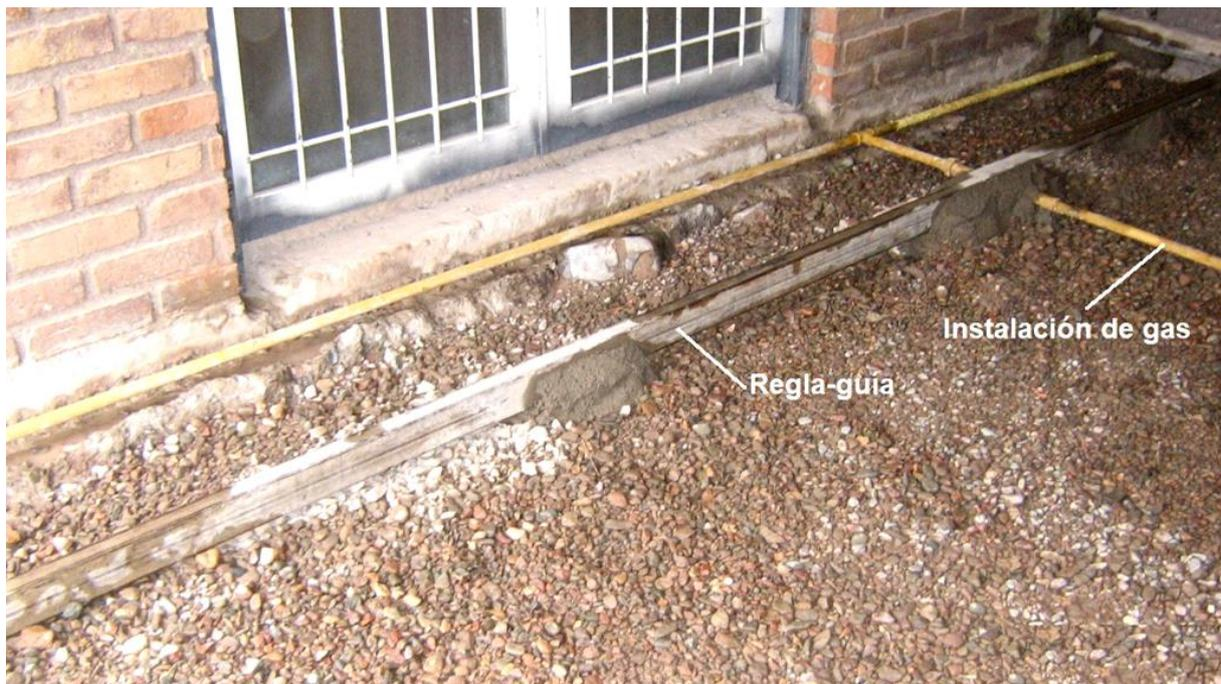
**Imagen 8.** Ejecución capa de ripio y colocación de reglas-guía.
