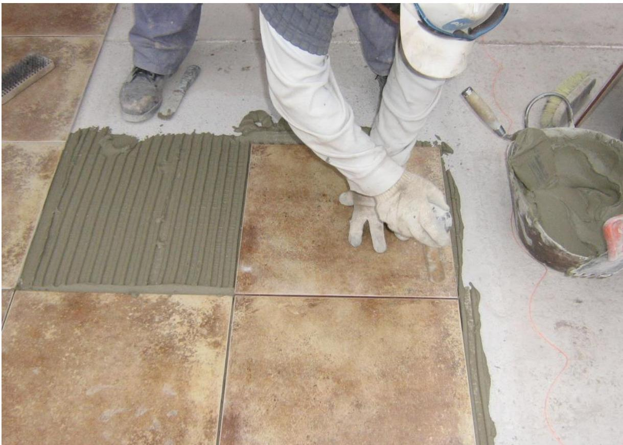
**Imagen 15.** Colocación de la pieza cerámica.
