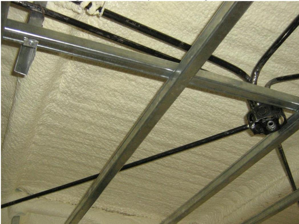
Imagen 19. Cielorraso suspendido con aislamiento de poliuretano en cubierta.
