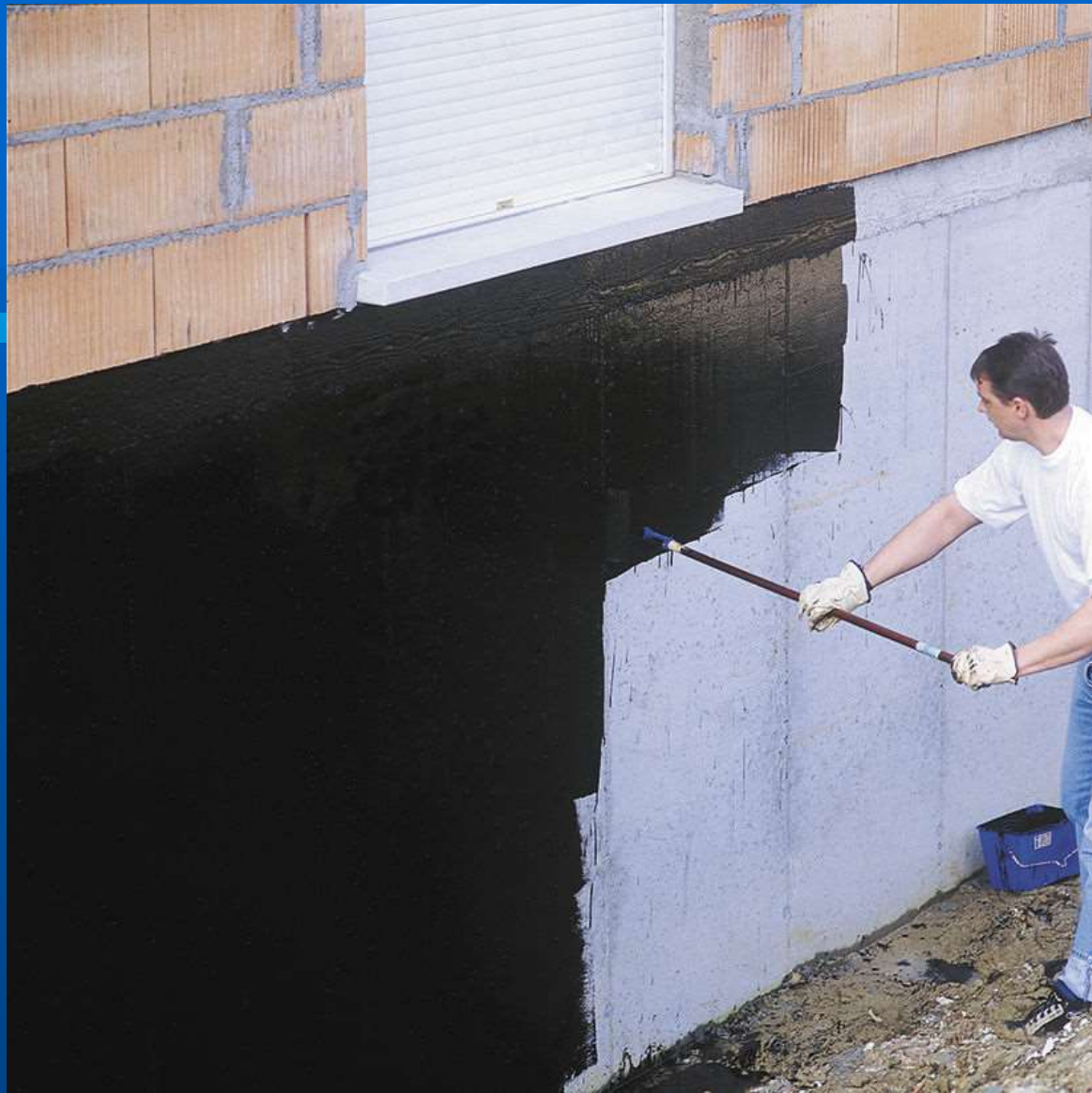
Aislación vertical en tabiques con pintura asfáltica
