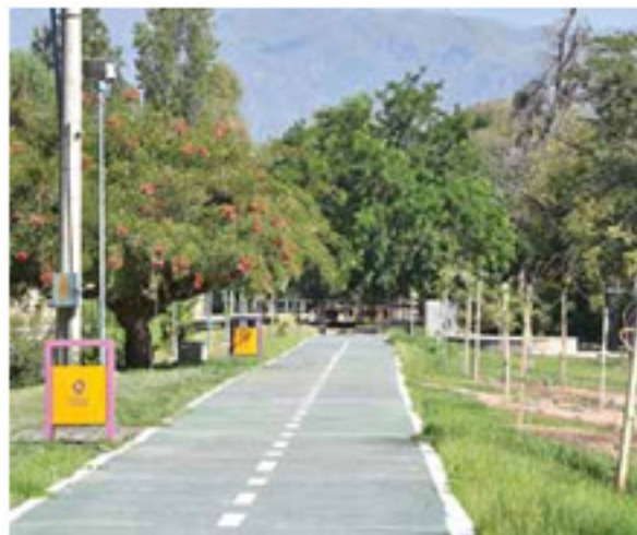
La ciclovia del canal Jarrafal fue una obra propuesta por los vecinos.
