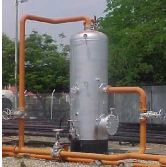
Figuras N° 23 y 24 Scrubber o knockout
