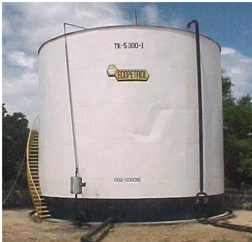
Foto N°8. Tanque de almacenamiento, hecho de acero.
