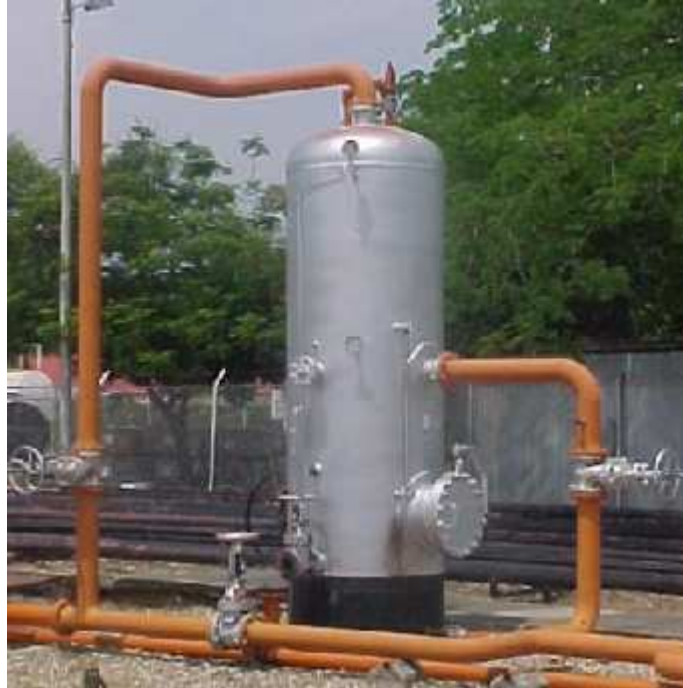
Figuras N° 23 y 24 Scrubber o knockout
