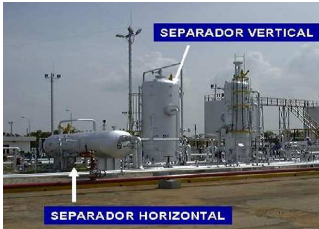
Foto N°2. Separadores Horizontales y Verticales
