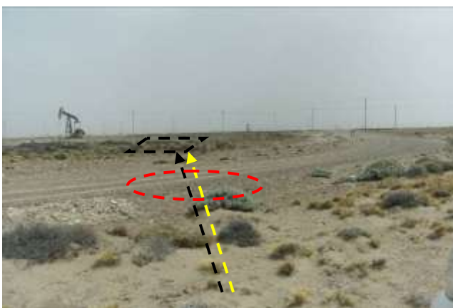
Foto III.B-21. Emplazamiento de ductos (oleoducto-negro- y gasoducto-amarillo), por huella cruce con camino (rojo). Futuro puente aéreo (negro). Foto en dirección O.
