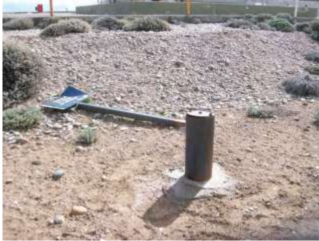
Foto IV.1-3. Freatímetro FBEAll-A, el mismo se ubica fuera del predio de la batería. El cartel identificador se encuentra dispuesto sobre el suelo.
