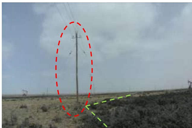
Foto III.B-11. Lateral E de ubicación (verde). SE observa Línea eléctrica (rojo) sobre vértice SE. Foto en dirección SO.
