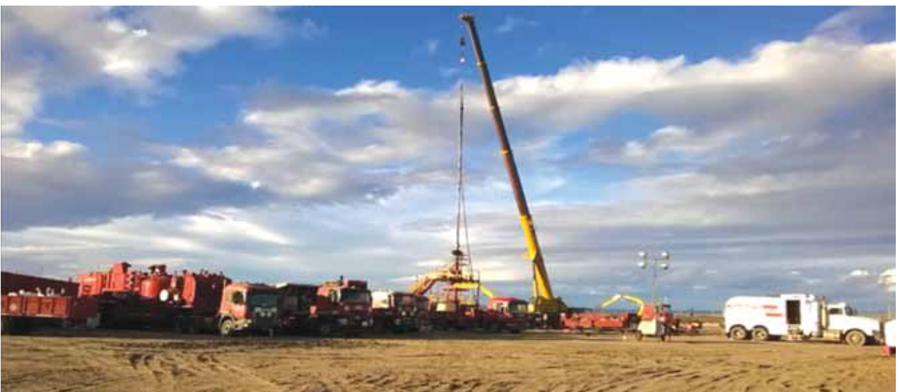
Figura 3. Operación de rigless .
