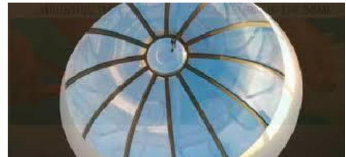
Extraordinaria transmisión de la luz y resistencia a la degradación ambiental; propiedades mecánicas regulares.
