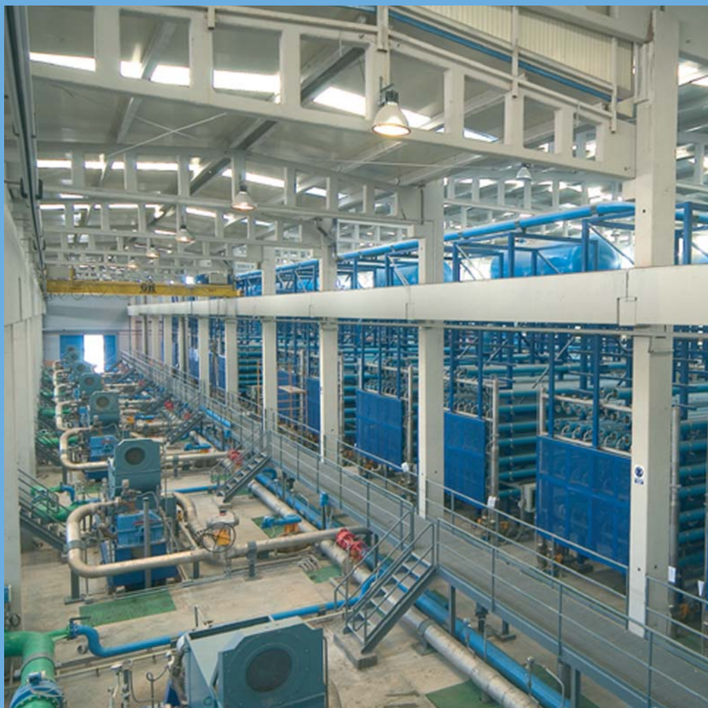
Figura 3.3. Planta desaladora de Carboneras (Almería), capaz de producir 120.000 m 3 /día de agua dulce. A la derecha, pueden verse los cientos de módulos que contienen las membranas enrolladas en espiral.
