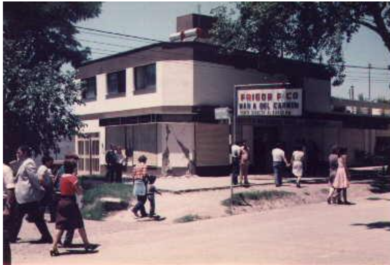
Figura 17: Daño en edificios en el terremoto de Mendoza de 1985
