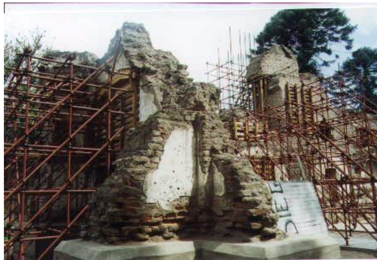
Figura 11: Ruinas de la iglesia de San Francisco luego del terremoto de 1861
