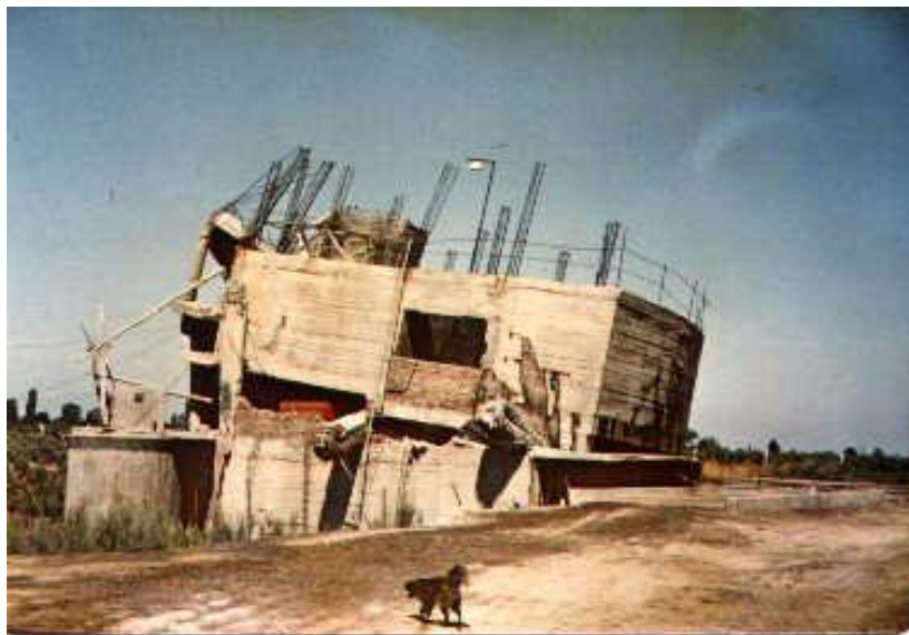
Figura 12: Daño causado por el terremoto de Caucete de 1977
