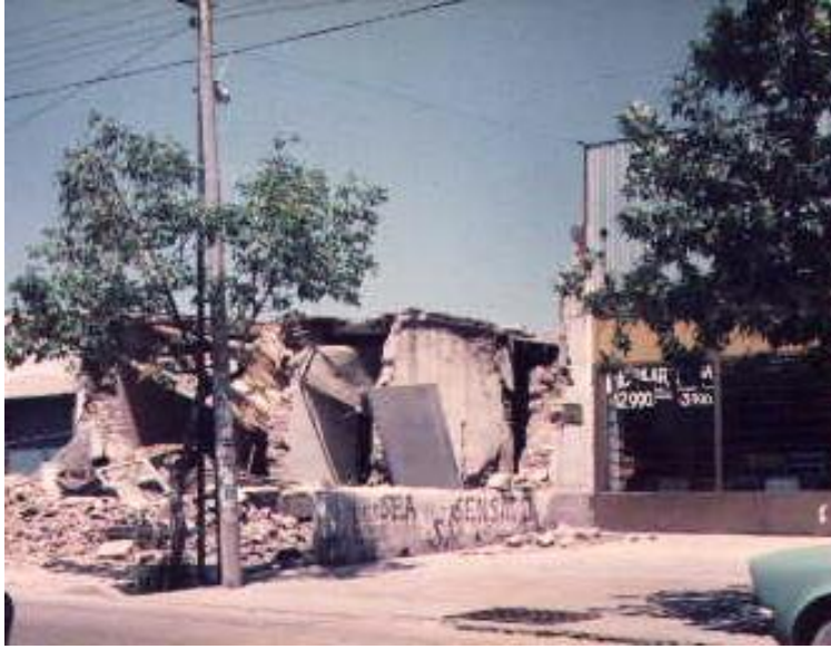
Figura 16: a) Daño en vivienda de adobe en el terremoto de Mendoza de 1985
