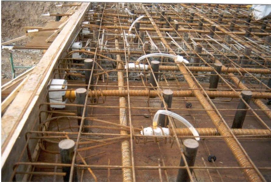
*Fig. 2.13.c-2. Vista de los Anclajes utilizados para la losa post-Comprimida del Laboratorio de Estructuras, IMERIS, de la Facultad de Ingeniería de la UNCuyo. Mendoza.*
