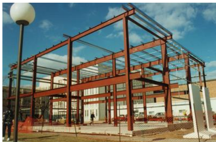
Fig 4. Pórtico de acero
