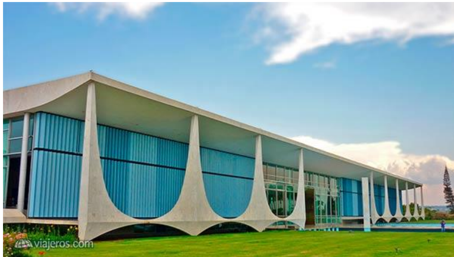
Fig 9. Pórtico de Hormigón Armado
