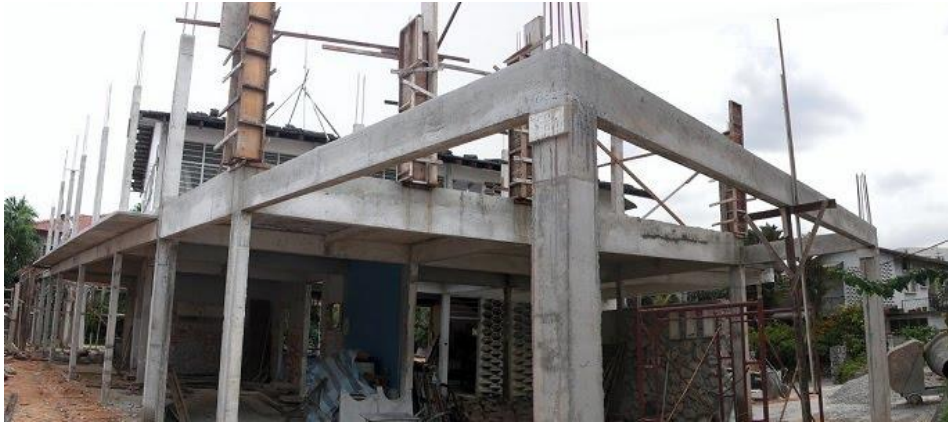
Fig 8. Pórtico de Hormigón Armado
