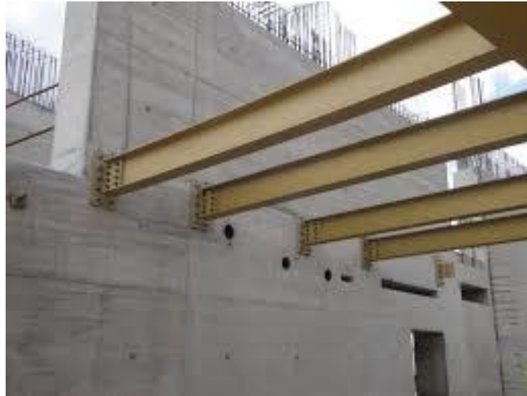
Fig 11. Pórtico mixto: Acero y Hormigón Armado
