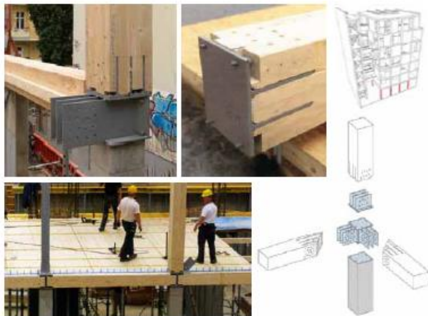
Fig 12. Pórtico mixto: Madera y Acero
