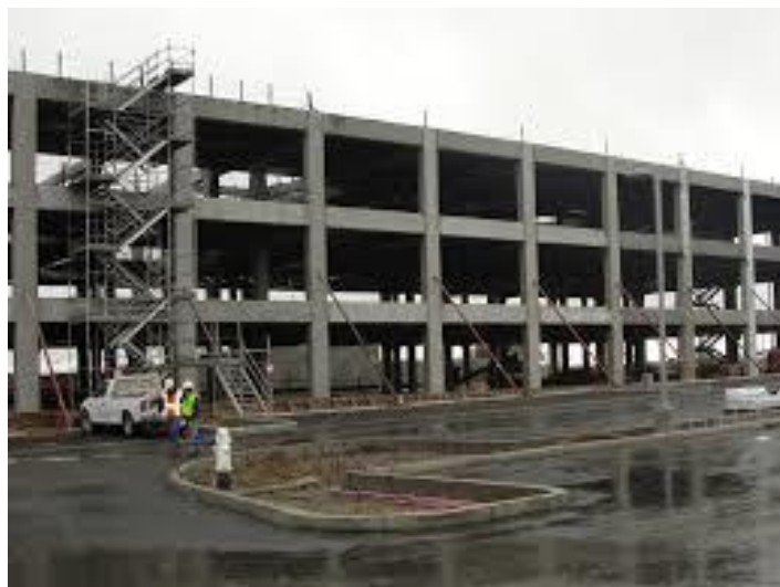
Fig 10. Pórtico de Hormigón Armado
