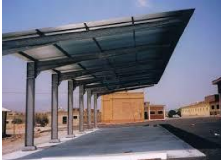
Fig 2. Pórtico de acero
