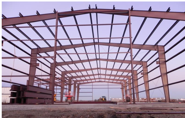
Fig 3. Pórtico de acero
