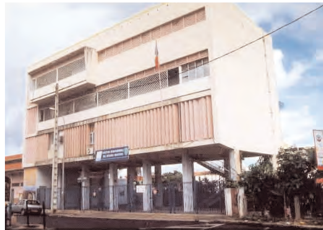
Fig. 2.104. - Disposition incorrecte des éléments rigides par rapport au centre de gravité des niveaux. Les murs formant les panneaux de contreventement du rez-de-chaussée étant décentrés, ces constructions peuvent être soumises par les séismes à une torsion importante.
