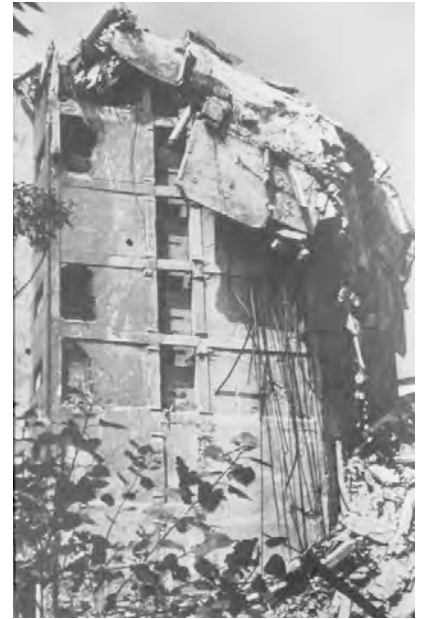
a) Bâtiment détruit lors du séisme du Mexique du 19.9.1985. Les niveaux supérieurs ont subi des amplitudes d'oscillation importantes
