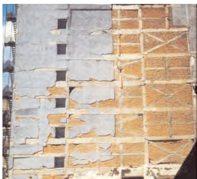
Fig. 2.53. - Bâtiments avec raidisseurs en béton armé dans des panneaux de remplissage en maçonnerie (Mexico). Ces ouvrages ont résisté au séisme du 19.9.1985.
