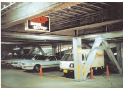
b) Palées à diagonales rigides, résistant à la traction et à la compression
