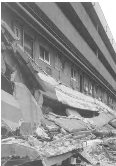
a) Effondrement de coursives en porte-à-faux (séisme de Kobé, Japon, 17.1.1995)
