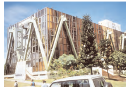
Fig. 2.102. - Une position décentrée des éléments de contreventement est à l'origine d'une sollicitation du bâtiment en torsion.
