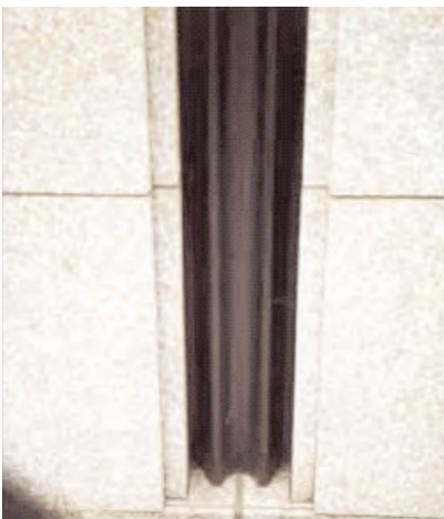
b) Couvre-joint en tôle pliée
