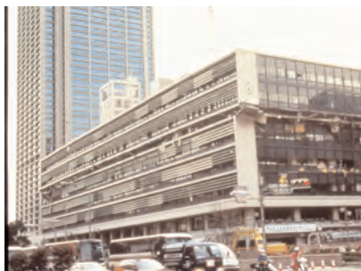
Fig. 2.84. - Rupture de poteaux hétérogènes.
