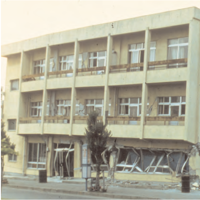
Fig. 2.103. - Dommages aux poteaux d'angle dus à la torsion induite par l'excentrement des murs de contreventement du rez-de-chaussée (séisme de Tokachi-Oki, Japon, 16.5.1968).
