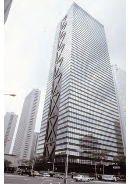
b) Compensation du manque de rigidité transversale d'un bâtiment par un contreventement renforcé (bâtiment Mitsui, Tokyo)
