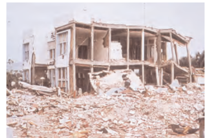
a) Destruction des panneaux de remplissage en maçonnerie. L'ossature est devenue instable (séisme d'El Asnam, Algérie, 10.10.1980)
