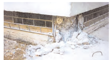
Fig. 2.58. - Dommages en soubassement dus à l'effet de poteau court (séisme de Ceyhan-Misis, Turquie, 27.6.1998).
