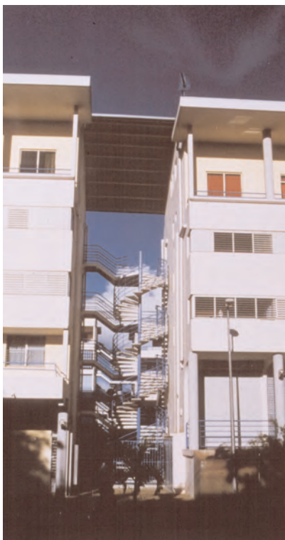
b) Escalier extérieur de 2 immeubles. Une structure autostable indépendante serait préférable
