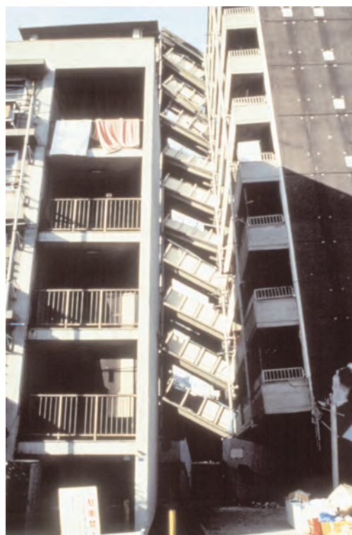
a) Destruction de passerelles due d'une part à des oscillations différentielles et, d'autre part aux dommages subis par le bâtiment de droite (séisme de Kobé, Japon, 17.1.1995)
