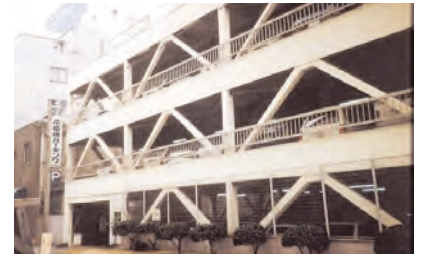
Fig. 2.101. - Façades formant éléments de contreventement.
