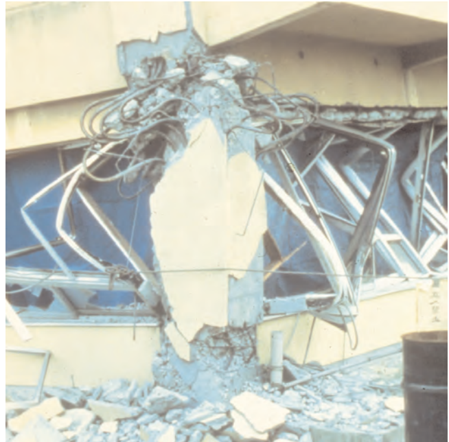
Fig. 2.103. - Dommages aux poteaux d'angle dus à la torsion induite par l'excentrement des murs de contreventement du rez-de-chaussée (séisme de Tokachi-Oki, Japon, 16.5.1968).
