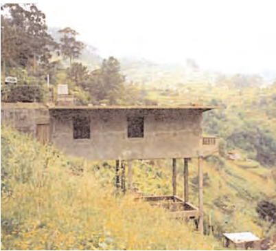
a) Construction typique aux Antilles. Ce type d'ouvrage est très vulnérable aux séismes car il est exposé à trois phénomènes destructeurs : niveau "souple", effet de poteau court (poteaux amont) et torsion d'axe vertical
