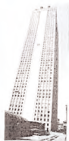
Immeuble Sunshine 60 à Tokyo
