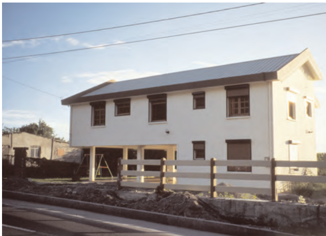
Fig. 2.104. - Disposition incorrecte des éléments rigides par rapport au centre de gravité des niveaux. Les murs formant les panneaux de contreventement du rez-de-chaussée étant décentrés, ces constructions peuvent être soumises par les séismes à une torsion importante.
