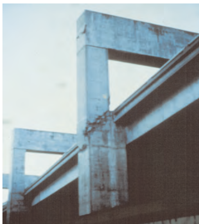
Fig. 2.68. - Poteaux de hauteur variable.
