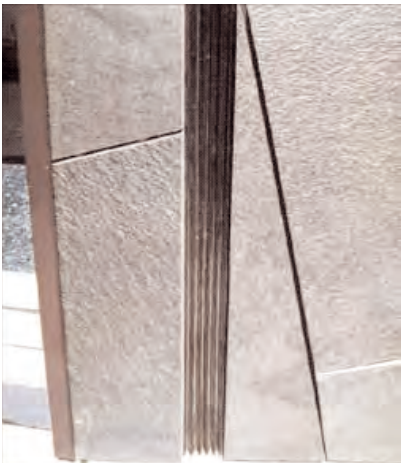
a) Couvre-joint à soufflet en caoutchouc
