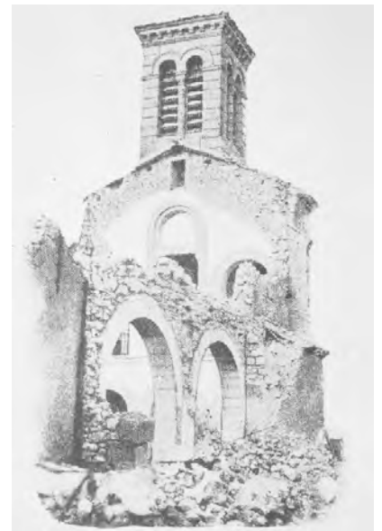
b) Eglise de Venelles, implantée sur un sol rocheux à courte période propre. Le corps de l'église, rigide, a subi la résonance avec le sol. Le clocher, plus flexible, a été moins sollicité. Il n'a pas subi de dommages bien qu'il soit moins résistant
