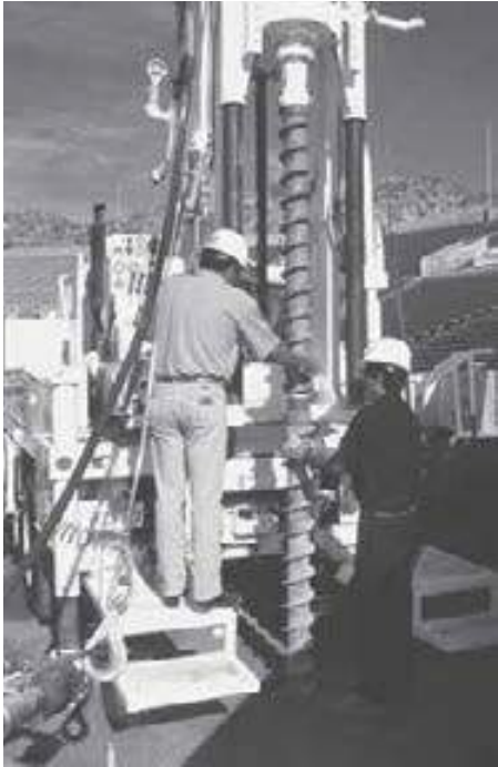
Figura 12.3 Perforación con barrenas de raspado continuo (Cortesía de Danny R. Anderson, PE de Professional Service Industries, Inc., El Paso, Texas)
