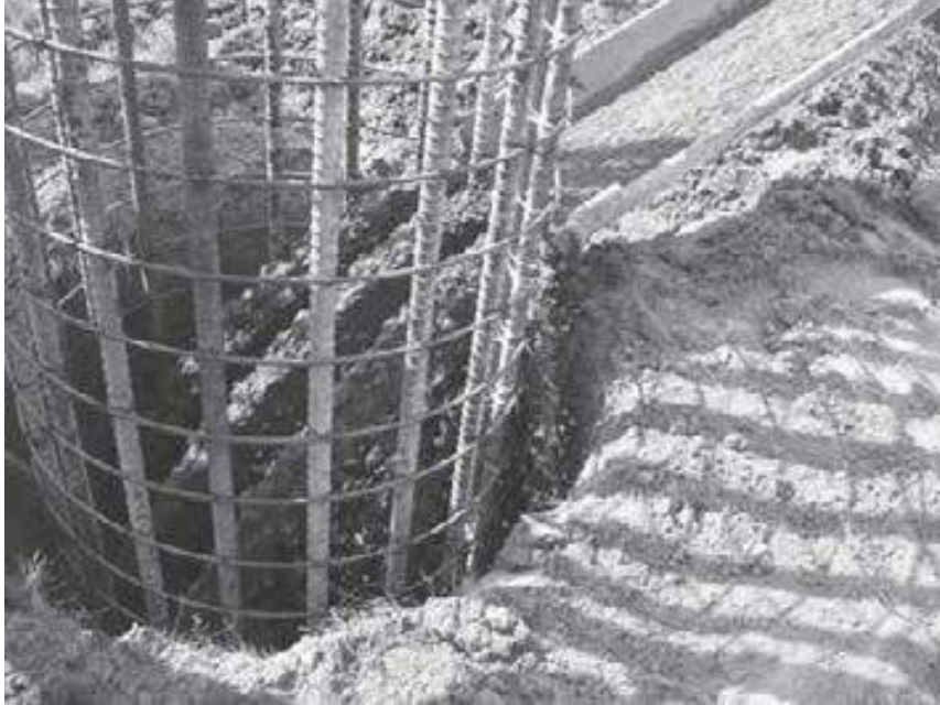
Figura 19.4 Vertido del concreto con la jaula de barras de refuerzo en su lugar (Cortesía de Anand J. Puppala, Universidad de Texas en Arlington, Arlington, Texas)
