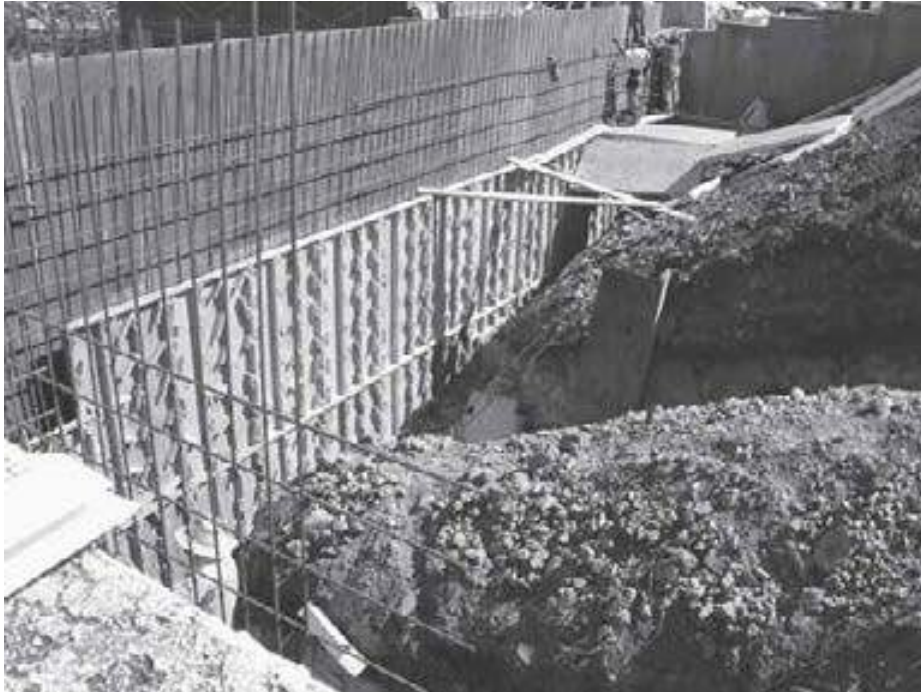
Figura 15.2 Construcción de un muro reforzado (Cortesía de Dharma Shakya, Geotechnical Solutions, Inc., Irvine, California)
