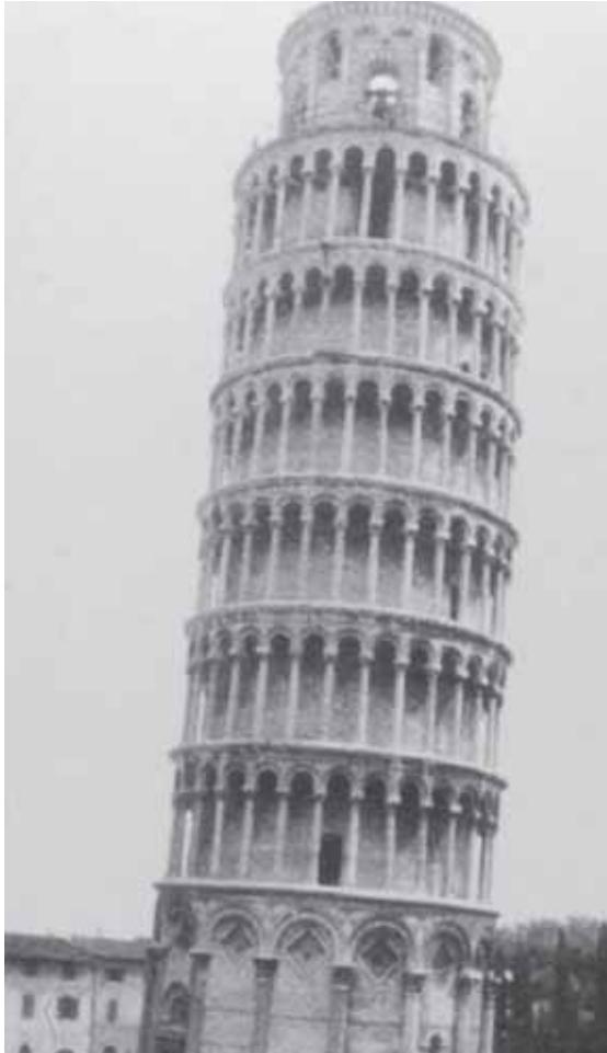
Figura 1.2 Torre inclinada de Pisa, Italia (Cortesía de Braja M. Das, Henderson, Nevada)
