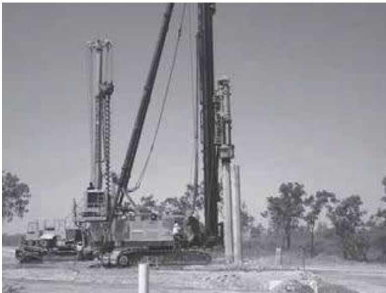
Figura 18.7 Operación de clavado de pilotes en campo (Cortesía de N. Sivakugan, James Cook University, Australia)
