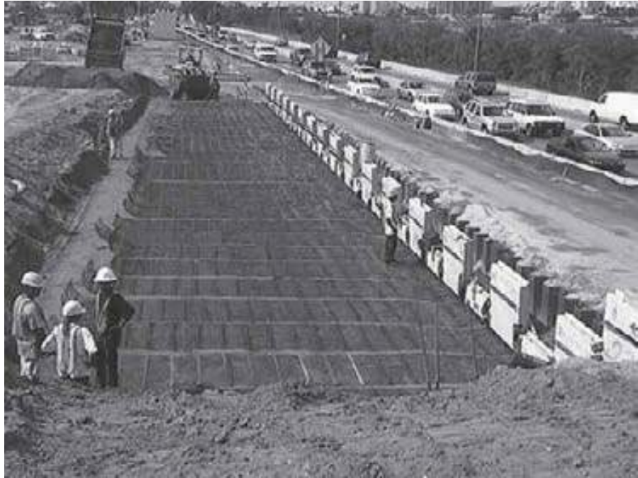
Figura 15.19 Construcción de un muro reforzado con geomalla HDPE revestido con paneles de concreto (Cortesía de Tensar International Corporation, Atlanta, Georgia)
