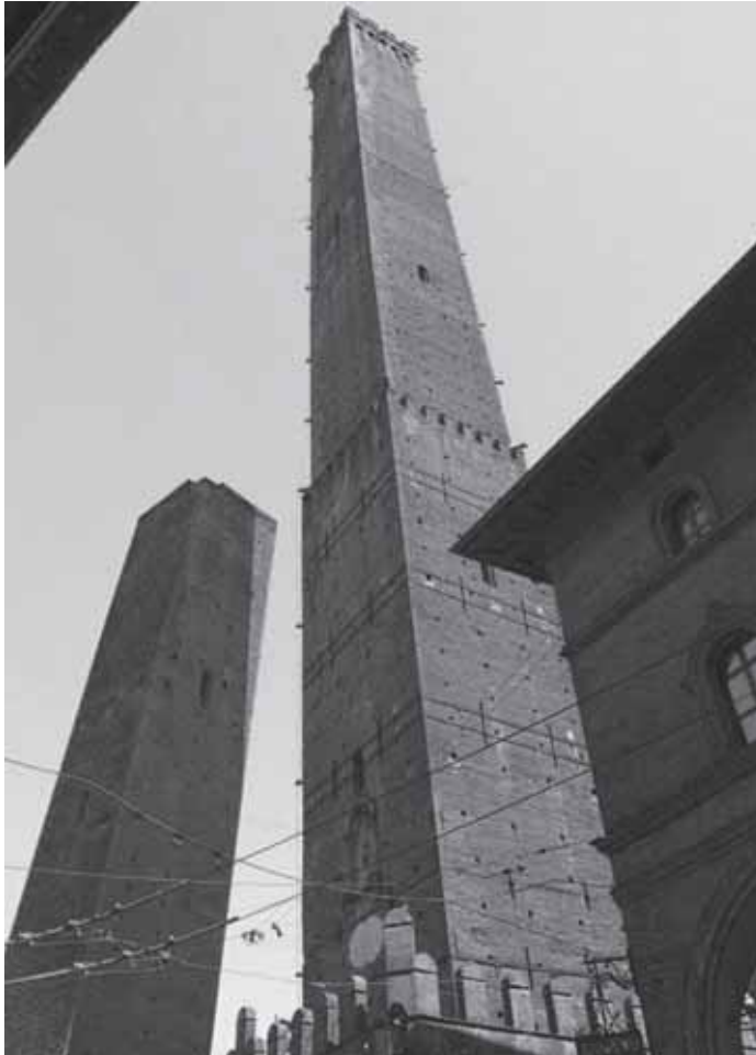
Figura 1.3 Inclinación de la Torre de Garisenda (izquierda) y la Torre Asinelli, en Bolonia, Italia (Cortesía de Braja M. Das, Henderson, Nevada)
