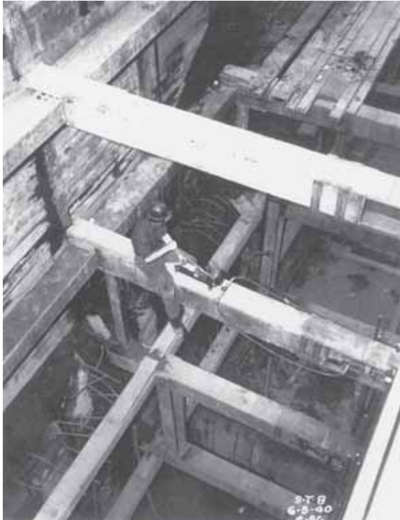
Figura 15.23 Corte apuntalado durante la construcción del metro de Chicago (Cortesía de Ralph P. Beck)
