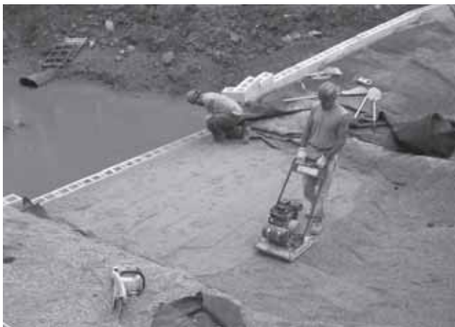
Figura 15.15 Construcción de un muro de contención reforzado con geotextil (Cortesía de Jonathan T. H. Wu, Universidad de Colorado en Denver, Denver, Colorado)
