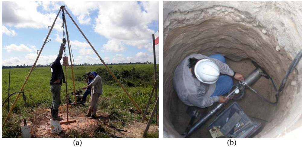
Figura 16. Ensayos de Campo (a) SPT. (b) Ensayo horizontal de placa
