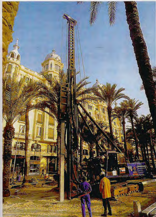
Figura 8.25 Hincas de pilotes prefabricados (cortesía de Grupo Terratest).
