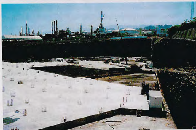
Figura 8.3 Construcción de una gran losa para la cimentación de un centro comercial en Santa Cruz de Tenerife (cortesía de E. García Rodríguez).
