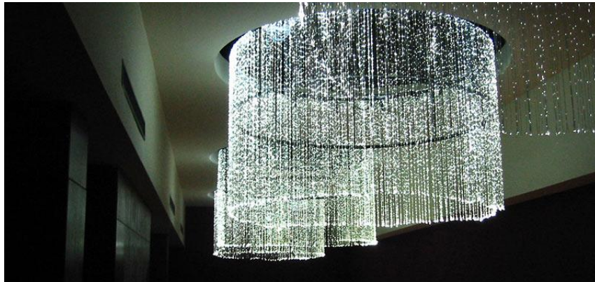
Iluminación con fibra óptica
