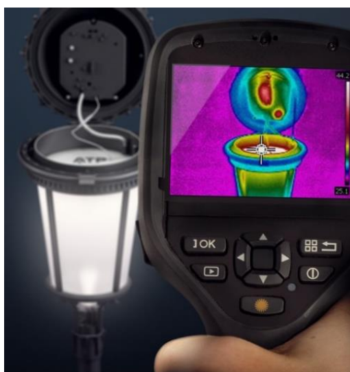
Medición de la radiación de calor de una luminaria led
