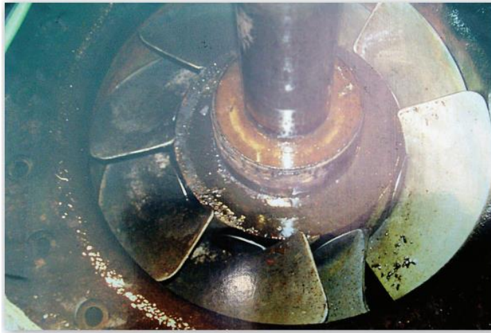
Vista superior del rodete de la turbina tipo Kaplan de la central Los Molinos II, en proceso de extracción por la rotura de uno de sus álabes.
