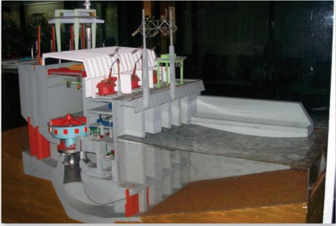
Vista de la maqueta del sector de la central. Pueden verse el edificio de la central, los transformadores, generador, turbina y los puentes grúa aguas arriba y abajo para la apertura de las compuertas y ataguías.
