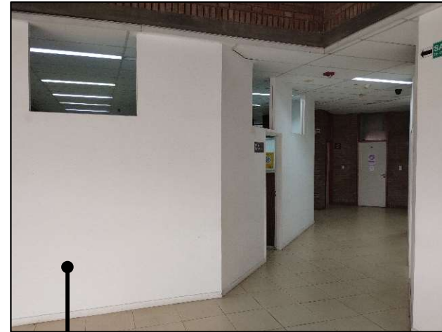
PAREDES DE DURLOCK AGREGADAS RECIENTEMENTE
