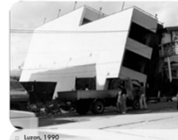
Falla en la capacidad de soporte
