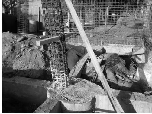
Figura 7.1: Columnas de hormigón armado
