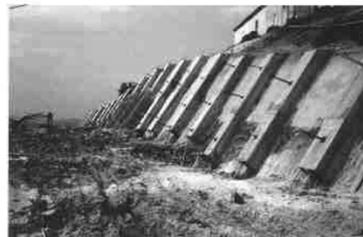
Figura 9.64. Instalación de anclajes para reforzar el talud, unidos mediante vigas de hormigón armado para que trabajen de forma solidaria, Asturias (foto L. González de Vallejo).
