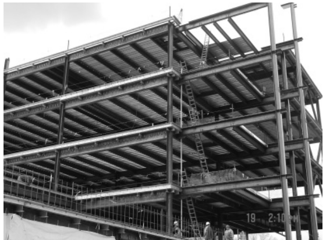
Sistema de piso de la escuela Glen Oaks, Bellerose, N. Y. (Cortesía de CMC South Carolina Steel.)
