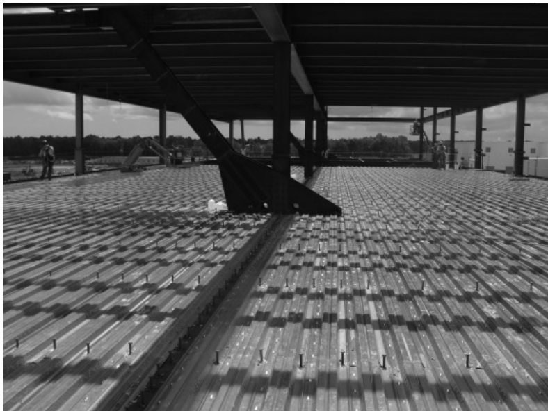
Sistema de piso compuesto, North Charleston, SC. (Cortesía de CMC South Carolina Steel.)
