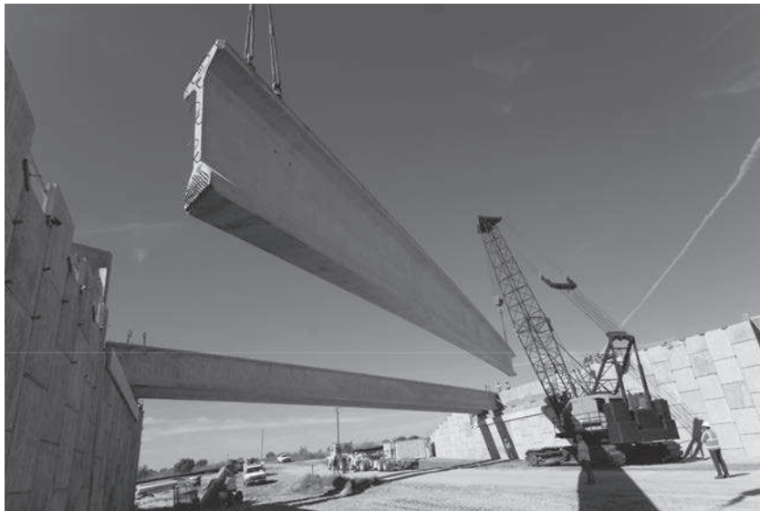
Trabes pretensadas para puente durante el montaje. (David Sailors/© Corbis.)
