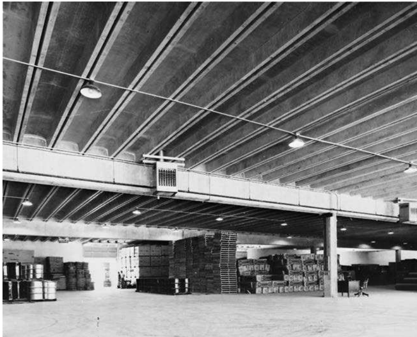
Canales de concreto presforzado, John A. Denies Son Company, Almacén # 4, Memphis, Tennessee. (Cortesía de BASF Corporation.)
