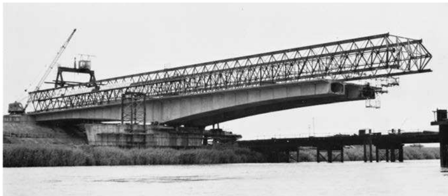
Puente construido con segmentos de concreto presforzado sobre el Río Trent, cerca de Scunthorpe, Lincolnshire, Inglaterra. (Cortesía de Cement and Concrete Association.)
