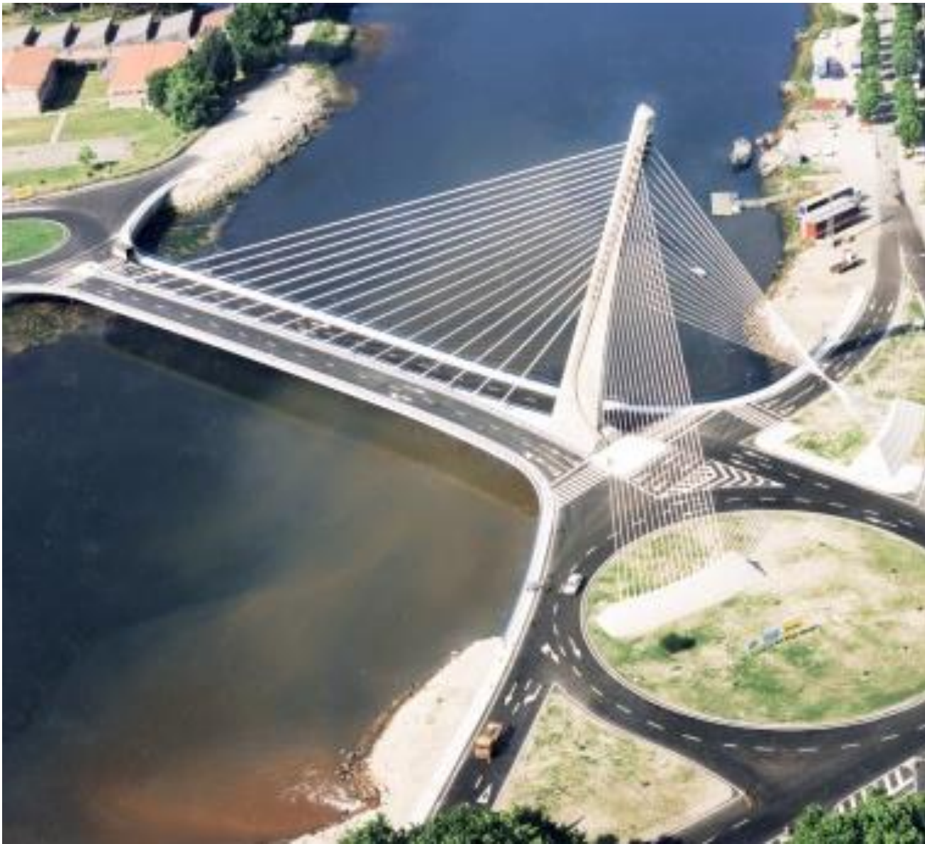
Puente sobre el río Lérez. Pontevedra. España. 1995. 42
