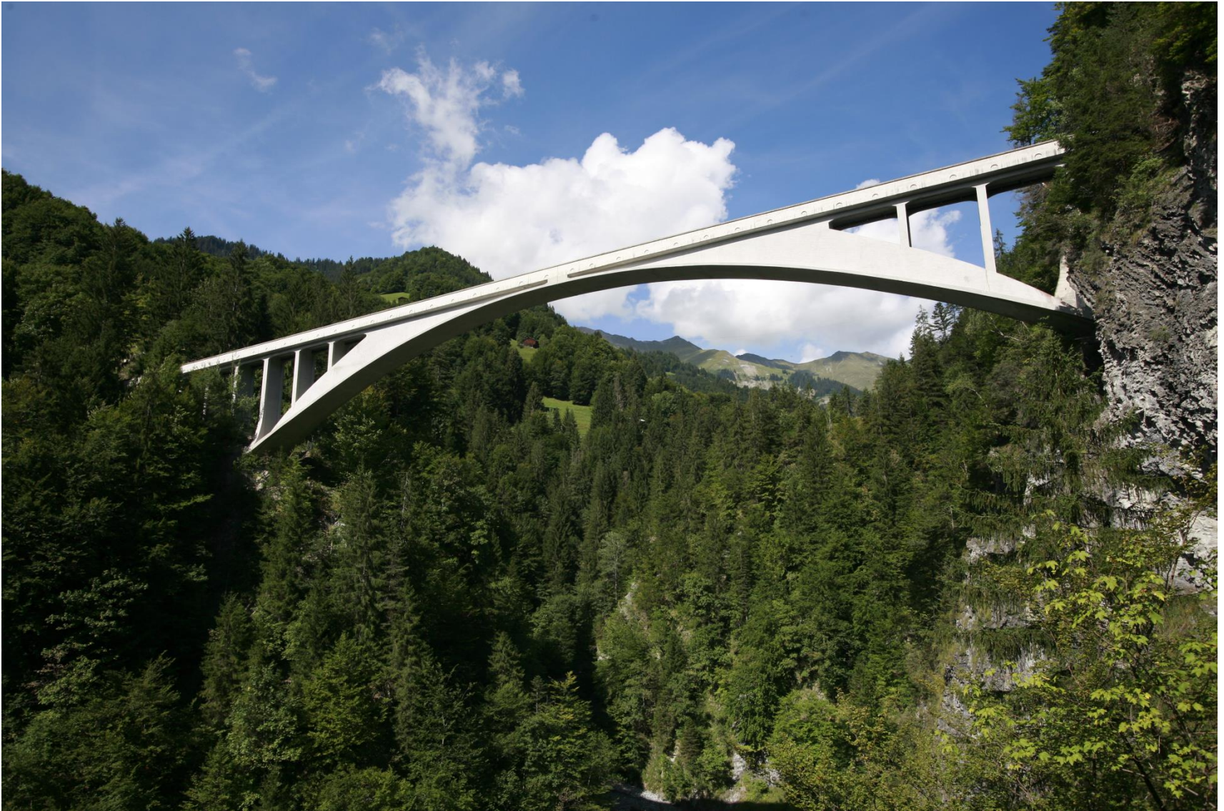
Puente Salginatobe, Suiza
