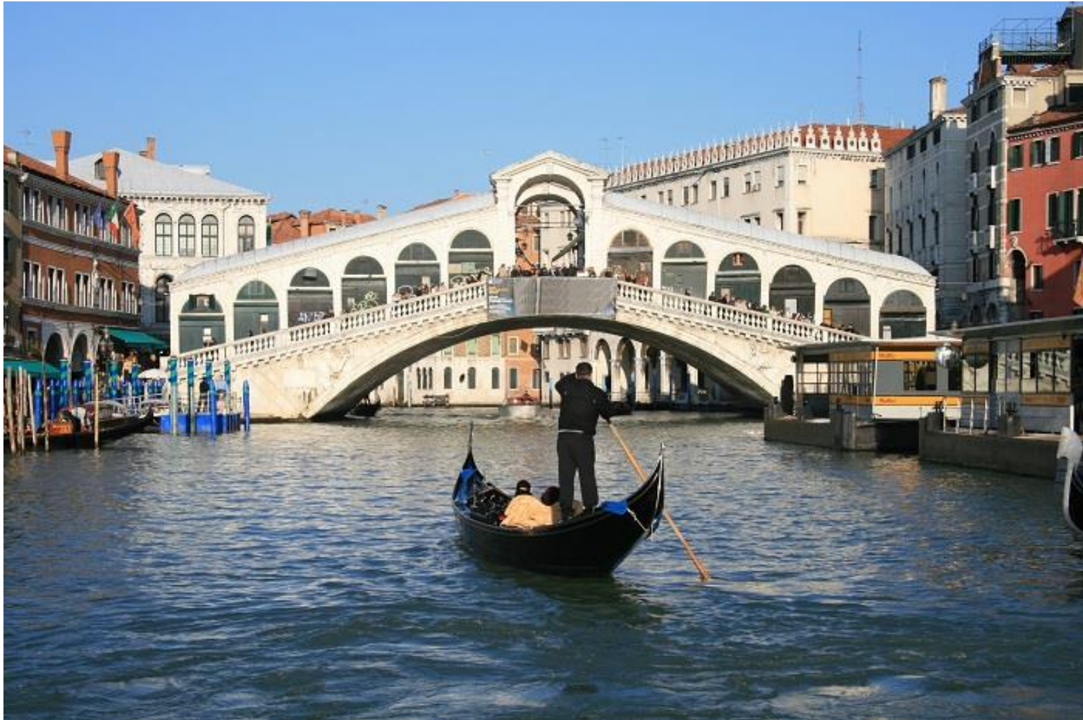
Puente Rialto, Venecia
