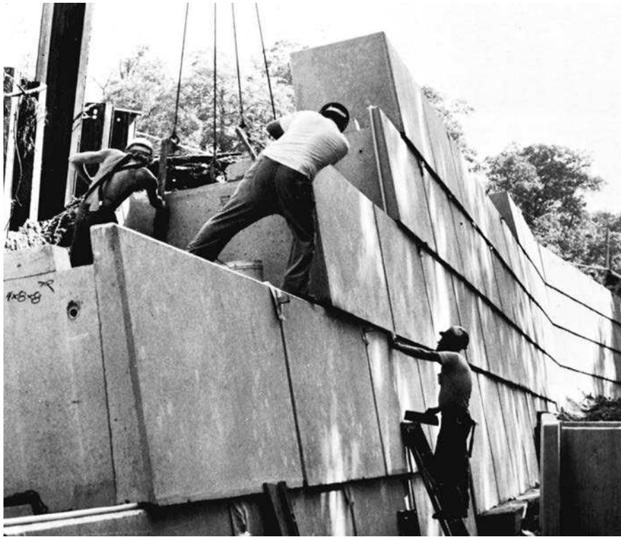
Muro de retención para el ferrocarril Long Island, Huntington, Nueva York. Construido con módulos interconectados de concreto reforzado precolados. (Cortesía de Doublewal-División de United Concrete.)
