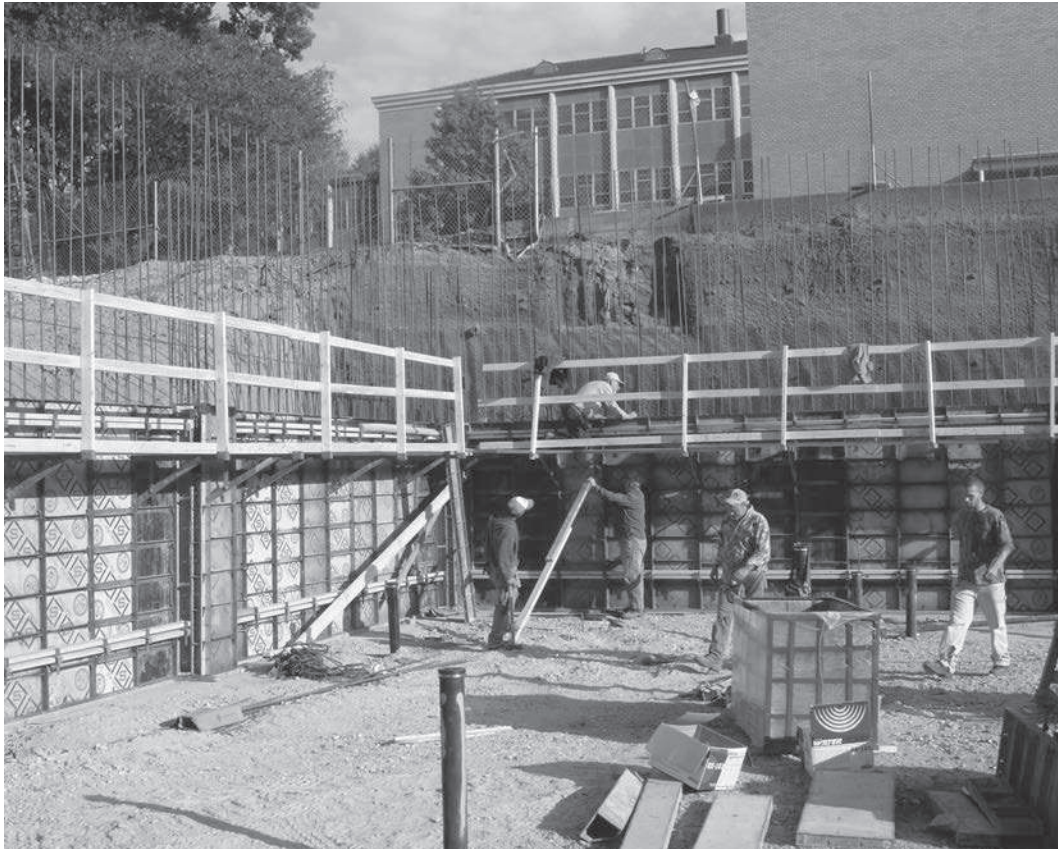
Muro de retención que muestra la cimbra que se está construyendo y el acero de refuerzo que se prolonga desde la parte superior (Anexo Rodas, Universidad Clemson)
