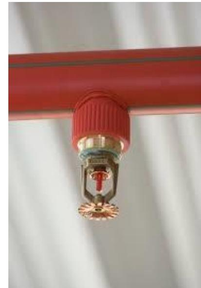
Los sistemas de tubería húmeda se utilizan normalmente en zonas de alojamientos y similares, donde materiales sólidos son los medios combustibles. Cuando la temperatura ambiente excede un límite determinado, el bulbo de activación en el nebulizador cerrado explota y el agua nebulizada se descarga por esa boquilla en particular
