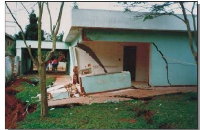
Figura 11. Daños por causa del colapso del suelo de fundación.
