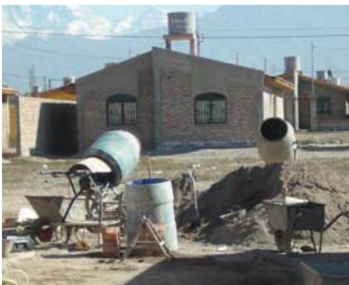
▲ Hormigón en obra
