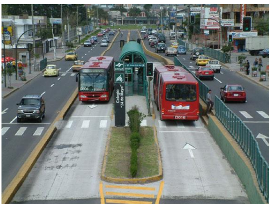
Fig. 4. Vía tipo B. Transmilenio. Colombia
