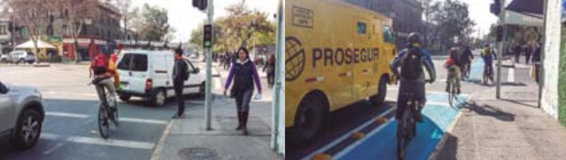
Situación antes y después de la intervención del cruce de la ciclovia de Av. Sta. Isabel con Vicuña Mackenna en Santiago de Chile, aplicando los nuevos criterios de diseño para intersecciones.
