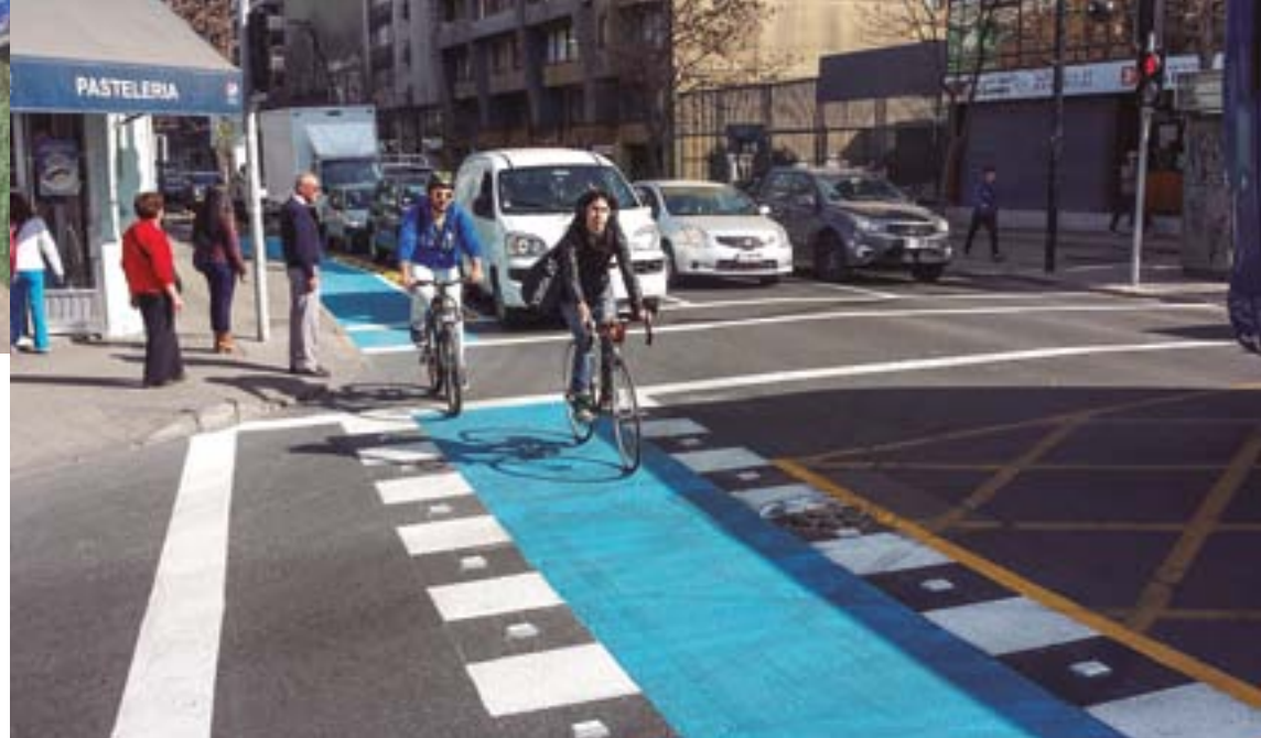
Intervención del cruce de la ciclovia de Av. Sta. Isabel con Vicuña Mackenna en Santiago de Chile aplicando los nuevos criterios de diseño para intersecciones. Trabajo conjunto entre UOCT RM, Municipio de Santiago y MINVU
