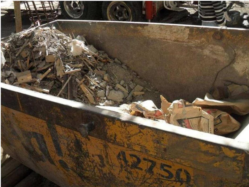
Figura 6: Almacenamiento de RCD inertes
