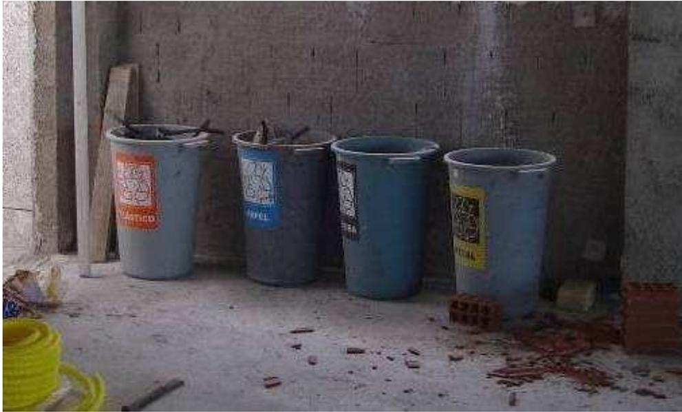
Figura 4: Pre- recogida selectiva de RCD en un edificio de varios pisos
