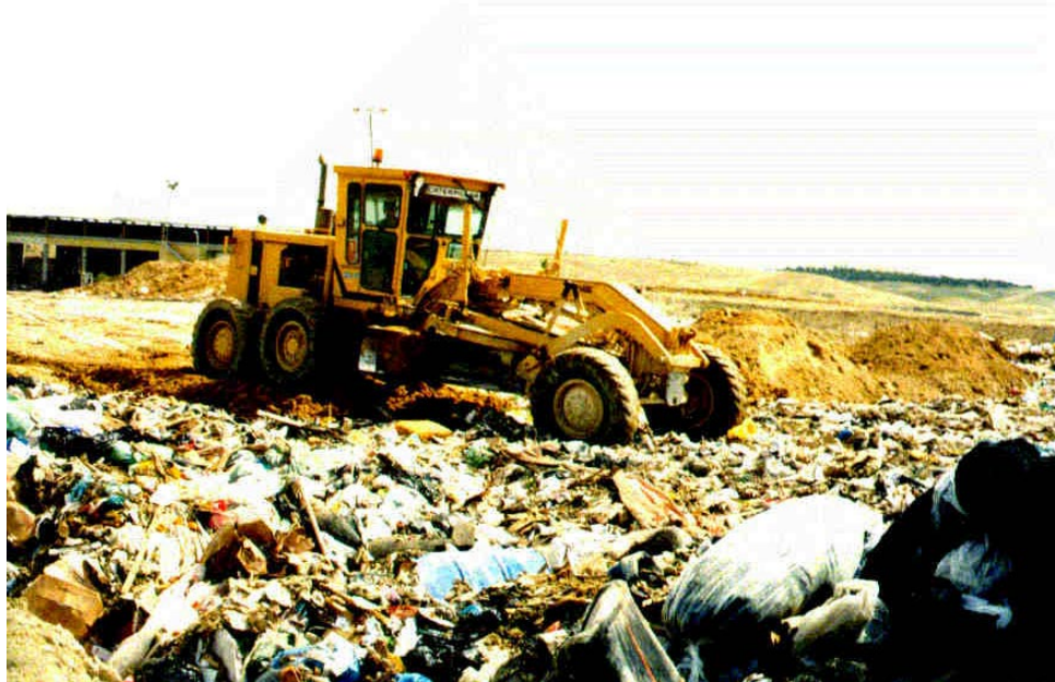
FOTO III.1 – Compactación de los residuos sólidos
