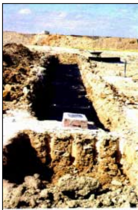
FOTO V.5 Esquema de instalación de la Línea Continua de Asientos
