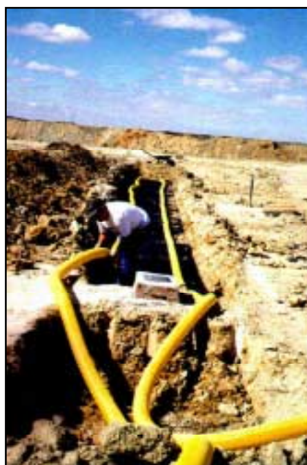
FOTO V.5 Esquema de instalación de la Línea Continua de Asientos
