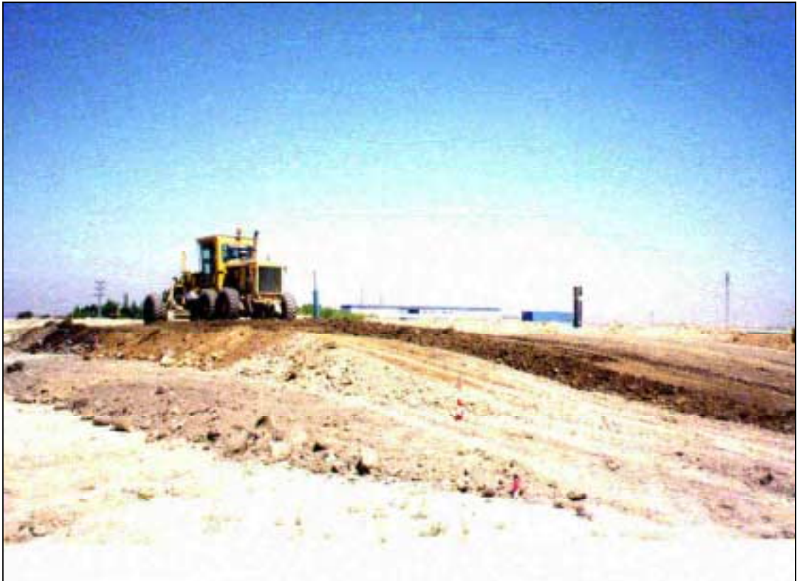
FOTO V.1 - Construcción del terraplén de carga
