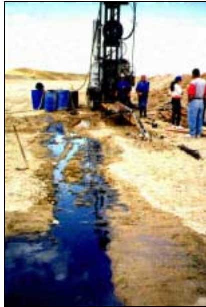
FOTO VI.4 – Líquidos lixiviados expelidos del sondeo S1
