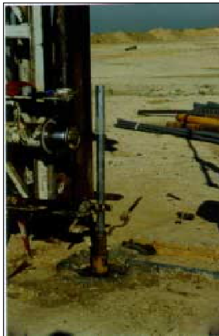
FOTO V.6 - Montaje del sistema inclinométrico
