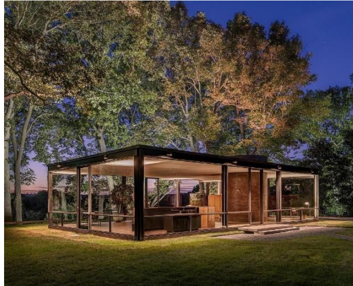
Obra: Glass House de Philip Johnson en New Canaan
