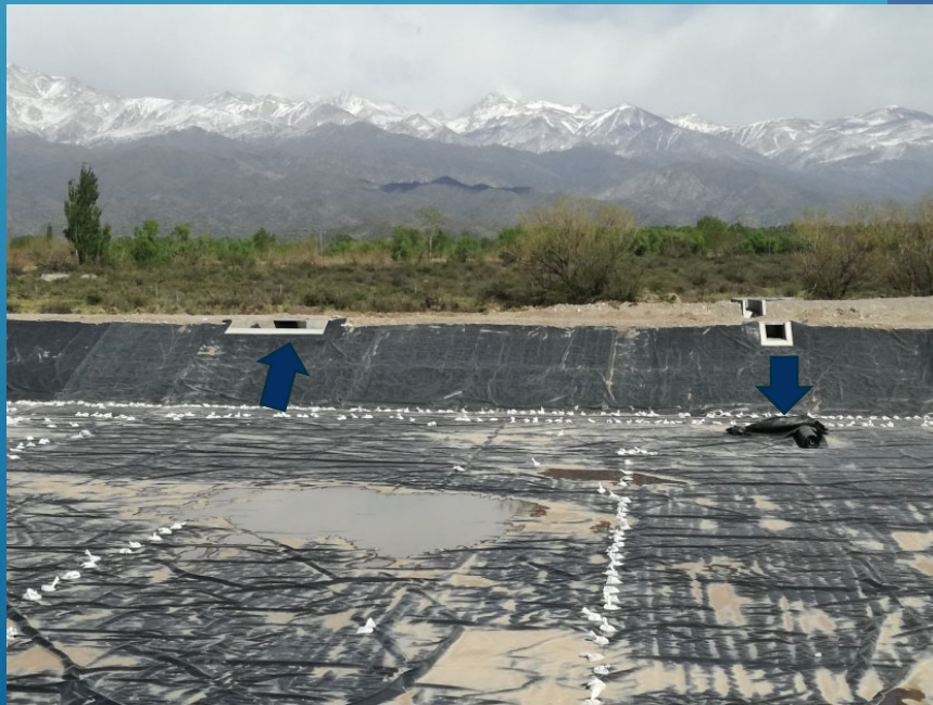
Ingreso y vertedero excedentes
